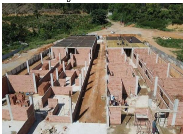
Construção da nova EMEIEF Santa Leopoldina
