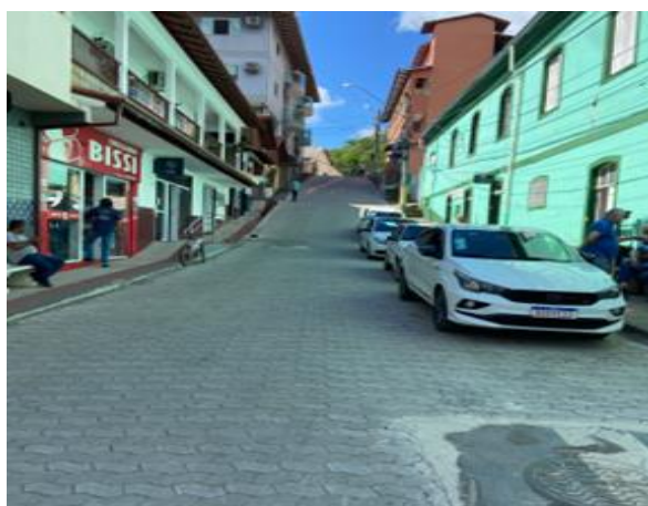
Pavimentação da Rua Cesar Muller - Centro
