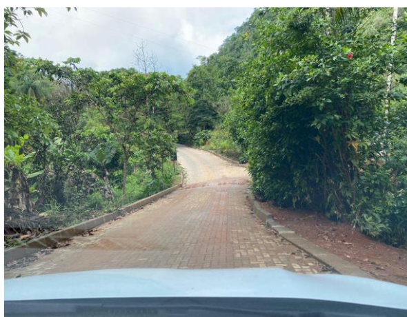
Calçamento Rural com materiais doados pelo Estado
