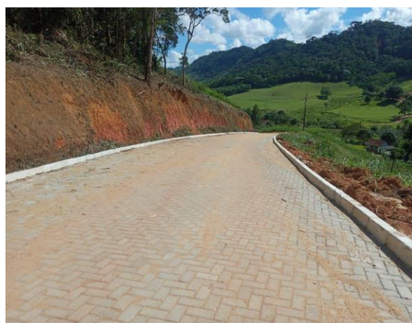
Calçamento Rural com materiais doados pelo Estado
