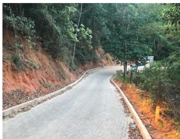
Piso Intertravado e Meio-fio
