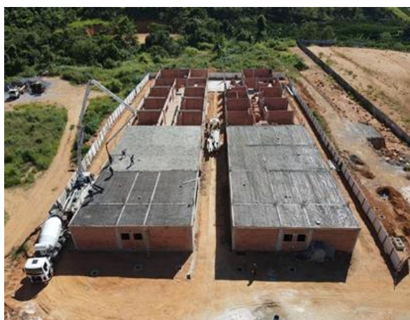
Construção da EMEIEF Santa Leopoldina
