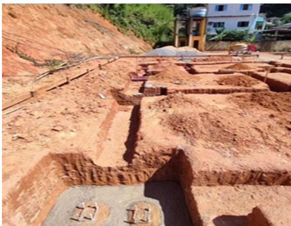
Obra da sede do Centro de Referência Especializado de Assistência Social (CREAS)
