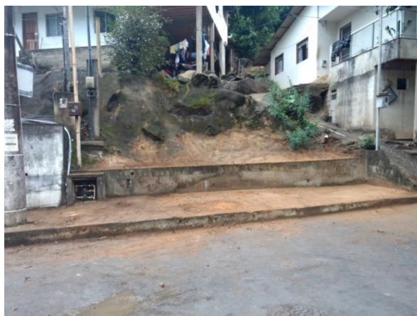
Muro de acesso à Comunidade do Funil - Restauração, pintura e paisagismo em execução
