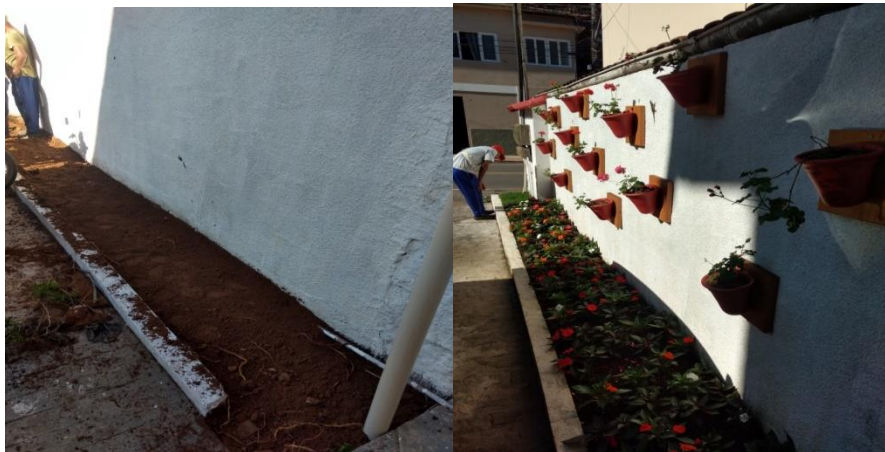
Canteiro Secretaria de Educação - Restauração, pintura e paisagismo
