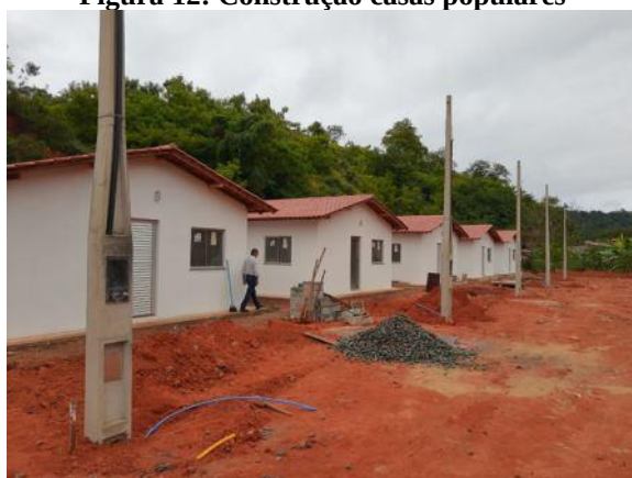
Figura 12: Construção casas populares
