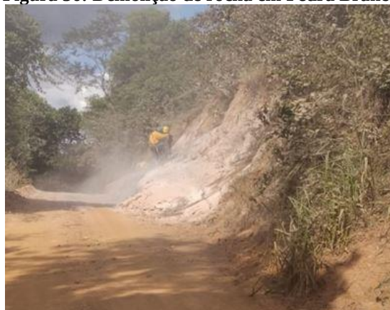
Figura 36: Demolição de rocha em Pedra Branca
