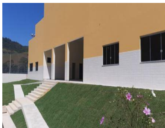
Figura 13: Construção da creche São Francisco
