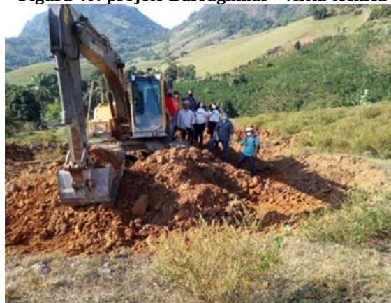
Figura 40: projeto Barraginhas - visita técnica
