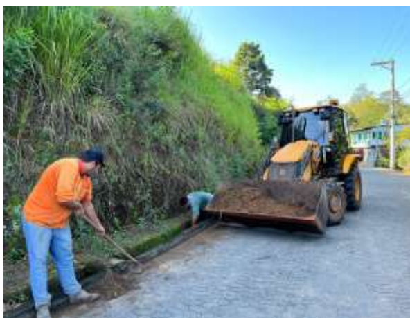
Limpeza de canaleta e lateral da rua
