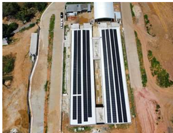
Vista aérea – Construção da EMEIEF Santa Leopoldina
