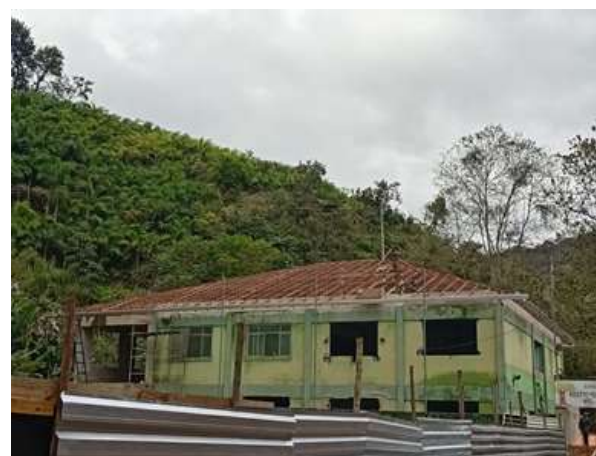
- Reforma e ampliação da Escola Alfredo Leppaus (Holanda)
