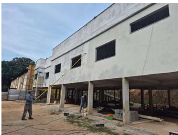
Construção do Centro de Referência Especializado de Assistência Social (CREAS)
