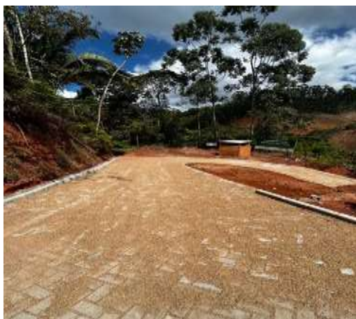
Pavimentação no Recanto do Tirol
