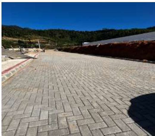
Pavimentação na Rua entre as escolas – Cocal
