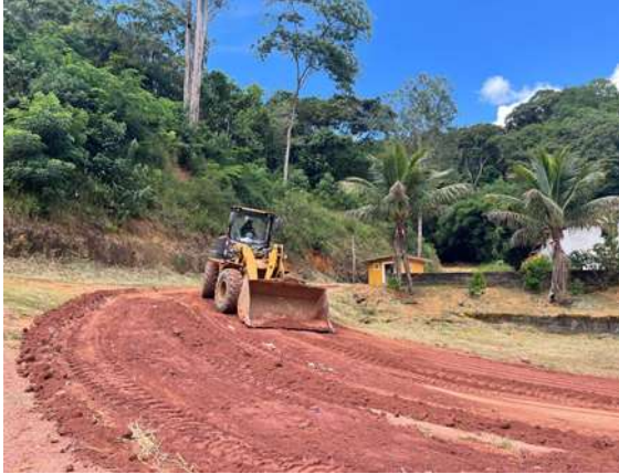
Nivelamento e Cascalhamento de estradas
