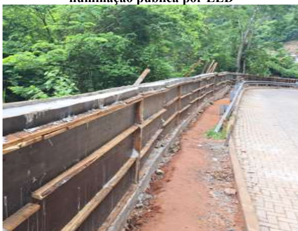
Construção de Encosta na Rua José Machado Alvarenga
