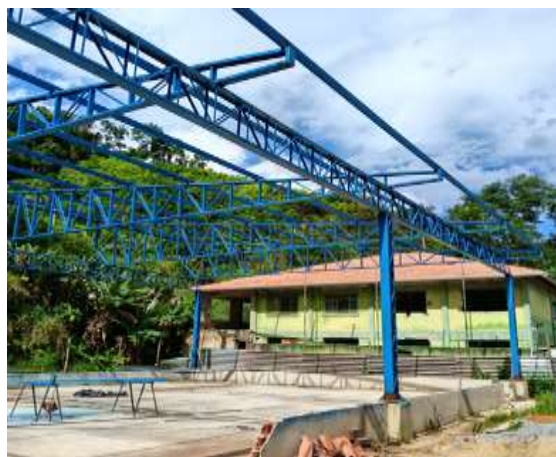
Construção da Quadra Poliesportiva na Escola Alfredo Leppaus (Holanda)
