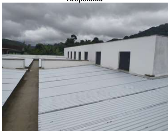
Construção da Unidade Básica de Saúde na Comunidade de Caramuru
