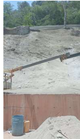
Muro de Contenção na rua José Machado Alvarenga.
