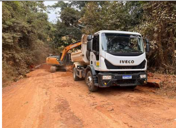
Manutenção de Bueiros
