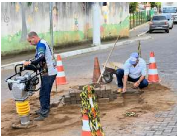
Limpeza e manutenção de galeria pluvial
