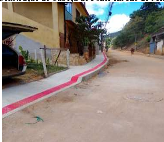
Pavimentação na Rua José Machado Alvarenga
