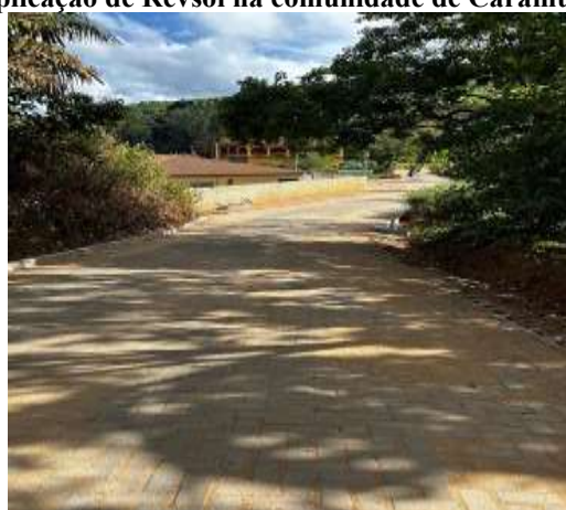
Pavimentação Caramuru Trecho I
