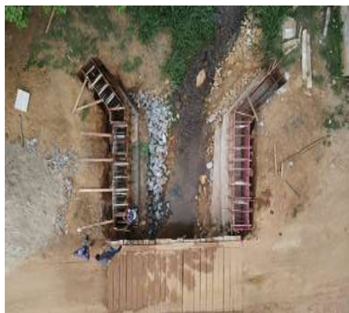
Construção de Cabeça de Ponte em Rio do Meio
