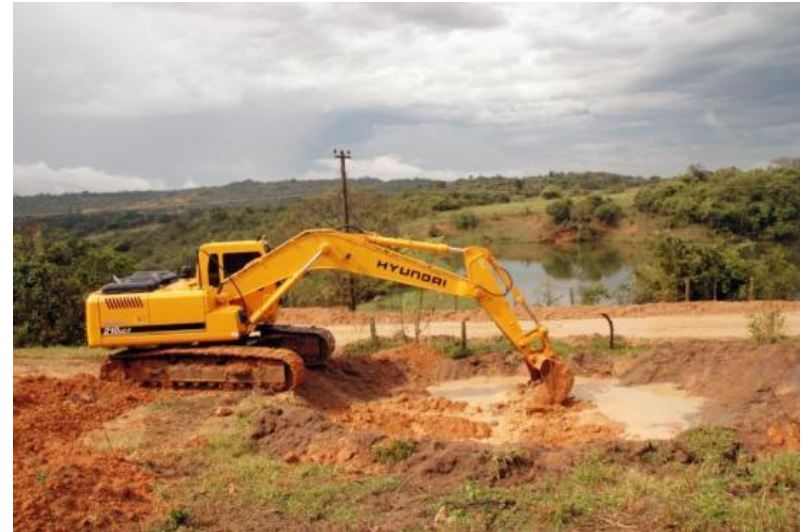
Bacias de contenção
