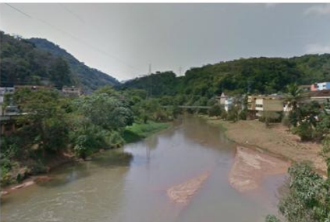
Figura 6-19: Início do trecho de escoamento em baixa declividade do Rio Santa Maria da Vitória, com vista a jusante da Ponte Paulo Médice. Santa Leopoldina-ES.
