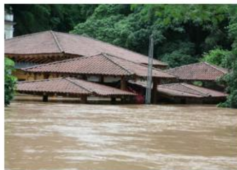
Figura 6-10: Inundação ocorrida em dezembro de 2013 em Santa Leopoldina-ES no bairro Centro – Posto de gasolina localizado no Centro de Santa Leopoldina (Fonte: Defesa Civil de Santa Leopoldina).
