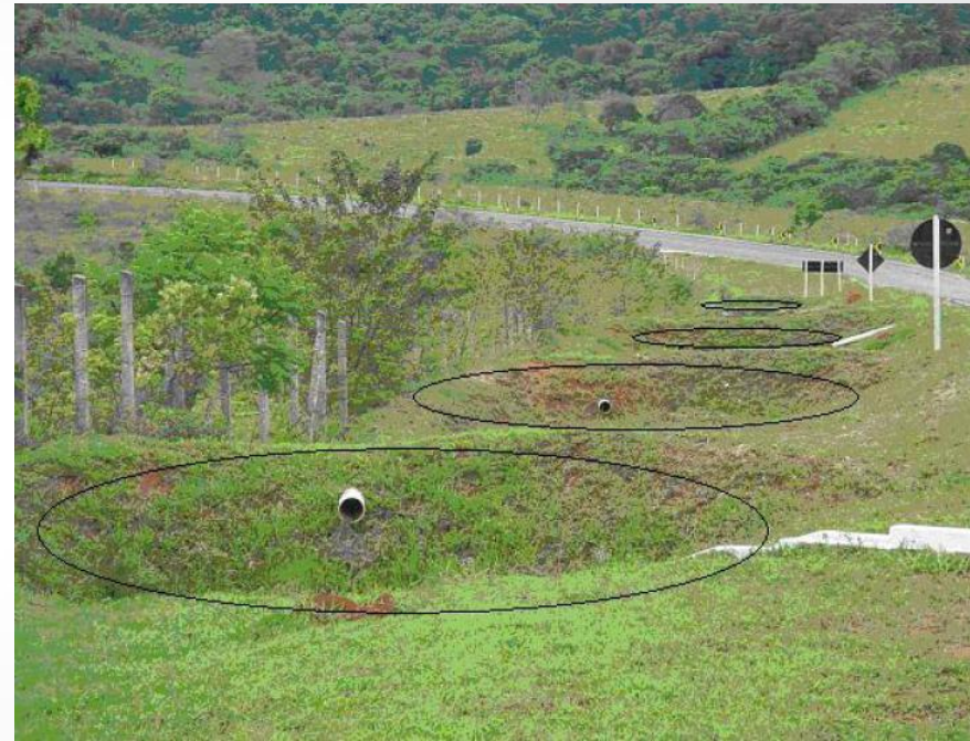
Bacias de contenção
