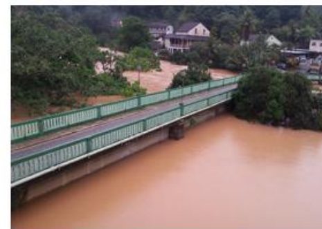
Figura 6-11: Inundação ocorrida em dezembro de 2013 em Santa Leopoldina-ES – Ponte Paulo Médice (Fonte: Defesa Civil de Santa Leopoldina).
