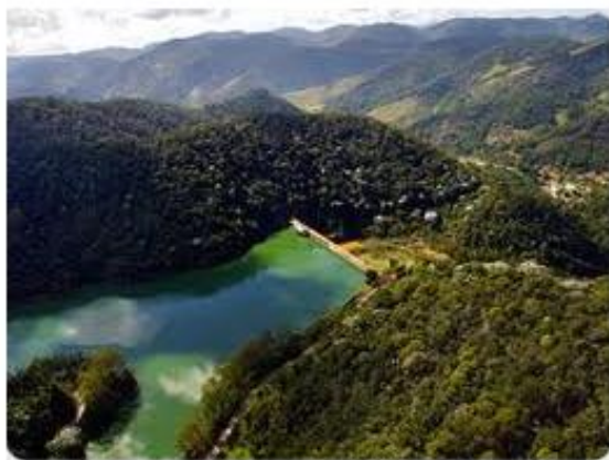
Figura 6-5: Barragem de Rio Bonito no Rio Santa Maria da Vitória, município de Santa Maria de Jetibá.
