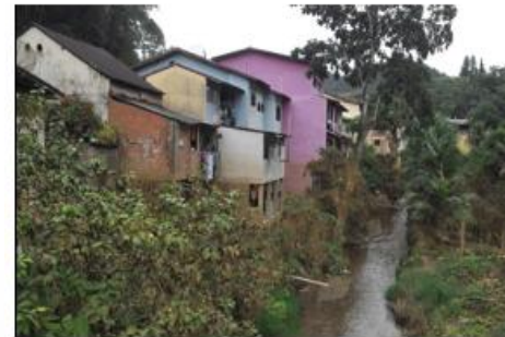
Figura 6-20: Avanço de edificações na margem do Ribeirão Crubixá-Mirim.
