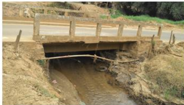
Figura 6-23: OAE da Rua José M. Alvarenga, no Bairro Centro de Santa Leopoldina.
