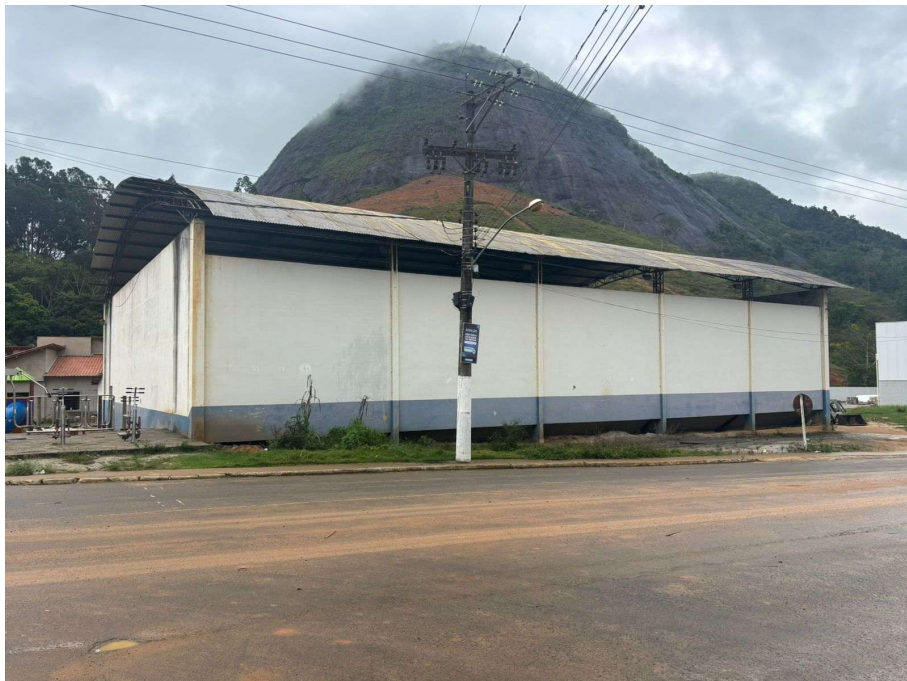
Figura 2: Vista frontal da quadra.
