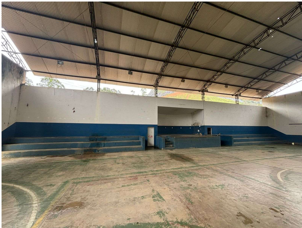
Figura 6: Vista interna da quadra.
