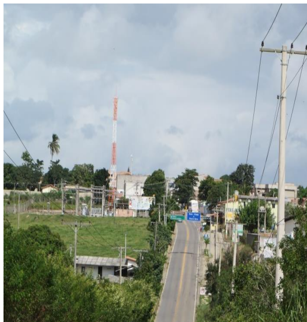
Figura 4: Vista geral da cidade de Ponto Belo, evidenciando relevo suave.
