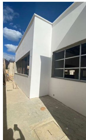
APLICAÇÃO MANUAL DE MASSA ACRILICA EM PANOS DE FACHADA SEM PRESENÇA DE VÃOS.
