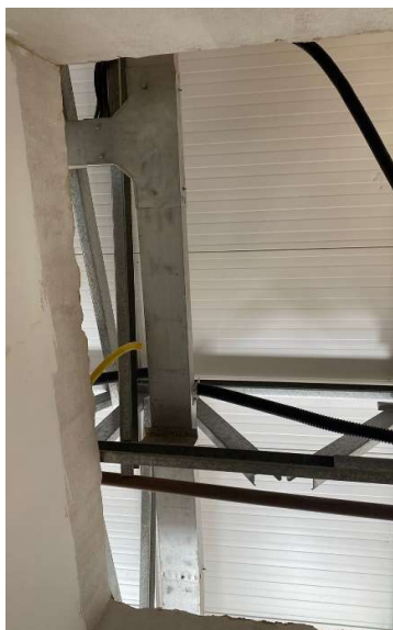
ELETROCALHA LISA TIPO U 150X75MM - ÁREA DO BLOCO A
