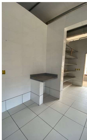
BANCADA DE GRANITO COM ESPESSURA DE 2 CM - ÁREA COZINHA
