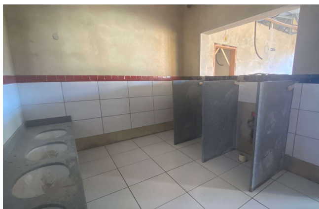
DIVISÓRIA DE GRANITO COM 3 CM DE ESPESSURA, ASSENTADA COM ARGAMASSA DE CIMENTO E AREIA NO TRAÇO 1:3, NA COR CINZA. ÁREA SANITÁRIO INFANTIL 2, BLOCO B.
