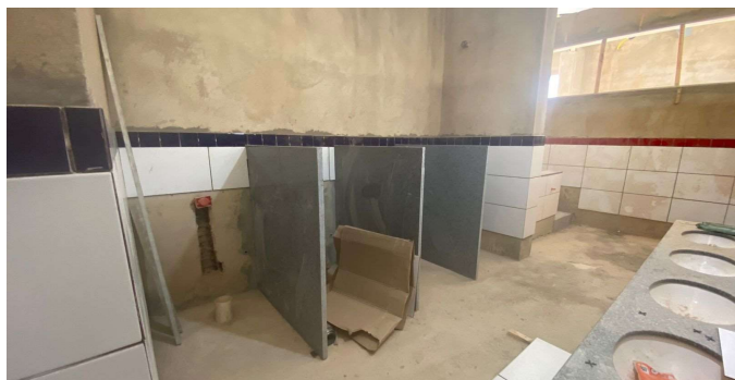
REVESTIMENTO CERÂMICO DE PAREDES PEI IV, CERÂMICA 30 X 40 CM, COR BRANCA. REVESTIMENTO CERÂMICO DE PAREDES PEI IV, CERÂMICA 10 X 10 CM, COR VERMELHA. REVESTIMENTO CERÂMICO DE PAREDES PEI IV, CERÂMICA 10 X 10 CM, COR AZUL.
