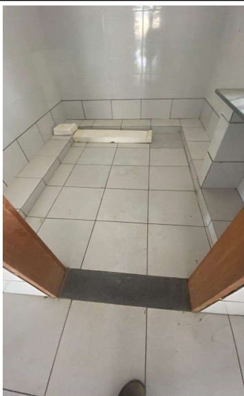
PISO CERÂMICO ANTIDERRAPANTE PEI V - 40 X 40 CM, E SOLEIRA EM GRANITO, LARGURA 15 CM, ESPESSURA 2,0 CM, ÁREA ROUPARIA.
