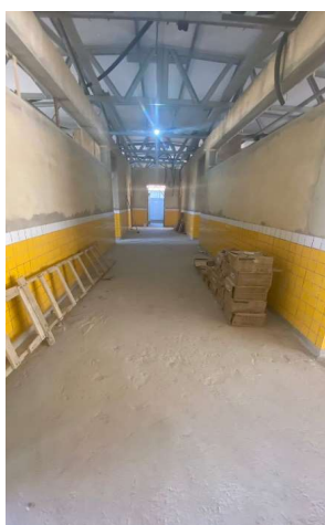
REVESTIMENTO CERÂMICO DE PAREDES PEI IV, CERÂMICA 10 X 10 CM, COR BRANCA.
