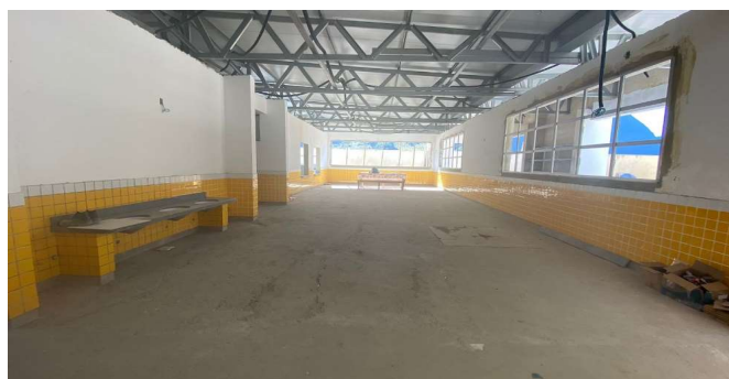
REVESTIMENTO CERÂMICO DE PAREDES PEI IV, CERÂMICA 10 X 10 CM, COR BRANCA.
