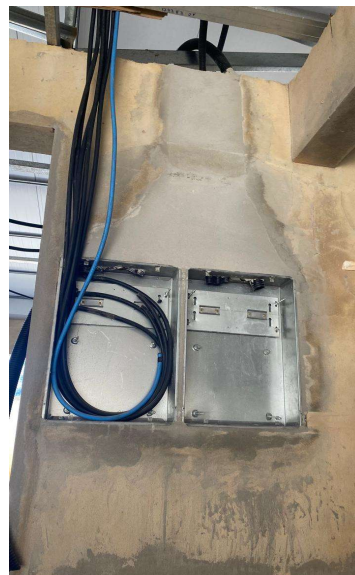
QUADRO DE DISTRIBUIÇÃO DE ENERGIA, DE EMBUTIR, COM 24 DIVISÕES MODULARES, COM BARRAMENTO - QD6 E QD7
