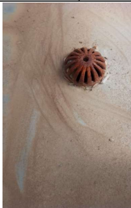
RALO HEMISFÉRICO (FORMATO ABACAXI) DE FERRO FUNDIDO, Ø100MM.
