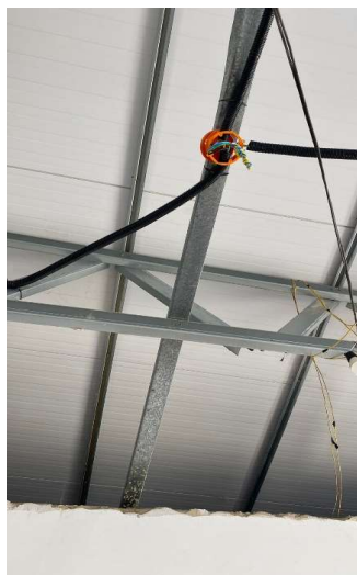
CABO DE COBRE FLEXIVEL ISOLADO, ANTI-CHAMA 450/750 V, PARA CIRCUITOS TERMINAIS
