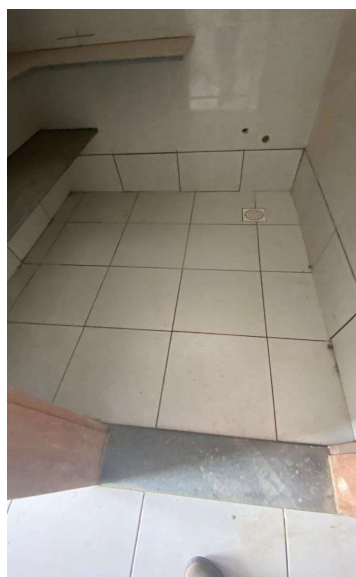
PISO CERÂMICO ANTIDERRAPANTE PEI V - 40 X 40 CM, E SOLEIRA EM GRANITO, LARGURA 15 CM, ESPESSURA 2,0 CM, ÁREA DML.
