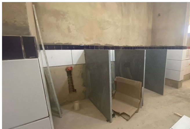
DIVISÓRIA DE GRANITO COM 3 CM DE ESPESSURA, ASSENTADA COM ARGAMASSA DE CIMENTO E AREIA NO TRAÇO 1:3, NA COR CINZA. ÁREA SANITÁRIO INFANTIL 3, BLOCO B.
