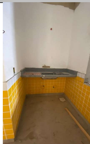
BANCADA DE GRANITO COM ESPESSURA DE 2 CM - ÁREA DA HIGIENIZAÇÃO
