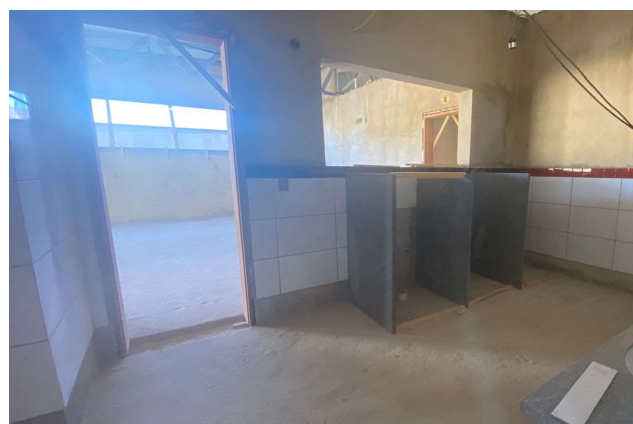
DIVISÓRIA DE GRANITO COM 3 CM DE ESPESSURA, ASSENTADA COM ARGAMASSA DE CIMENTO E AREIA NO TRAÇO 1:3, NA COR CINZA. ÁREA SANITÁRIO INFANTIL 1, BLOCO B.
