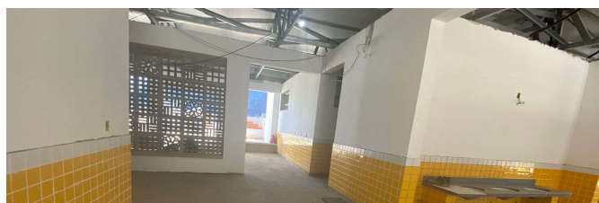
REVESTIMENTO CERÂMICO DE PAREDES PEI IV, CERÂMICA 10 X 10 CM, COR BRANCA.
