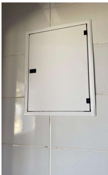
QUADRO DE DISTRIBUIÇÃO DE ENERGIA, DE EMBUTIR, COM 24 DIVISÕES MODULARES, COM BARRAMENTO - QD5
