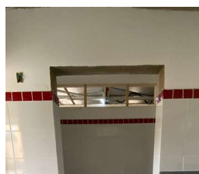
REVESTIMENTO CERÂMICO DE PAREDES PEI IV, CERÂMICA 10 X 10 CM, COR BRANCA.
