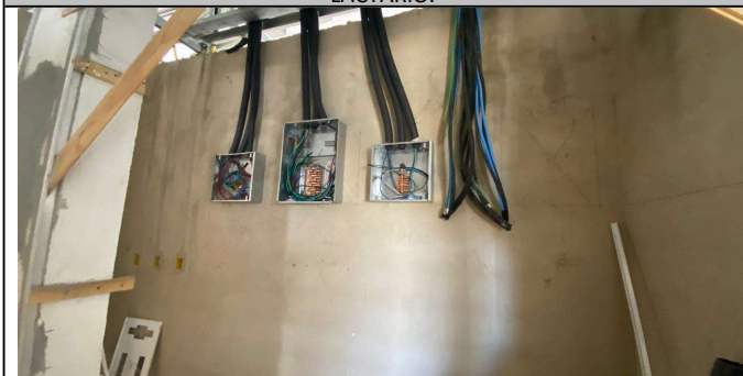
QUADRO DE DISTRIBUIÇÃO DE ENERGIA, DE EMBUTI.
