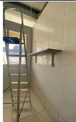
PRATELEIRAS EM GRANITO CINZA ANDORINHA, ESP. 2CM. SUPORTE MAO FRANCESA EM ACO, ABAS IGUAIS 40 CM, CAPACIDADE MINIMA 70 KG,
