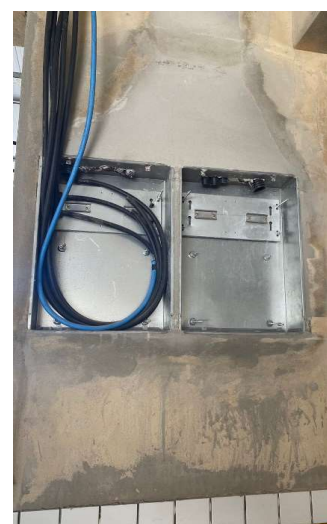
CABO DE COBRE FLEXIVEL ISOLADO, ANTI-CHAMA 450/750 V, PARA CIRCUITOS TERMINAIS
