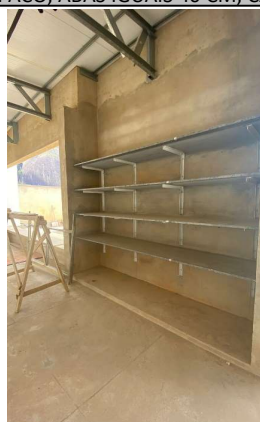
PRATELEIRAS EM GRANITO CINZA ANDORINHA, ESP. 2CM. SUPORTE MAO FRANCESA EM ACO, ABAS IGUAIS 40 CM, CAPACIDADE MINIMA 70 KG,
