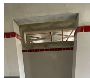
REVESTIMENTO CERÂMICO DE PAREDES PEI IV, CERÂMICA 10 X 10 CM, COR BRANCA.
