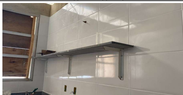
PRATELEIRAS EM GRANITO CINZA ANDORINHA, ESP. 2CM. SUPORTE MÃO FRANCESA EM ACO, ABAS IGUAIS 40 CM, CAPACIDADE MINIMA 70 KG, BRANCO - ÁREA LACTÁRIO
