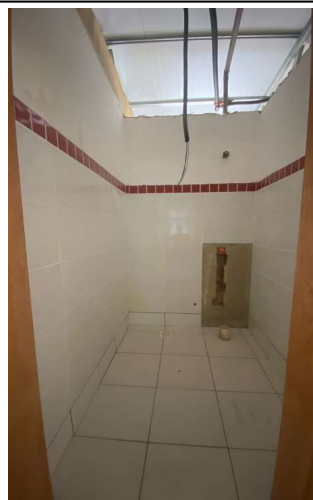
REVESTIMENTO CERÂMICO DE PAREDES PEI IV, CERÂMICA 30 X 40 CM, COR BRANCA. REVESTIMENTO CERÂMICO DE PAREDES PEI IV, CERÂMICA 10 X 10 CM, COR VERMELHA.
