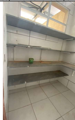
PRATELEIRAS EM GRANITO CINZA ANDORINHA, ESP. 2CM. E SUPORTE MAO FRANCESA EM ACO, ABAS IGUAIS 40 CM, CAPACIDADE MINIMA 70 KG,
