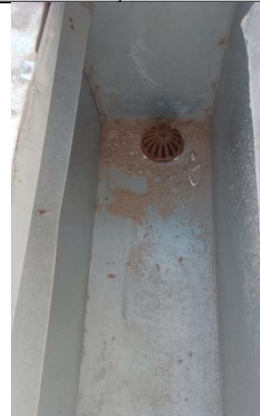
RALO HEMISFÉRICO (FORMATO ABACAXI) DE FERRO FUNDIDO, Ø100MM.
