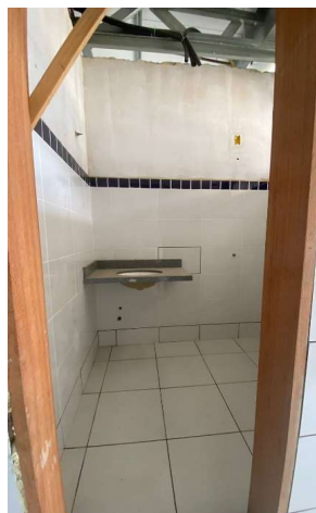
REVESTIMENTO CERÂMICO DE PAREDES PEI IV, CERÂMICA 30 X 40 CM, COR BRANCA. REVESTIMENTO CERÂMICO DE PAREDES PEI IV, CERÂMICA 10 X 10 CM, COR AZUL.
