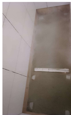
IMPERMEABILIZAÇÃO DE PISO, COM ADITIVO IMPERMEABILIZANTE, ÁREAS MOLHADAS DO BLOCO B.
