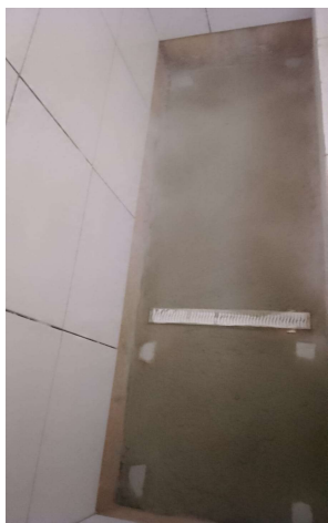
IMPERMEABILIZAÇÃO DE PISO, COM ADITIVO IMPERMEABILIZANTE, ÁREAS MOLHADAS DO BLOCO B.
