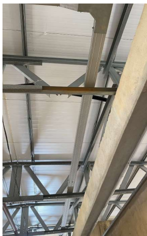
- ÁELETROCALHA LISA COM TAMPA 100 X 50 MM - ÁREA DO BLOCO B
