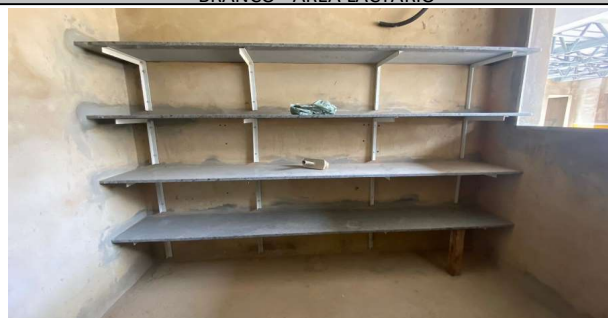
PRATELEIRAS EM GRANITO CINZA ANDORINHA, ESP. 2CM. E SUPORTE MÃO FRANCESA EM ACO, ABAS IGUAIS 40 CM, CAPACIDADE MINIMA 70 KG, BRANCO - ÁREA ALMOXARIFADO
