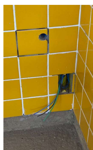
CABO DE COBRE FLEXIVEL ISOLADO, ANTI-CHAMA 450/750 V, PARA CIRCUITOS TERMINAIS
