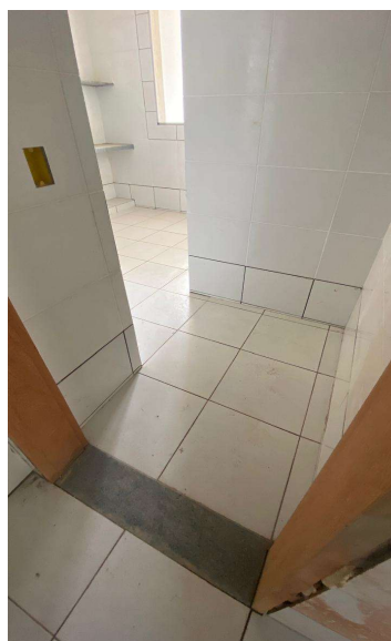
PISO CERÂMICO ANTIDERRAPANTE PEI V - 40 X 40 CM, E SOLEIRA EM GRANITO, LARGURA 15 CM, ESPESSURA 2,0 CM, ÁREA LAVANDERIA.
