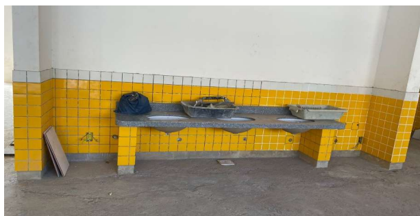
BANCADA DE GRANITO COM ESPESSURA DE 2 CM - ÁREA DO REFEITÓRIO
