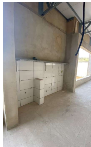
PRATELEIRAS EM GRANITO CINZA ANDORINHA, ESP. 2CM. SUPORTE MÃO FRANCESA EM ACO, ABAS IGUAIS 40 CM, CAPACIDADE MINIMA 70 KG,
