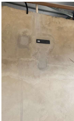
CAIXA DE ESPERA PARA PRE-INSTALAÇÃO DE AR CONDICIONADO SPLIT
