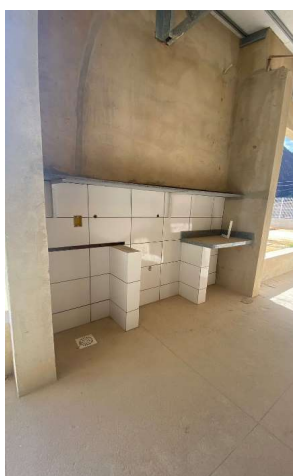
PRATELEIRAS EM GRANITO CINZA ANDORINHA, ESP. 2CM. E SUPORTE MÃO FRANCESA EM ACO, ABAS IGUAIS 40 CM, CAPACIDADE MINIMA 70 KG, BRANCO - ÁREA SOLÁRIO 6
