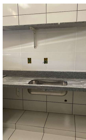
CUBA DE EMBUTIR EM AÇO INOXIDÁVEL COMPLETA, DIMENSÕES 40X34X17CM CUBA DE AÇO INOX N° 1(DIM.460X300X150)MM, ÁREA LACTÁRIO.
