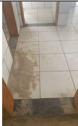
SOLEIRA EM GRANITO, LARGURA 15 CM, ESPESSURA 2,0 CM, ÁREA COPA DO FUNCIONARIOS.
