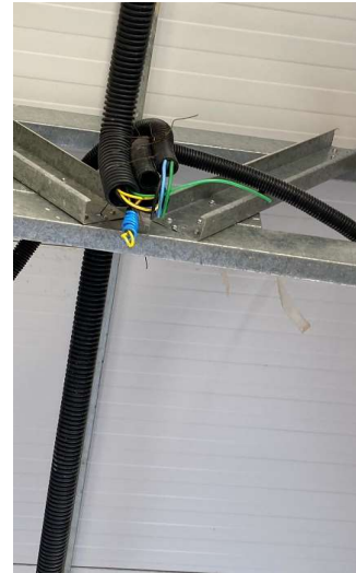
CABO DE COBRE FLEXIVEL ISOLADO, ANTI-CHAMA 450/750 V, PARA CIRCUITOS TERMINAIS
