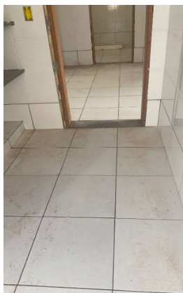
SOLEIRA EM GRANITO, LARGURA 15 CM, ESPESSURA 2,0 CM, ÁREA COZINHA.
