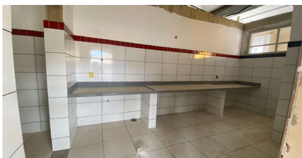
BANCADA DE GRANITO COM ESPESSURA DE 2 CM - ÁREA FRALDÁRIO
