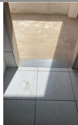
SOLEIRA EM GRANITO, LARGURA 15 CM, ESPESSURA 2,0 CM, ÁREA COPA DO FUNCIONARIOS.
