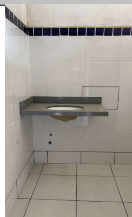
BANCADA DE GRANITO COM ESPESSURA DE 2 CM - ÁREA VEST. MASC.
