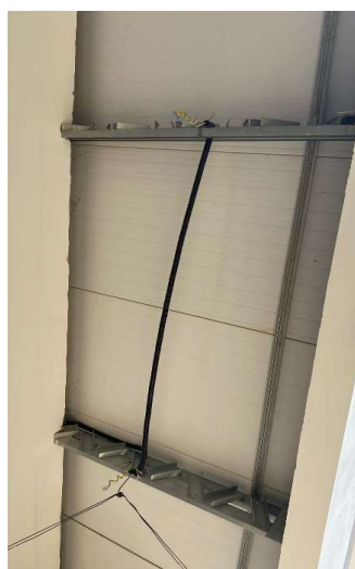
CABO DE COBRE FLEXIVEL ISOLADO, ANTI-CHAMA 450/750 V, PARA CIRCUITOS TERMINAIS
