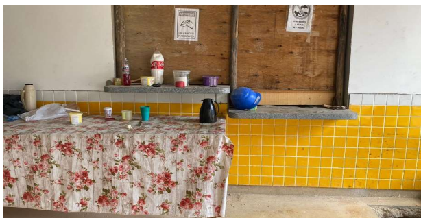
BANCADA DE GRANITO COM ESPESSURA DE 2 CM - ÁREA HALL
