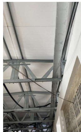
ELETROCALHA LISA TIPO U 150X75MM - ÁREA DO BLOCO A
