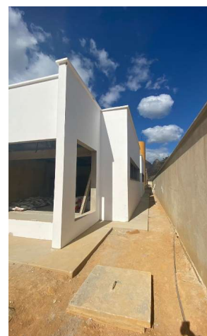
APLICAÇÃO MANUAL DE MASSA ACRÍLICA EM PANOS DE FACHADA SEM PRESENÇA DE VÃOS.
