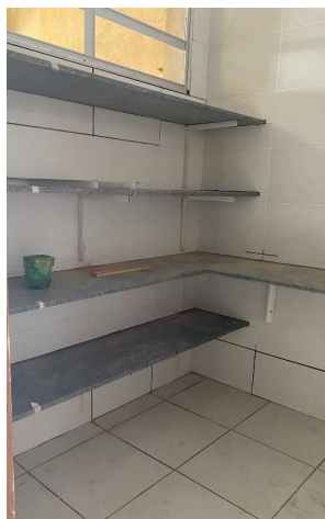
BANCADA DE GRANITO COM ESPESSURA DE 2 CM. E SUPORTE MAO FRANCESA EM ACO, ABAS IGUAIS 40 CM, CAPACIDADE MINIMA 70 KG,
