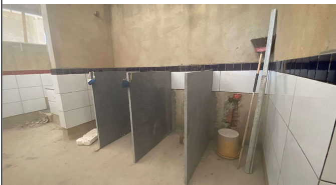
DIVISÓRIA DE GRANITO COM 3 CM DE ESPESSURA, ASSENTADA COM ARGAMASSA DE CIMENTO E AREIA NO TRAÇO 1:3, NA COR CINZA. ÁREA SANITÁRIO INFANTIL 4, BLOCO B.
