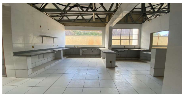
BANCADA DE GRANITO COM ESPESSURA DE 2 CM - ÁREA COZINHA
