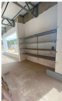
PRATELEIRAS EM GRANITO CINZA ANDORINHA, ESP. 2CM. E SUPORTE MAO FRANCESA EM ACO, ABAS IGUAIS 40 CM, CAPACIDADE MINIMA 70 KG,
