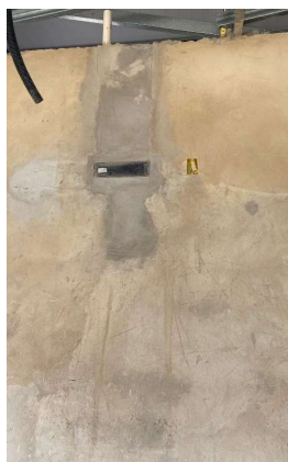
CAIXA DE ESPERA PARA PRE-INSTALAÇÃO DE AR CONDICIONADO SPLIT
