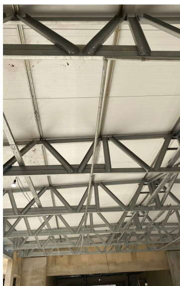
ELETRODUTO DE AÇO GALVANIZADO, CLASSE LEVE, DN 25 MM (1), APARENTE, INSTALADO EM TETO - ÁREA DO PÁTIO COBERTO.
