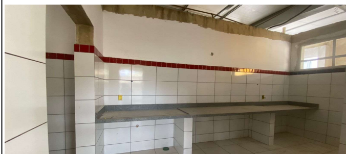
REVESTIMENTO CERÂMICO DE PAREDES PEI IV, CERÂMICA 30 X 40 CM, COR BRANCA. REVESTIMENTO CERÂMICO DE PAREDES PEI IV, CERÂMICA 10 X 10 CM, COR VERMELHA. REVESTIMENTO CERÂMICO DE PAREDES PEI IV, CERÂMICA 10 X 10 CM, COR AZUL.
