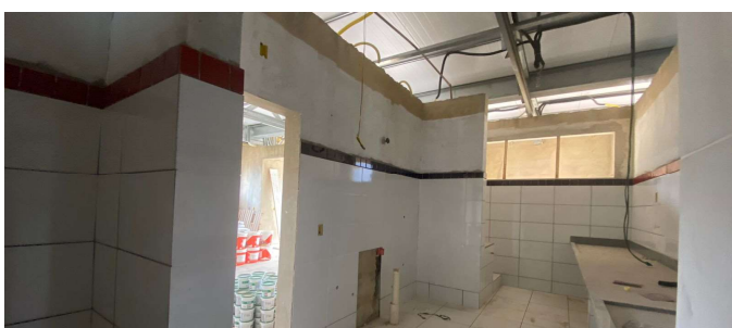
REVESTIMENTO CERÂMICO DE PAREDES PEI IV, CERÂMICA 30 X 40 CM, COR BRANCA. REVESTIMENTO CERÂMICO DE PAREDES PEI IV, CERÂMICA 10 X 10 CM, COR VERMELHA. REVESTIMENTO CERÂMICO DE PAREDES PEI IV, CERÂMICA 10 X 10 CM, COR AZUL.
