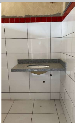
BANCADA DE GRANITO COM ESPESSURA DE 2 CM - ÁREA VEST. FEM.
