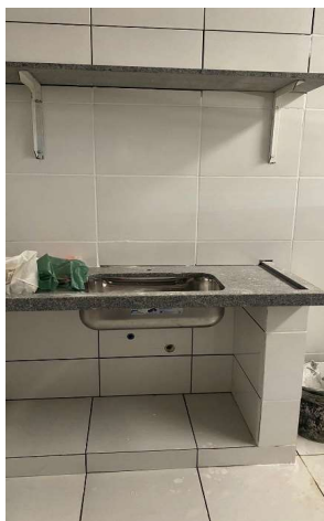
CUBA DE EMBUTIR EM AÇO INOXIDÁVEL COMPLETA, DIMENSÕES 40X34X17CM CUBA DE AÇO INOX N° 1(DIM.460X300X150)MM, ÁREA LACTÁRIO.
