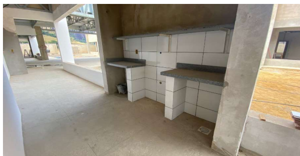
BANCADA DE GRANITO COM ESPESSURA DE 2 CM - ÁREA SOLÁRIO 05
