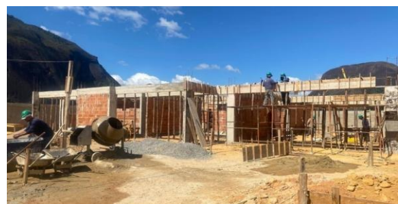
Foto 03 - Detalhes de formas de vigas, e paredes de alvenaria.
