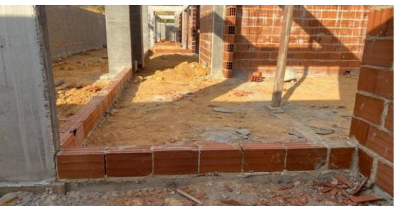
Foto 19 - Execução da alvenaria.
