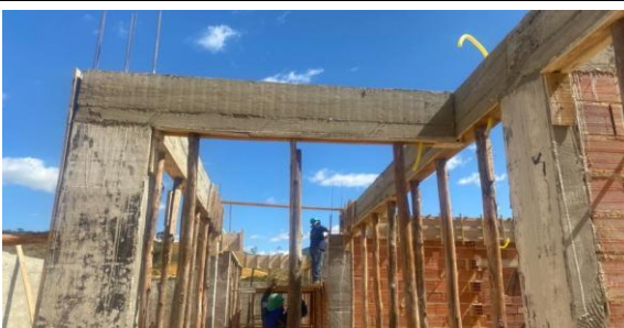
Foto 08 - Execução da alvenaria do Bloco A.
