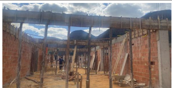
Foto 05 - Detalhes de formas de vigas.
