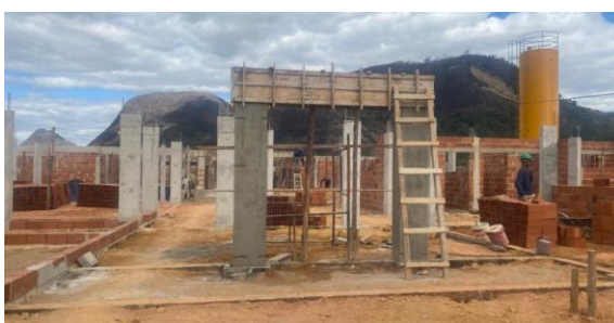
Foto 04 - Detalhes de formas de vigas.
