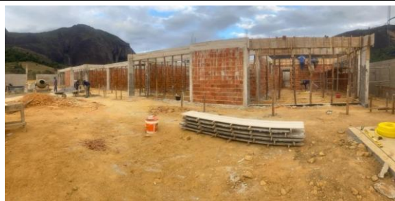
Foto 15 - Detalhes de após desformas de vigas, e paredes de alvenaria.
