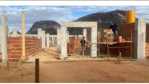
Foto 18 - Execução da alvenaria do Bloco A.
