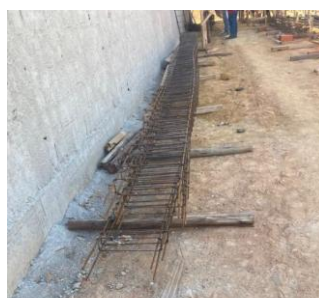
Foto 20 - Detalhe das armaduras de vigas, antes da instalação.
