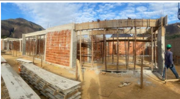
Foto 17 - Detalhes de formas de vigas.
