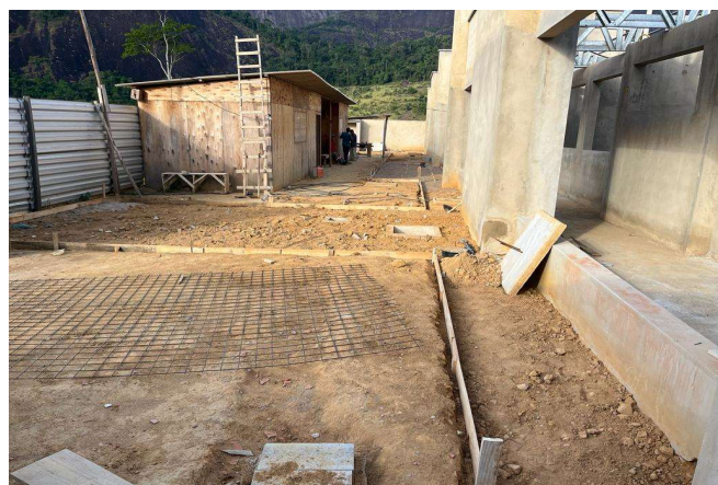
ESCAVAÇÃO MANUAL DE VALA COM PROFUNDIDADE MENOR OU IGUAL A 1,30 M.
