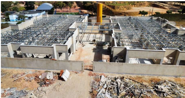
Estrutura steel frame metalica em tesouras (1451,75m²)
