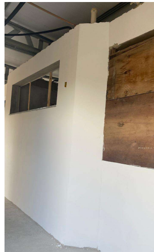
FOTO 02 - PAREDE COM PLACAS DE GESSO ACARTONADO (DRYWALL).
