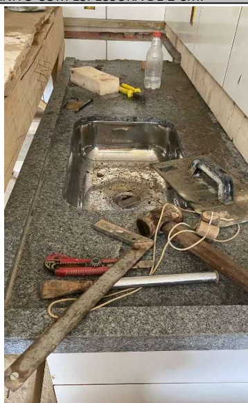
FOTO 70 - Cuba de embutir em aço Inoxidável completa, dimensões 40x34x17cm. Cuba de aço inox nº 1(dim.460x300x150)mm. Bancada de granito com espessura de 2 cm.
