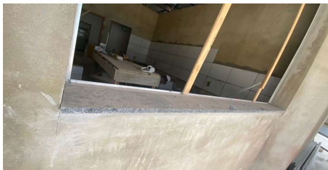
FOTO 90 - PEITORIL GRANITO E=2CM (Peitoril em granito cinza, largura=17,00cm e pingadeira).
