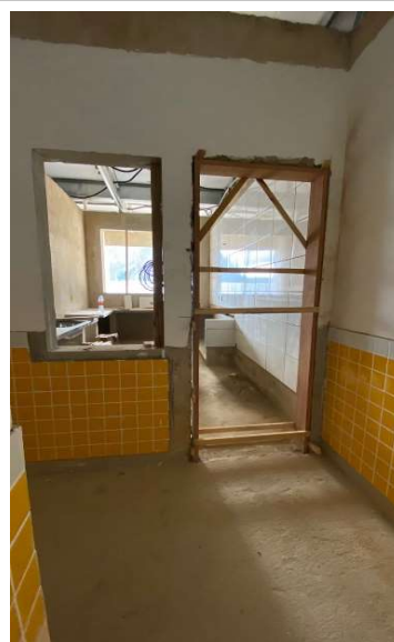
FOTO 28 - Revestimento cerâmico de paredes PEI IV - cerâmica 10 x 10 cm.
