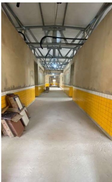
FOTO 32 - Revestimento cerâmico de paredes PEI IV - cerâmica 10 x 10 cm.
