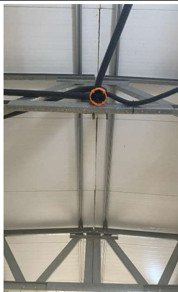
FOTO 79 - ELETRODUTO FLEXÍVEL CORRUGADO, CAIXA RETANGULAR 4" X 2" MÉDIA, CABO DE COBRE FLEXÍVEL ISOLADO, 2,5 MM 2 .
