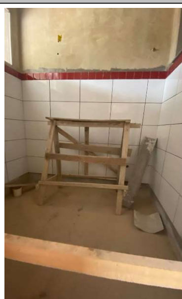
FOTO 22 - Revestimento cerâmico de paredes PEI IV- cerâmica 30 x 40 cm, e cerâmico de paredes PEI IV - cerâmica 10 x 10 cm.
