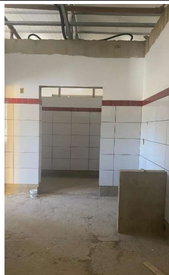
FOTO 14 - Revestimento cerâmico de paredes PEI IV- cerâmica 30 x 40 cm, e cerâmico de paredes PEI IV - cerâmica 10 x 10 cm.
