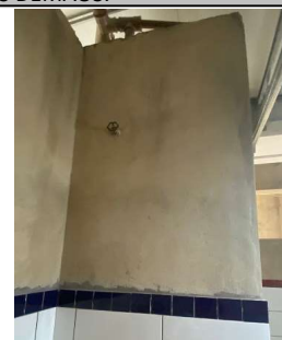
FOTO 59 - REGISTRO DE GAVETA BRUTO, LATAO, ROSCAVEL, 1 1/2, COM ACABAMENTO.
