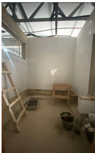
FOTO 19 - Revestimento cerâmico de paredes PEI IV- cerâmica 30 x 40 cm.
