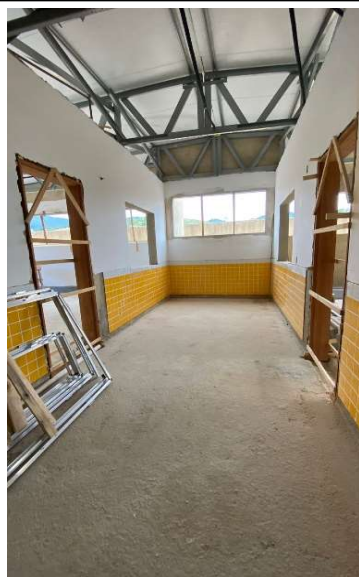
FOTO 29 - Revestimento cerâmico de paredes PEI IV - cerâmica 10 x 10 cm.
