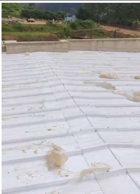
FOTO 07 - CUMEEIRA EM PERFIL ONDULADO DE AÇO ZINCADO.
