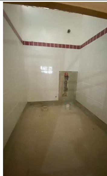
FOTO 12 - Revestimento cerâmico de paredes PEI IV- cerâmica 30 x 40 cm, e cerâmico de paredes PEI IV - cerâmica 10 x 10 cm.
