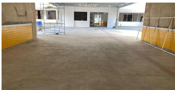
FOTO 38 - PISO CIMENTADO, TRAÇO 1:3 (CIMENTO E AREIA), ACABAMENTO LISO, ESPESSURA 2,0 CM, PREPARO MECÂNICO DA ARGAMASSA.
