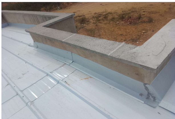
FOTO 09 - Rufo em chapa de aço galvanizado.
