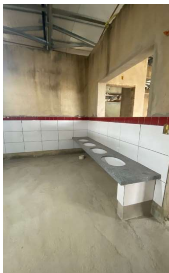
FOTO 66 - CUBA DE EMBUTIR OVAL EM LOUÇA BRANCA, 35 X 50CM, BANCADA DE GRANITO COM ESPESSURA DE 2 CM.
