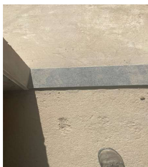
FOTO 37 - PISO CIMENTADO, TRAÇO 1:3 (CIMENTO E AREIA), ACABAMENTO LISO, ESPESSURA 2,0 CM, PREPARO MECÂNICO DA ARGAMASSA.
