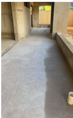
FOTO 36 - PISO CIMENTADO, TRAÇO 1:3 (CIMENTO E AREIA), ACABAMENTO LISO, ESPESSURA 2,0 CM, PREPARO MECÂNICO DA ARGAMASSA.
