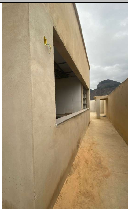
FOTO 87 - PEITORIL GRANITO E=2CM (Peitoril em granito cinza, largura=17,00cm e pingadeira).
