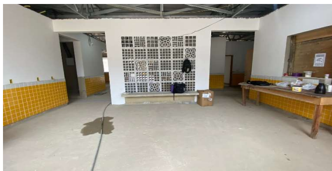
FOTO 27 - Revestimento cerâmico de paredes PEI IV - cerâmica 10 x 10 cm.
