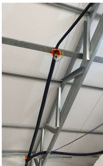
FOTO 72 - ELETRODUTO FLEXÍVEL CORRUGADO, CAIXA RETANGULAR 4" X 2" MÉDIA, CABO DE COBRE FLEXÍVEL ISOLADO, 2,5 MM 2 .
