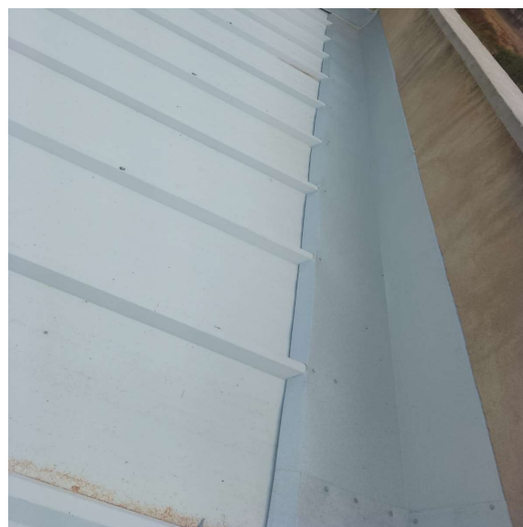
FOTO 08 - Rufo em chapa de aço galvanizado.
