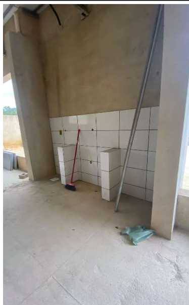
FOTO 15 - Revestimento cerâmico de paredes PEI IV- cerâmica 30 x 40 cm.
