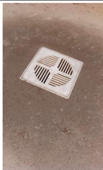
FOTO 63 - RALO SIFONADO, PVC, DN 100 X 40 MM.
