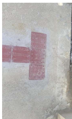
FOTO 43 - PISO PODOTÁTIL, DIRECIONAL OU ALERTA, ASSENTADO SOBRE ARGAMASSA, VERMELHA.
