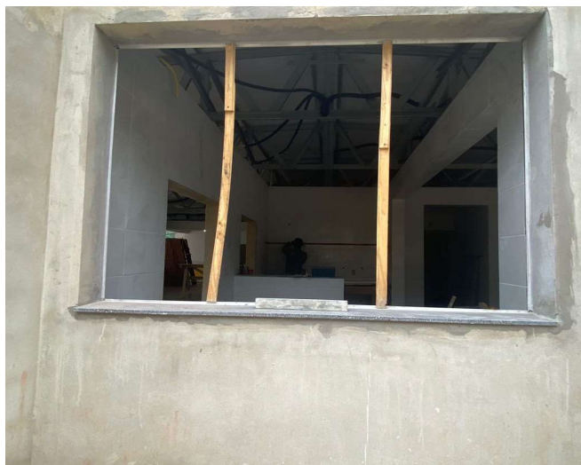
FOTO 86 - PEITORIL GRANITO E=2CM (Peitoril em granito cinza, largura=17,00cm e pingadeira).
