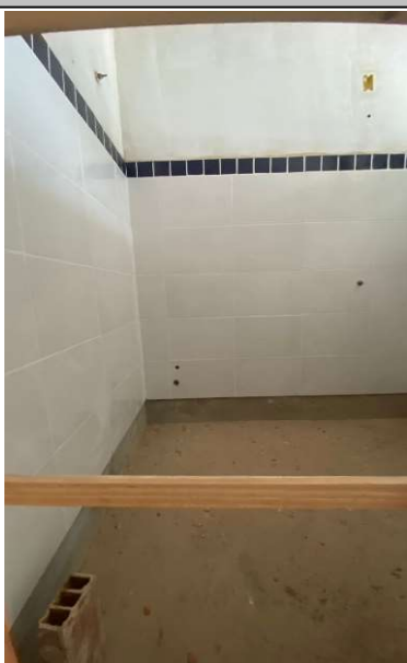
FOTO 21 - Revestimento cerâmico de paredes PEI IV- cerâmica 30 x 40 cm, e cerâmico de paredes PEI IV - cerâmica 10 x 10 cm.
