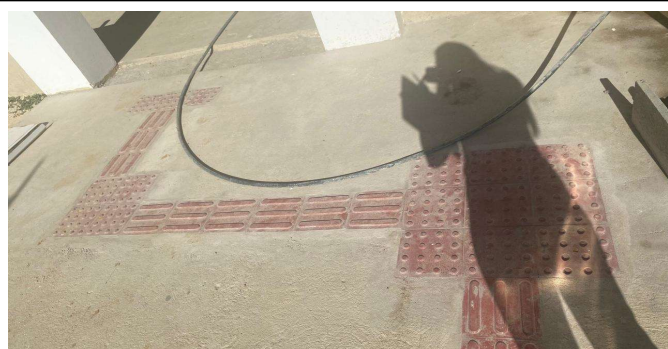
FOTO 44 - PISO PODOTÁTIL, DIRECIONAL OU ALERTA, ASSENTADO SOBRE ARGAMASSA, VERMELHA.
