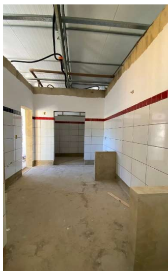
FOTO 13 - Revestimento cerâmico de paredes PEI IV- cerâmica 30 x 40 cm, e cerâmico de paredes PEI IV - cerâmica 10 x 10 cm.
