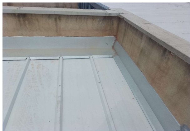
FOTO 10 - Rufo em chapa de aço galvanizado.
