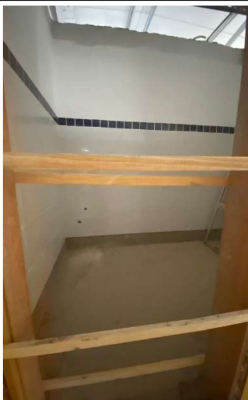
FOTO 17 - Revestimento cerâmico de paredes PEI IV- cerâmica 30 x 40 cm, e cerâmico de paredes PEI IV - cerâmica 10 x 10 cm.
