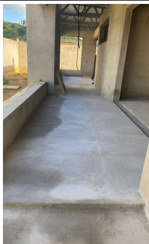
FOTO 37 - PISO CIMENTADO, TRAÇO 1:3 (CIMENTO E AREIA), ACABAMENTO LISO, ESPESSURA 2,0 CM, PREPARO MECÂNICO DA ARGAMASSA.
