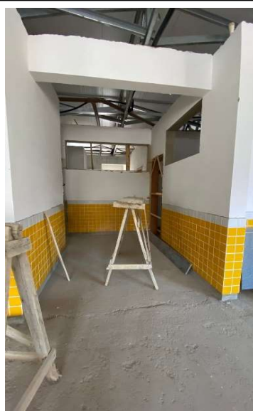
FOTO 32 - Revestimento cerâmico de paredes PEI IV - cerâmica 10 x 10 cm.
