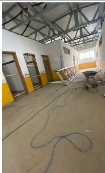
FOTO 30 - Revestimento cerâmico de paredes PEI IV - cerâmica 10 x 10 cm.
