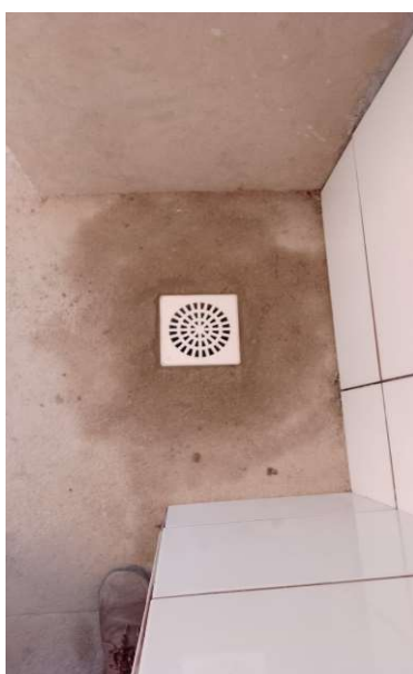
FOTO 64 - RALO SIFONADO, PVC, DN 100 X 40 MM.
