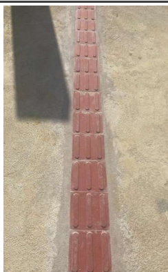
FOTO 42 - PISO PODOTÁTIL, DIRECIONAL OU ALERTA, ASSENTADO SOBRE ARGAMASSA, VERMELHA.
