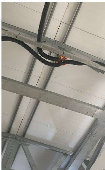
FOTO 80 - ELETRODUTO FLEXÍVEL CORRUGADO, CAIXA RETANGULAR 4" X 2" MÉDIA, CABO DE COBRE FLEXÍVEL ISOLADO, 2,5 MM 2 .
