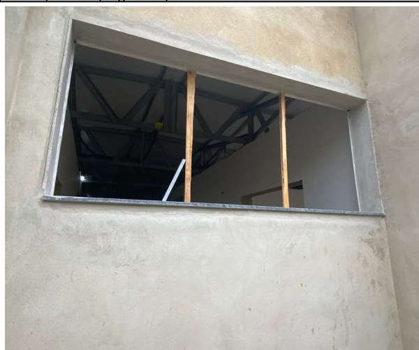
FOTO 93 - PEITORIL GRANITO E=2CM (Peitoril em granito cinza, largura=17,00cm e pingadeira).
