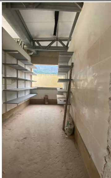
FOTO 25 - Revestimento cerâmico de paredes PEI IV- cerâmica 30 x 40 cm.
