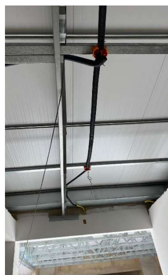
FOTO 73 - ELETRODUTO FLEXÍVEL CORRUGADO, CAIXA RETANGULAR 4" X 2" MÉDIA, CABO DE COBRE FLEXÍVEL ISOLADO, 2,5 MM 2 .
