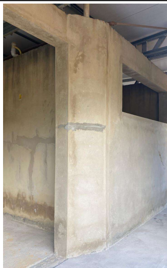
FOTO 05 - PAREDE COM PLACAS DE GESSO ACARTONADO (DRYWALL).
