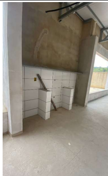
FOTO 16 - Revestimento cerâmico de paredes PEI IV- cerâmica 30 x 40 cm.
