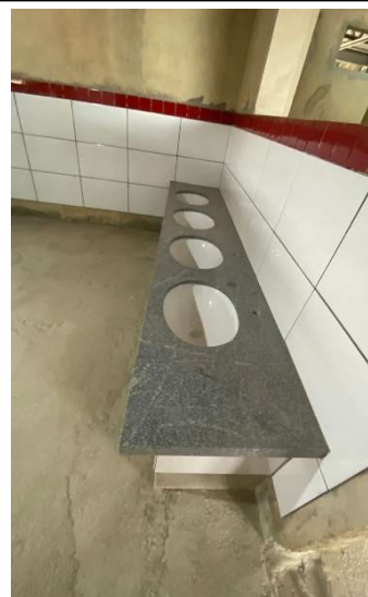
FOTO 67 - CUBA DE EMBUTIR OVAL EM LOUÇA BRANCA, 35 X 50CM, BANCADA DE GRANITO COM ESPESSURA DE 2 CM.
