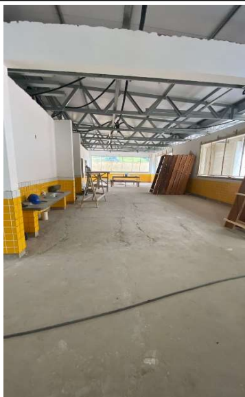
FOTO 31 - Revestimento cerâmico de paredes PEI IV - cerâmica 10 x 10 cm.
