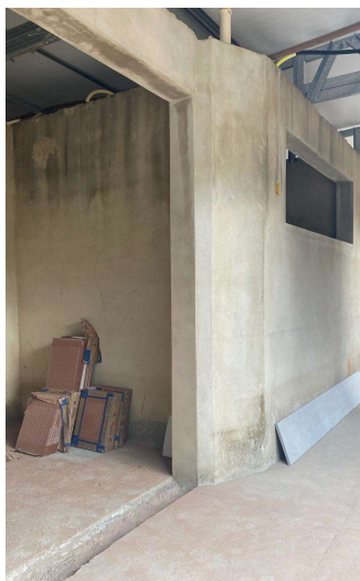
FOTO 03 - PAREDE COM PLACAS DE GESSO ACARTONADO (DRYWALL).
