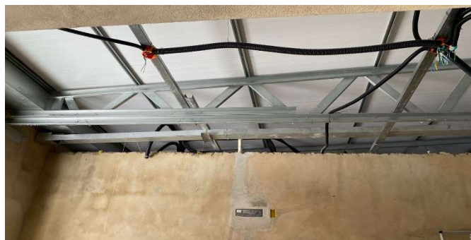
FOTO 74 - ELETRODUTO FLEXÍVEL CORRUGADO, CAIXA RETANGULAR 4" X 2" MÉDIA, CABO DE COBRE FLEXÍVEL ISOLADO, 2,5 MM 2 .
