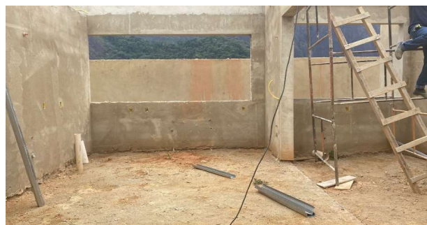
7.8 Chapim de concreto armado Fck=15 MPa, nas dimensões de 30x5 cm, moldado "in loco"
