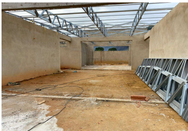
7.1 Estrutura steel frame metalica em tesouras - bloco B
