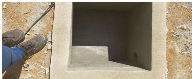
13.2.2 CAIXA ENTERRADA HIDRÁULICA RETANGULAR EM ALVENARIA COM TIJOLOS CERÂMICOS MACIÇOS, DIMENSÕES INTERNAS: 0,6X0,6X0,6 M PARA REDE DE DRENAGEM. AF_12/2020
