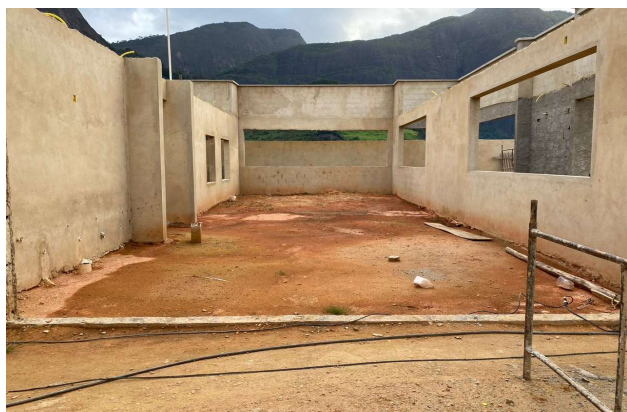
9.1.4 Reboco de argamassa de cimento, cal hidratada CH1 e areia média ou grossa lavada no traço 1:0.5:6, espessura 5mm
