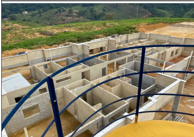
7.8 Chapim de concreto armado Fck=15 MPa, nas dimensões de 30x5 cm, moldado "in loco"
