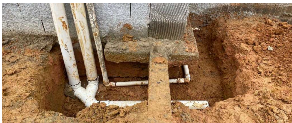
13.1.5 JUNÇÃO SIMPLES, PVC, SERIE R, ÁGUA PLUVIAL, DN 100 X 100 MM, JUNTA ELÁSTICA, FORNECIDO E INSTALADO EM RAMAL DE ENCAMINHAMENTO. AF_12/2014
