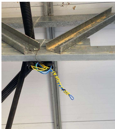
CABO DE COBRE FLEXIVEL ISOLADO, ANTI-CHAMA 450/750 V, PARA CIRCUITOS TERMINAIS .
