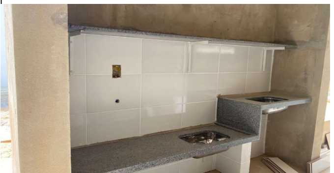
CUBA DE EMBUTIR EM AÇO INOXIDÁVEL, DIMENSÕES 40X34X17CM CUBA DE AÇO INOX N° 1(DIM.460X300X150)MM - SOLÁRIO 3.
