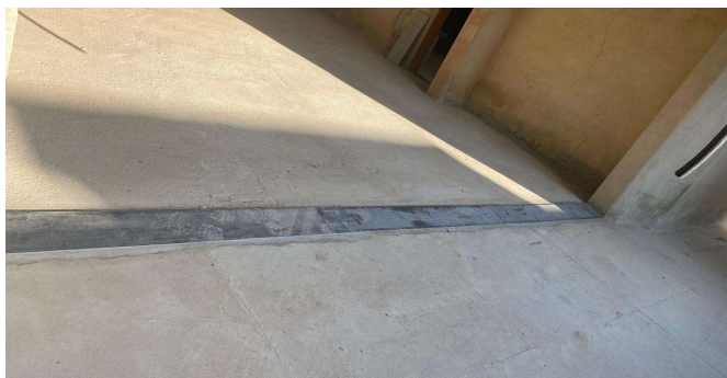
SOLEIRA EM GRANITO, LARGURA 15 CM, ESPESSURA 2,0 CM.
