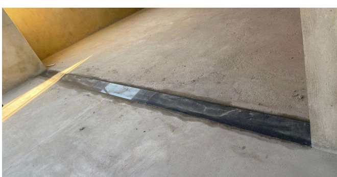
SOLEIRA EM GRANITO, LARGURA 15 CM, ESPESSURA 2,0 CM.
