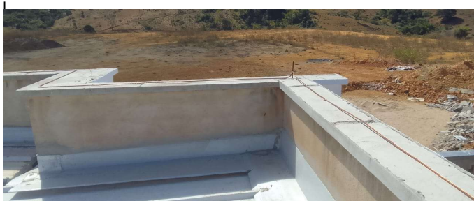
SISTEMA DE PROTEÇÃO CONTRA DESCARGAS ATMOSFÉRICAS (SPDA).
