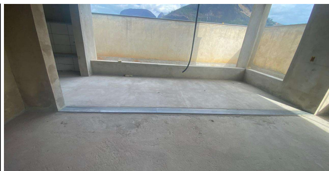
SOLEIRA EM GRANITO, LARGURA 15 CM, ESPESSURA 2,0 CM.
