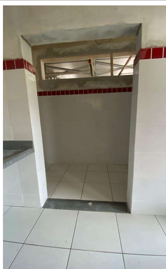
SOLEIRA EM GRANITO, LARGURA 15 CM, ESPESSURA 2,0 CM.
