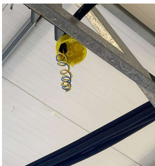
CABO DE COBRE FLEXIVEL ISOLADO, ANTI-CHAMA 450/750 V, PARA CIRCUITOS TERMINAIS .
