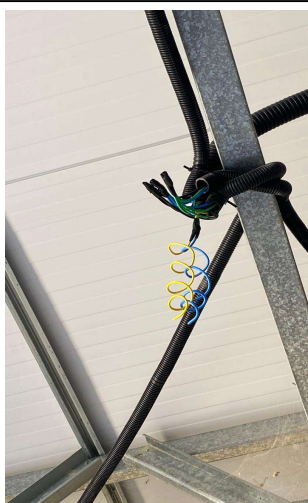
CABO DE COBRE FLEXIVEL ISOLADO, ANTI-CHAMA 450/750 V, PARA CIRCUITOS TERMINAIS .
