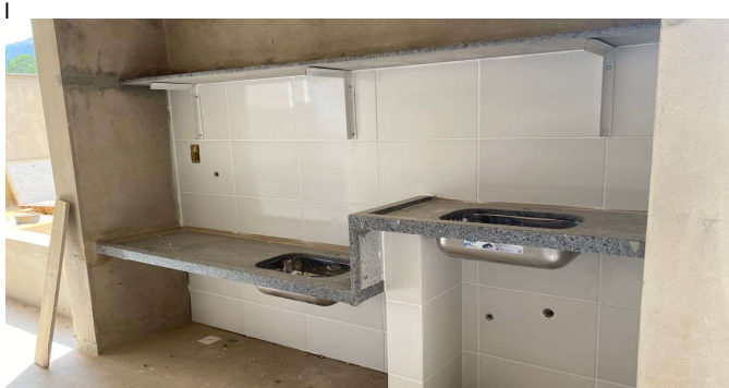
CUBA DE EMBUTIR EM AÇO INOXIDÁVEL, DIMENSÕES 40X34X17CM CUBA DE AÇO INOX N° 1(DIM.460X300X150)MM - SOLÁRIO 2.
