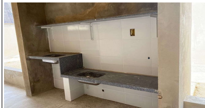
CUBA DE EMBUTIR EM AÇO INOXIDÁVEL, DIMENSÕES 40X34X17CM CUBA DE AÇO INOX N° 1(DIM.460X300X150)MM - SOLÁRIO 4.
