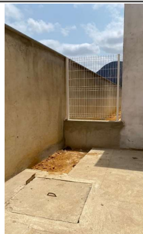
GRADIL METALICO E TELA DE AÇO GALVANIZADO, INCLUSIVE PINTURA.
