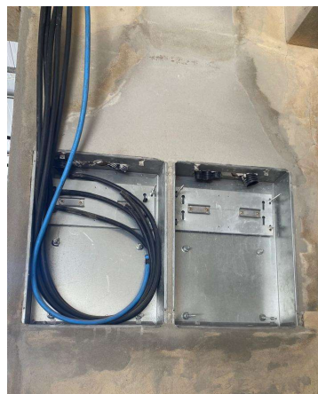
CABO DE COBRE FLEXIVEL ISOLADO, ANTI-CHAMA 450/750 V, PARA CIRCUITOS TERMINAIS .
