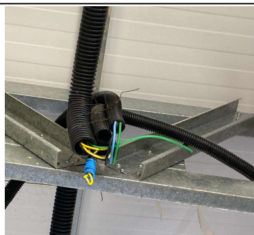
CABO DE COBRE FLEXIVEL ISOLADO, ANTI-CHAMA 450/750 V, PARA CIRCUITOS TERMINAIS .
