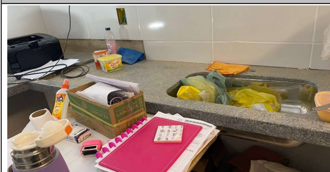
CUBA DE EMBUTIR EM AÇO INOXIDÁVEL, DIMENSÕES 40X34X17CM CUBA DE AÇO INOX N° 1(DIM.460X300X150)MM - LACTÁRIO.
