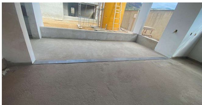
SOLEIRA EM GRANITO, LARGURA 15 CM, ESPESSURA 2,0 CM.
