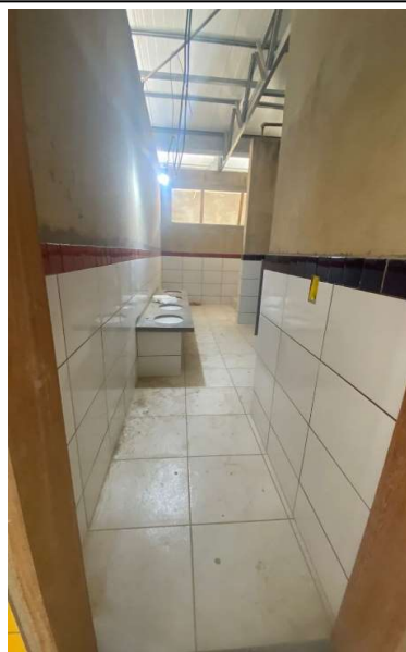
PISO CERÂMICO ANTIDERRAPANTE PEI V - 40 X 40 CM - INCL. REJUNTE - SANIT. INFANTIL 4.
