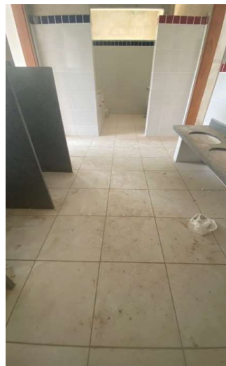
PISO CERÂMICO ANTIDERRAPANTE PEI V - 40 X 40 CM - INCL. REJUNTE - SANIT. INFANTIL 2.
