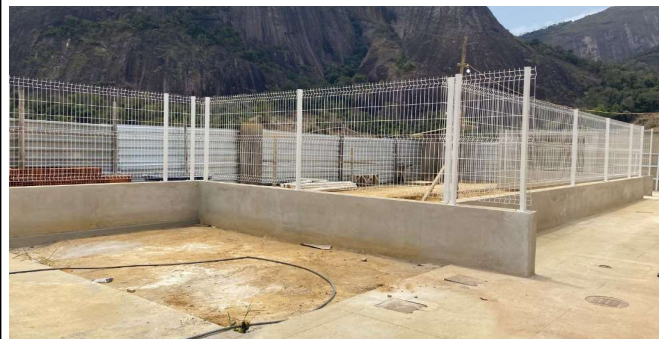
GRADIL METALICO E TELA DE AÇO GALVANIZADO, INCLUSIVE PINTURA.
