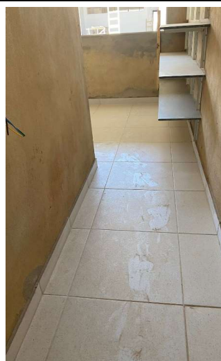
PISO CERÂMICO ANTIDERRAPANTE PEI V - 60 X 60 CM - INCL. REJUNTE. E RODAPÉ CERÂMICO DE 10CM DE ALTURA COM PLACAS DE DIMENSÕES 60X60CM - ALMOXARIFADO.
