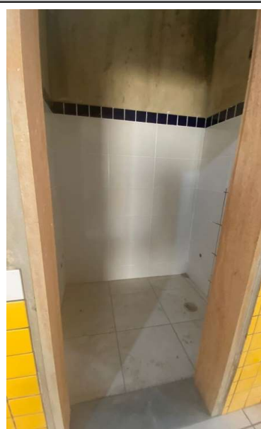
PISO CERÂMICO ANTIDERRAPANTE PEI V - 40 X 40 CM - INCL. REJUNTE - SANIT. PROF. MASC.
