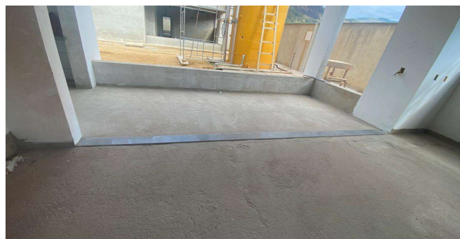
SOLEIRA EM GRANITO, LARGURA 15 CM, ESPESSURA 2,0 CM.
