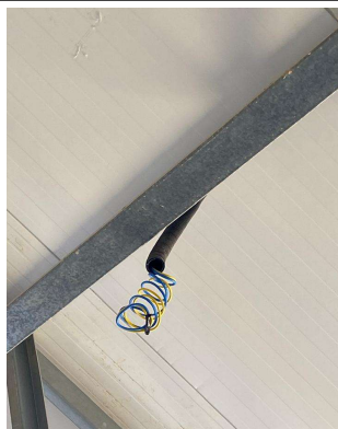
CABO DE COBRE FLEXIVEL ISOLADO, ANTI-CHAMA 450/750 V, PARA CIRCUITOS TERMINAIS .
