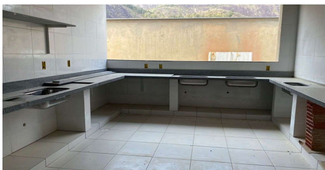
CUBA EM AÇO INOXIDÁVEL, DIMENSÕES 50X40X20CM - COZINHA.
