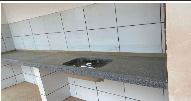
CUBA EM AÇO INOXIDÁVEL COMPLETA, DIMENSÕES 50X40X20CM - VARANDA.
