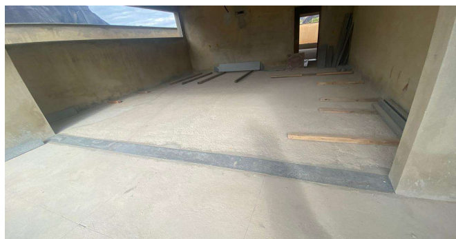
SOLEIRA EM GRANITO, LARGURA 15 CM, ESPESSURA 2,0 CM.
