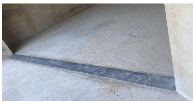
SOLEIRA EM GRANITO, LARGURA 15 CM, ESPESSURA 2,0 CM.
