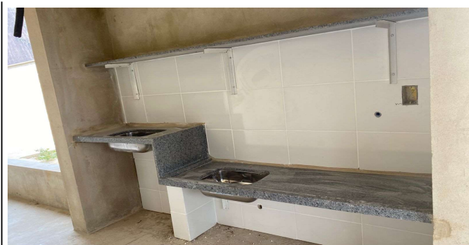
CUBA DE EMBUTIR EM AÇO INOXIDÁVEL, DIMENSÕES 40X34X17CM CUBA DE AÇO INOX N° 1(DIM.460X300X150)MM - SOLÁRIO 1.
