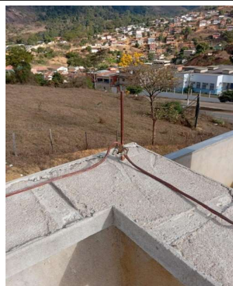
SISTEMA DE PROTEÇÃO CONTRA DESCARGAS ATMOSFÉRICAS (SPDA).
