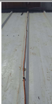
SISTEMA DE PROTEÇÃO CONTRA DESCARGAS ATMOSFÉRICAS (SPDA).
