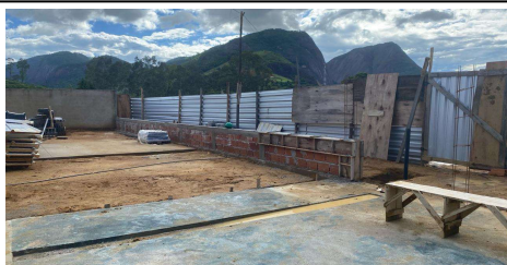
FOTO 07 - DETALHES DE FABRICAÇÃO DE FÔRMA PARA PILARES E DESMONTAGEM DE FÔRMAS. FORNECIMENTO E APLICAÇÃO DE CONCRETO. ALVENARIA DE VEDAÇÃO DE BLOCOS CERÂMICOS FURADOS NA VERTICAL DE 14X19X39CM (ESPESSURA 14CM).
