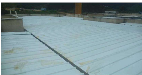
FOTO 15 - TELHA SANDUICHE METALICA COM PREENCHIMENTO EM PIR 30MM, 0,5 X 0,43 MM.
