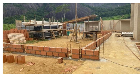
FOTO 06 - DETALHES DE ARMAÇÃO DE PILAR. ALVENARIA DE VEDAÇÃO DE BLOCOS CERÂMICOS FURADOS NA VERTICAL DE 14X19X39CM (ESPESSURA 14CM).
