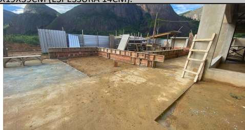
FOTO 09 - DETALHES DE FABRICAÇÃO DE FÔRMA PARA PILARES E DESMONTAGEM DE FÔRMAS. FORNECIMENTO E APLICAÇÃO DE CONCRETO. ALVENARIA DE VEDAÇÃO DE BLOCOS CERÂMICOS FURADOS NA VERTICAL DE 14X19X39CM (ESPESSURA 14CM).
