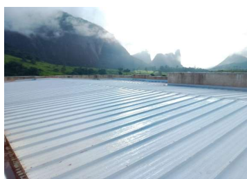
FOTO 12 - TELHA SANDUICHE METALICA COM PREENCHIMENTO EM PIR 30MM, 0,5 X 0,43 MM.
