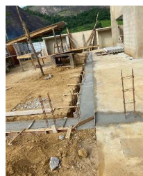
FOTO 02 - DETALHES DE ARMAÇÃO DE PILAR.
