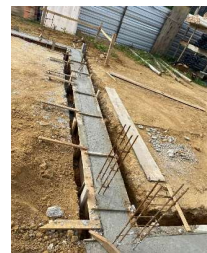
FOTO 02 - DETALHES DE ARMAÇÃO DE PILAR.
