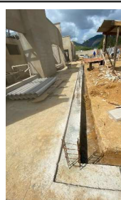
FOTO 04 - DETALHES DE ARMAÇÃO DE PILAR.
