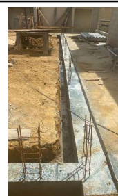
FOTO 04 - DETALHES DE ARMAÇÃO DE PILAR.
