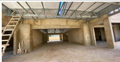
FOTO 14 - TELHA SANDUICHE METALICA COM PREENCHIMENTO EM PIR 30MM, 0,5 X 0,43 MM.
