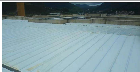
FOTO 14 - TELHA SANDUICHE METALICA COM PREENCHIMENTO EM PIR 30MM, 0,5 X 0,43 MM.
