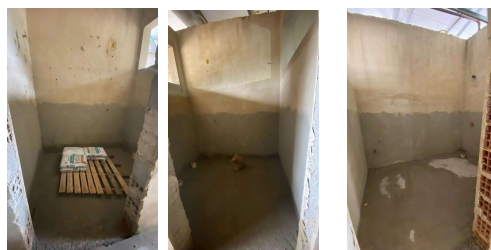
FOTO 22 - DETALHES DE IMPERMEABILIZAÇÃO DE PAREDE DO BLOCO A.
