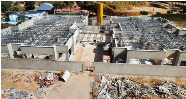
Emboço/Reboco Finalizados
