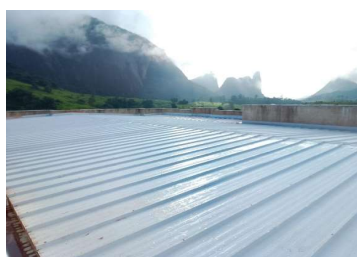
FOTO 12 - TELHA SANDUICHE METALICA COM PREENCHIMENTO EM PIR 30MM, 0,5 X 0,43 MM.
