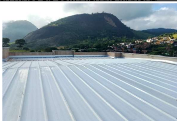
FOTO 13 - TELHA SANDUICHE METALICA COM PREENCHIMENTO EM PIR 30MM, 0,5 X 0,43 MM.
