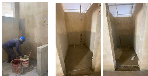
FOTO 21 - DETALHES DE IMPERMEABILIZAÇÃO DE PAREDE DO BLOCO A.
