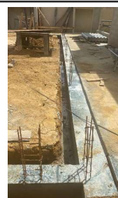
FOTO 04 - DETALHES DE ARMAÇÃO DE PILAR.
