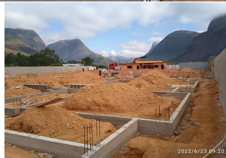
Foto 8 - CONCRETO ARMADO PARA FUNDAÇÕES - VIGAS BALDRAMES
