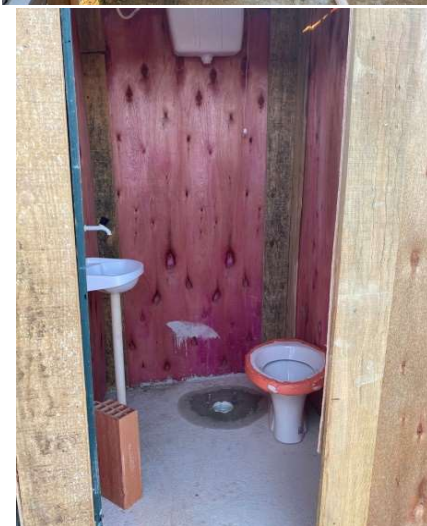
Foto 6 - EXECUÇÃO DE SANITÁRIO E VESTIÁRIO EM CANTEIRO DE OBRA EM CHAPA DE MADEIRA COMPENSADA, NÃO INCLUSO MOBILIÁRIO. AF_02/2016
