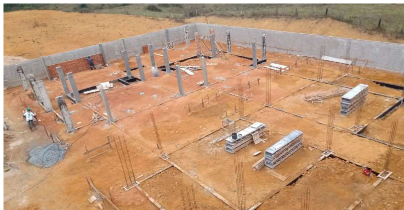
Foto 9 - CONCRETO ARMADO - PILARES.
