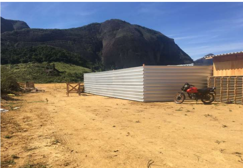
Foto 3 - TAPUME COM TELHA METÁLICA.
