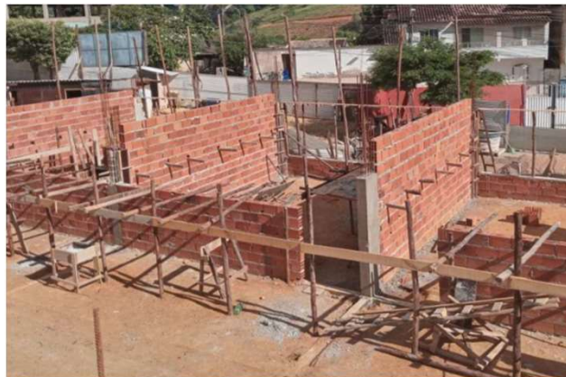
ALVENARIA DE VEDAÇÃO
