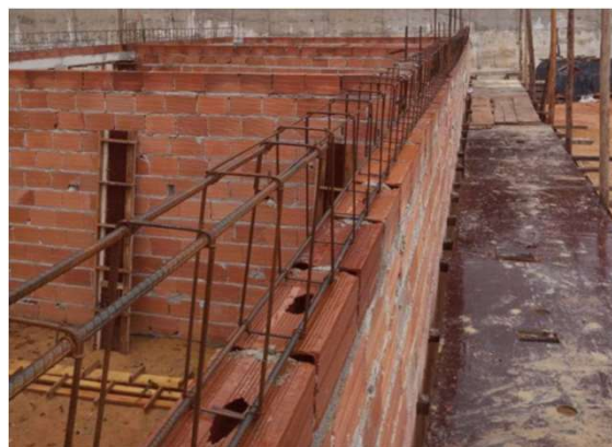
EXECUÇÃO DE ARMADURAS
