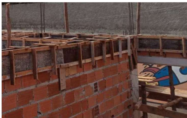
EXECUÇÃO DE FORMAS DE MADEIRITE
