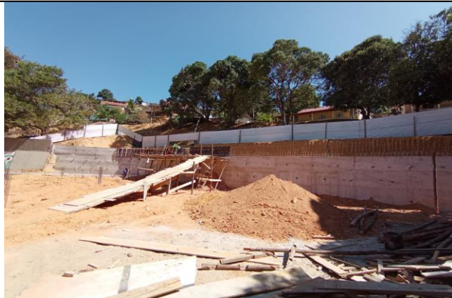
MURO DE CONTENÇÃO
