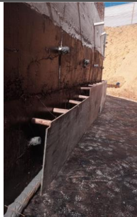
MURO DE CONTENÇÃO
