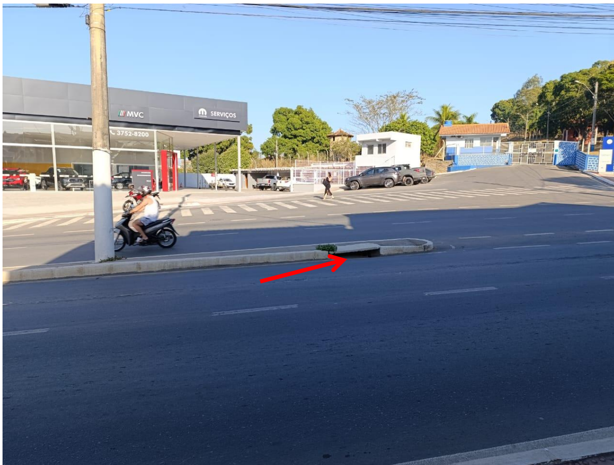
Figura 13 – Sistema de recolhimento de águas pluviais (boca de lobo) – Av. Guanabara. Fonte: Autoria própria, 2024.
