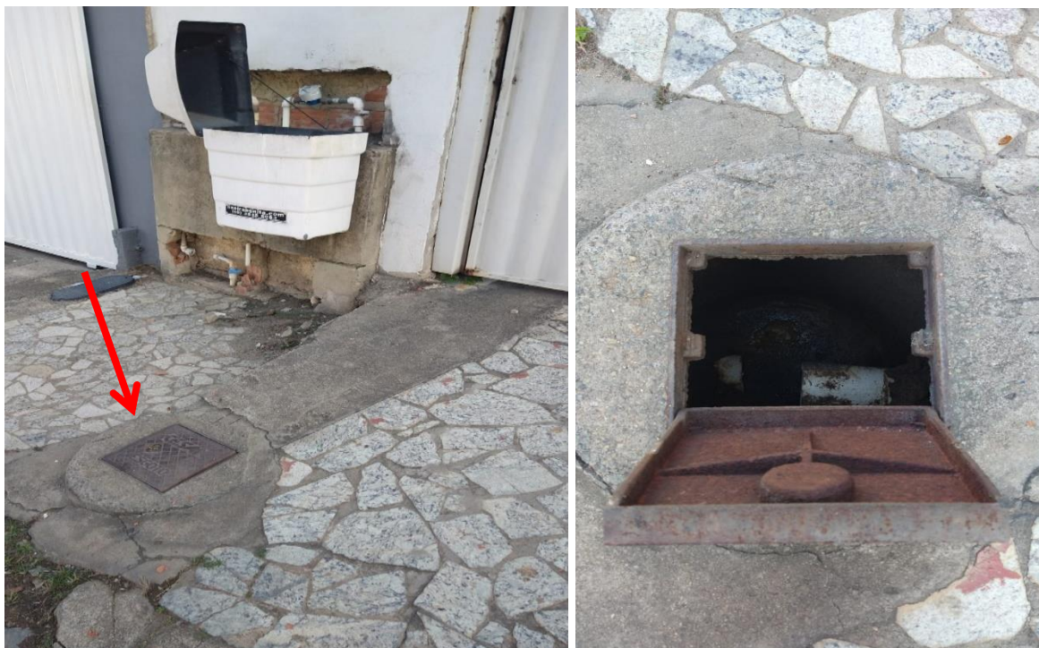
Figuras 10, 11, 12 – Sistema de recolhimento de esgoto doméstico instalado pela concessionária local. Fonte: Autoria própria, 2024.
