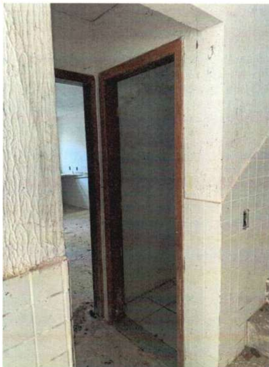
Figura 26 - Vão da porta com alisares.
