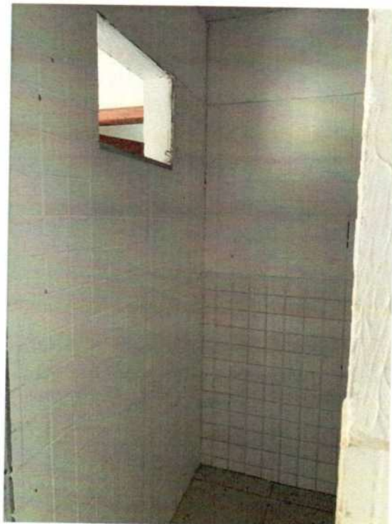
Figura 95 - Vão da janela
