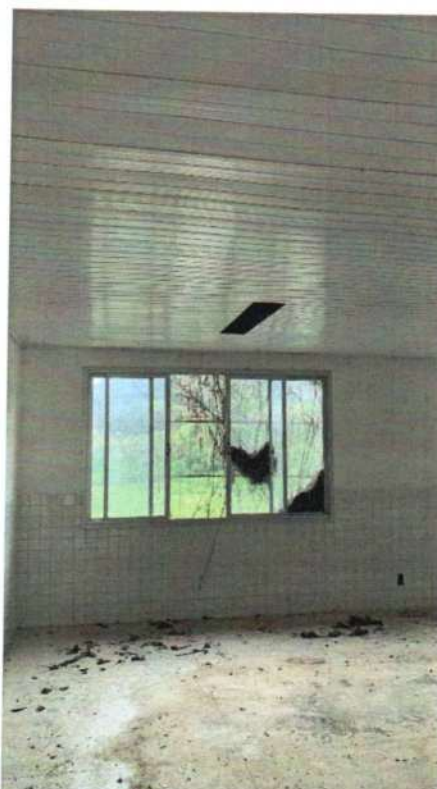
Figura 127 - Esquadrias conservadas, luminárias ausentes.
