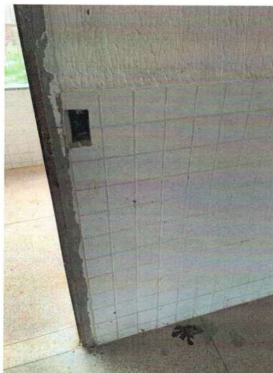
Figura 47 - Cômado sem alisares internos, com pontos de energia
