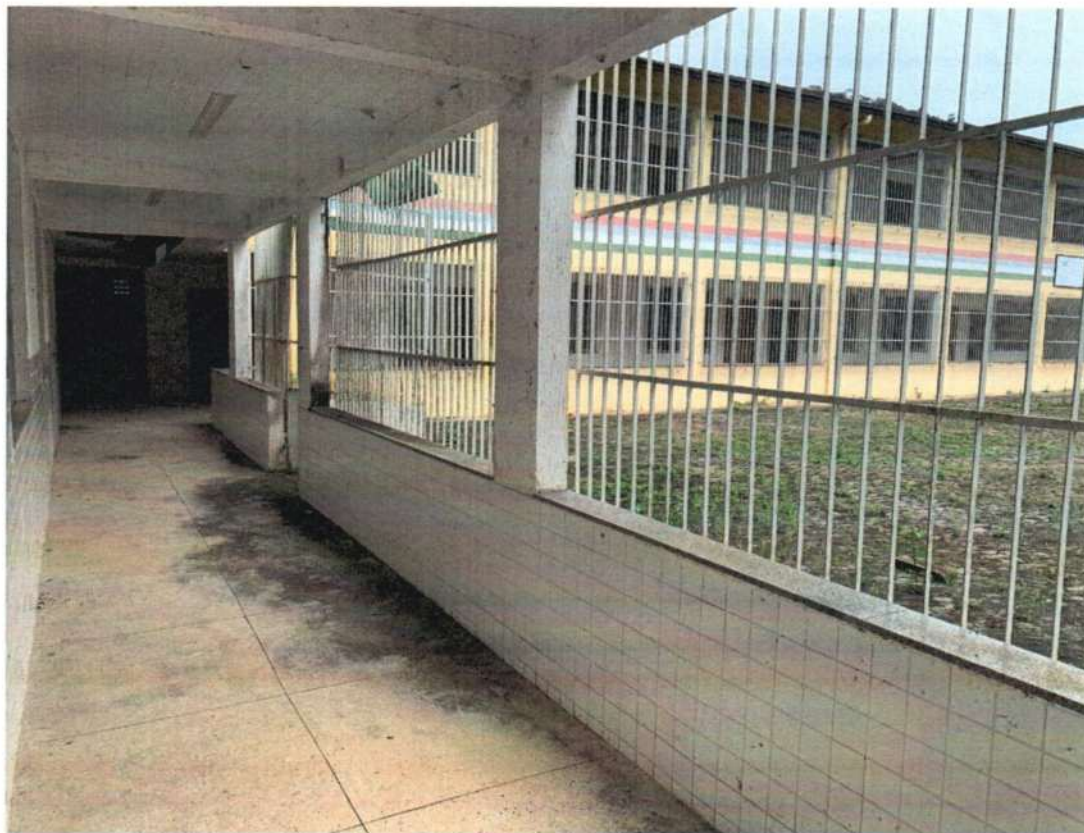
Figura 38 - Vista de parte do corredor.
