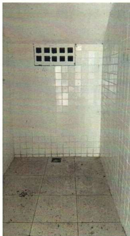
Figura 33 - Revestimento das paredes conservado.
