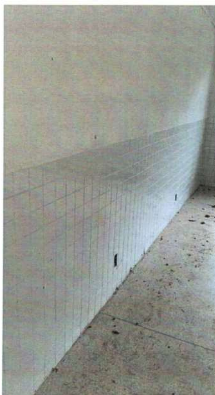
Figura 130 - revestimento interno das paredes conservado.
