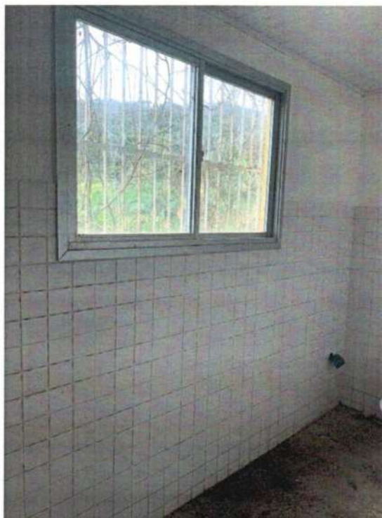
Figura 68 - banheiro anexo à sala dos professores, esquadria conservada.
