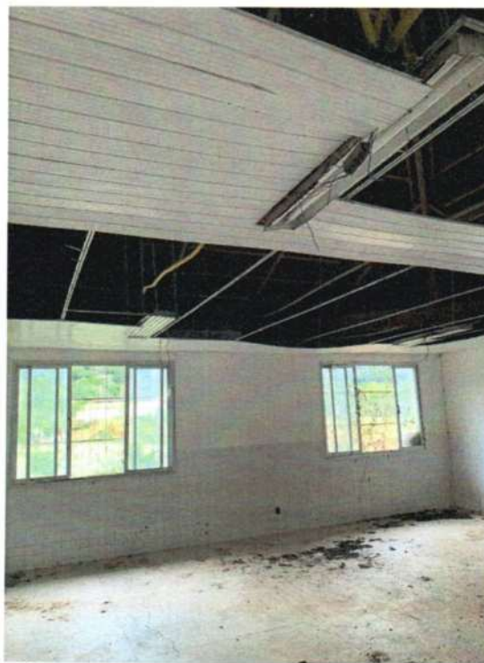
Figura 118 - Esquadrias, ao fundo, em bom estado de conservação.
