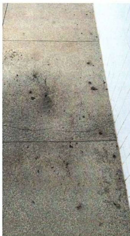
Figura 142 - Padrão repetitivo: rachaduras, trincas ou fissuras sobre viga inferior.
