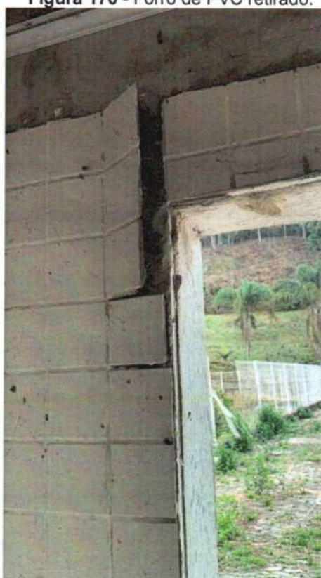
Figura 177 - revestimento deslocando.
