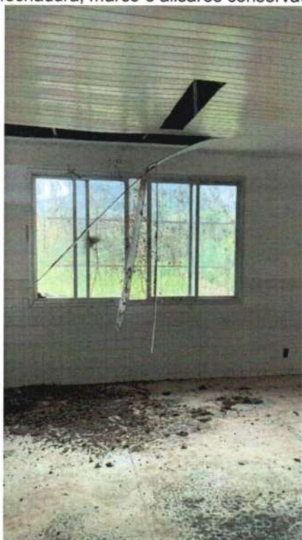
Figura 133 - esquadrias conservadas, luminárias ausentes.
