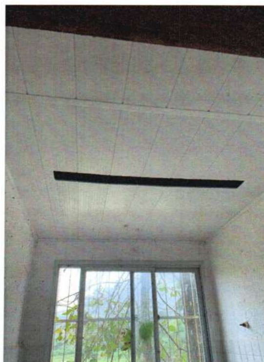
Figura 86 Forro de PVC conservado, mas sem luminária
