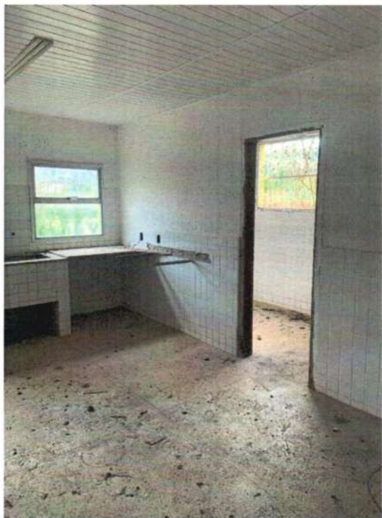
Figura 22 - Porta do depósito, sem alisares.
