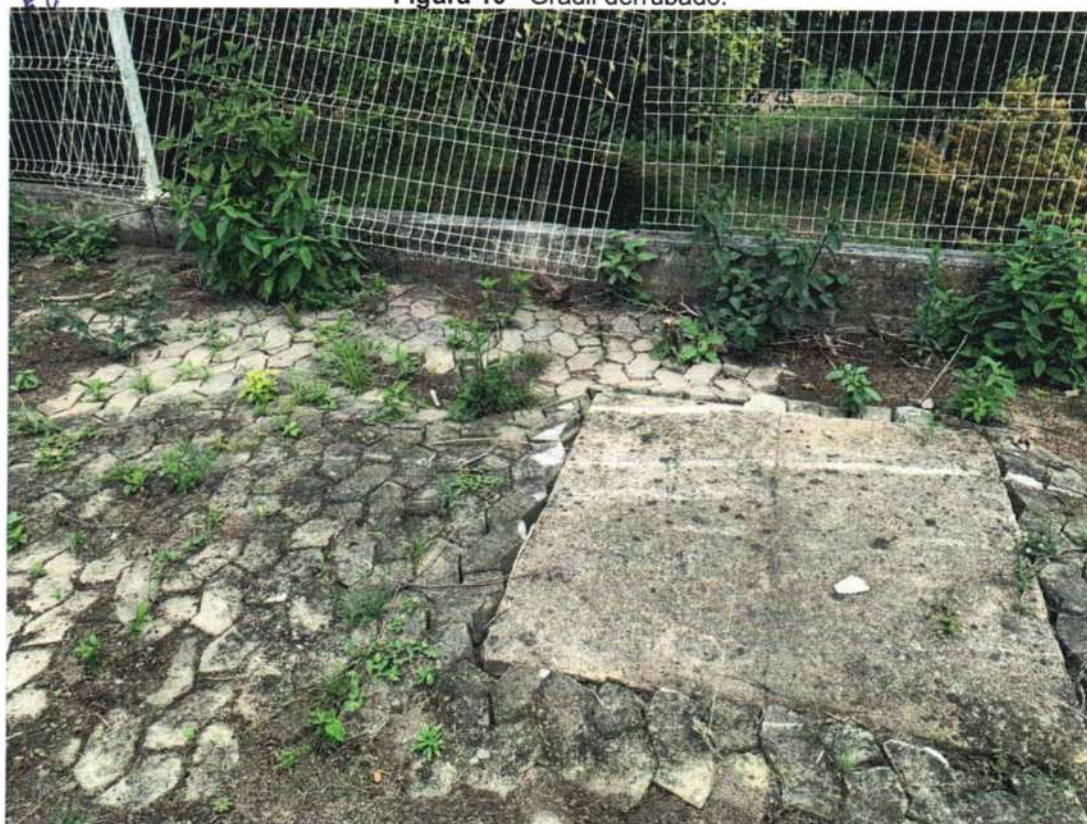
Figura 11 - Gradil derrubado/ risco de furto.
