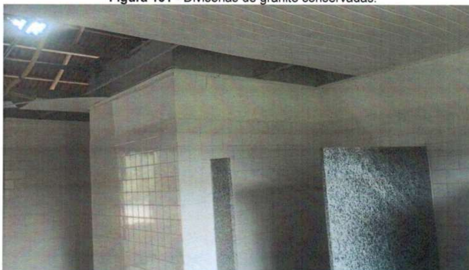
Figura 152 - Telhado avariado.
