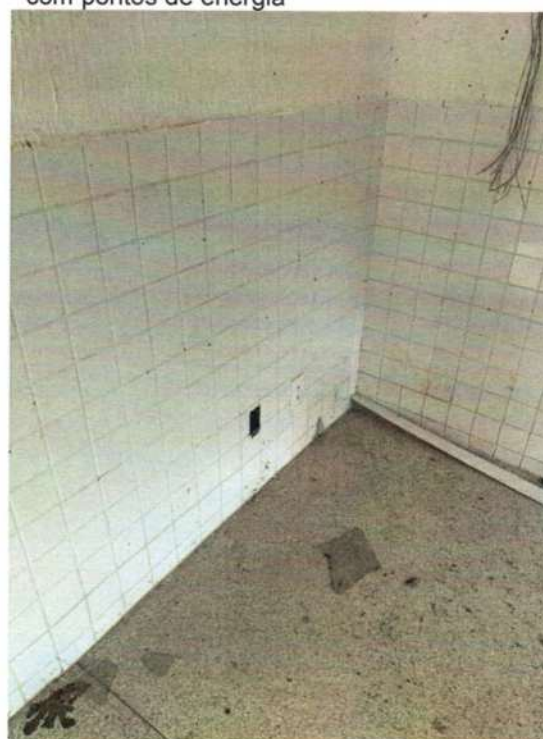
Figura 48 - Revestimento nas paredes conservado e pontos de tomada.
