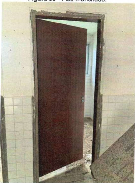
Figura 81 - Porta de banheiro anexo conservada, porém sem alisares e maçaneta.
