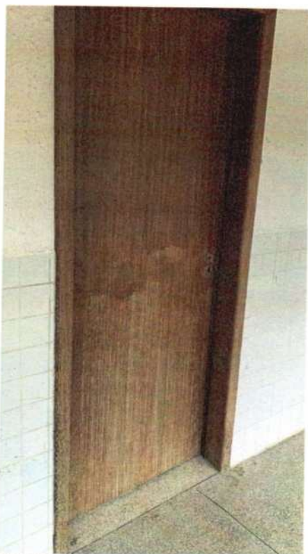
Figura 126 - Porta, alisares e marco conservados, sem fechadura e maçanetas
