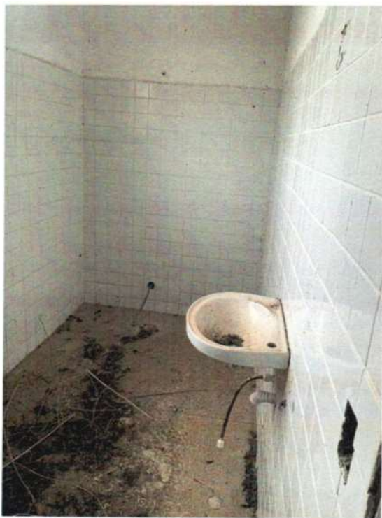
Figura 76 - Banheiro anexo sem vaso sanitário, mas com pia.
