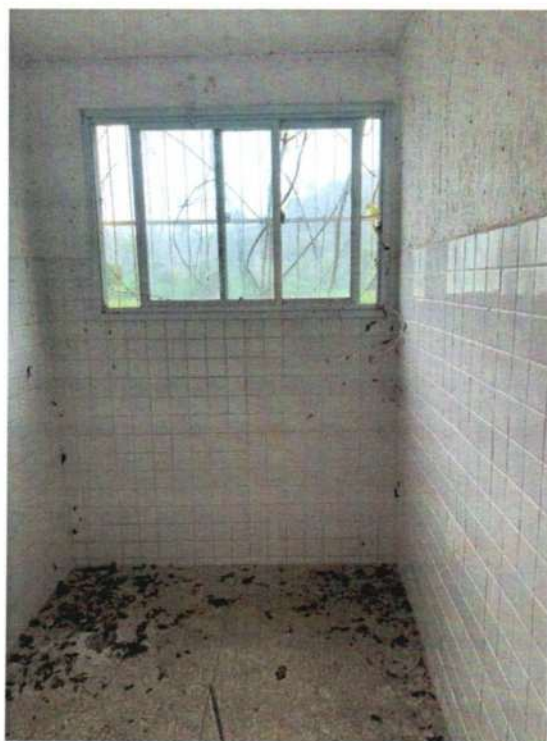
Figura 84 - Revestimento das paredes conservado.
