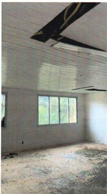
Figura 128 - Esquadrias conservadas, luminárias ausentes.
