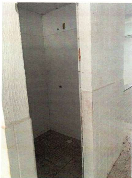
Figura 96 - Piso cerâmico conservado.
