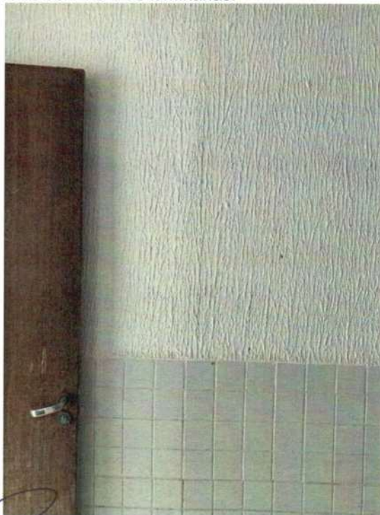
Figura 67 - Porta com maçaneta e fechadura conservadas.
