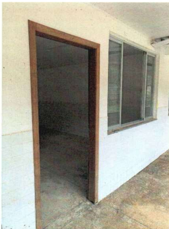
Figura 64 - Vão da porta com alisares e esquadria em bom estado.
