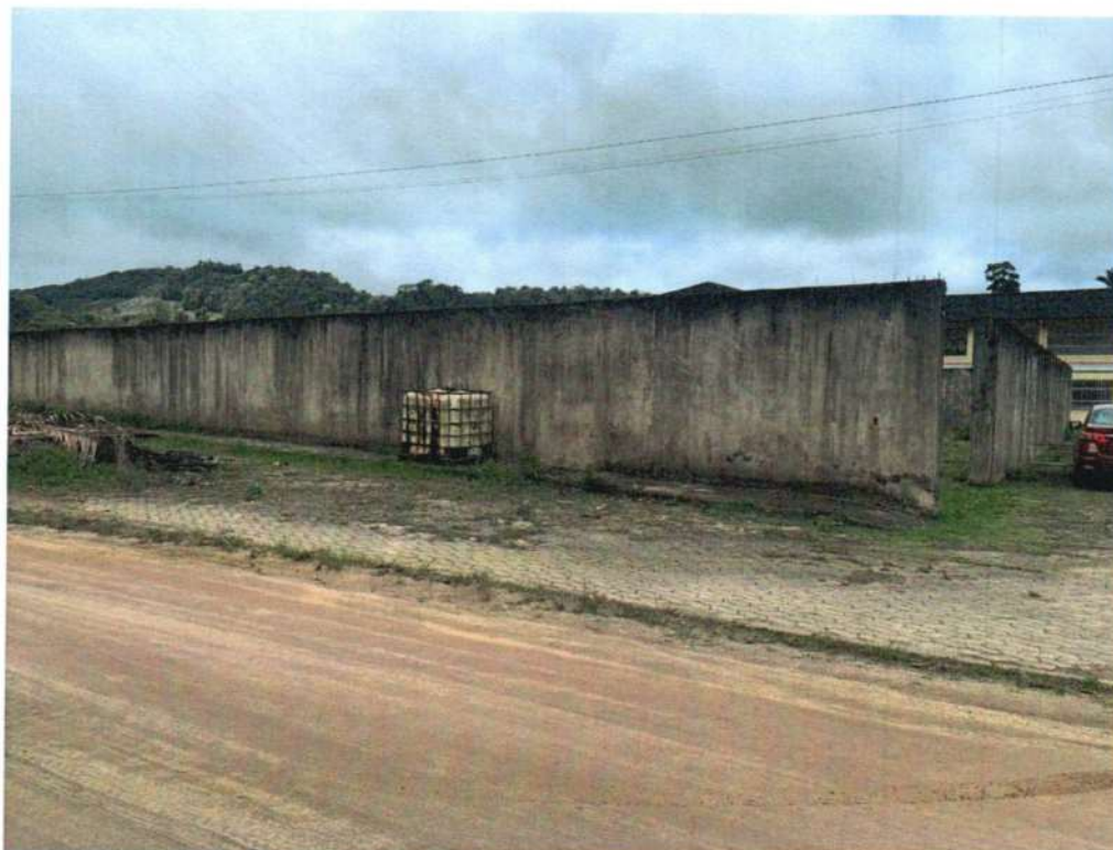
Figura 180 - Vista do muro da quadra de frente para a rua.
