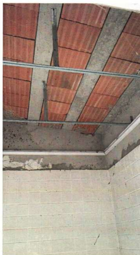
Figura 176 - Forro de PVC retirado.
