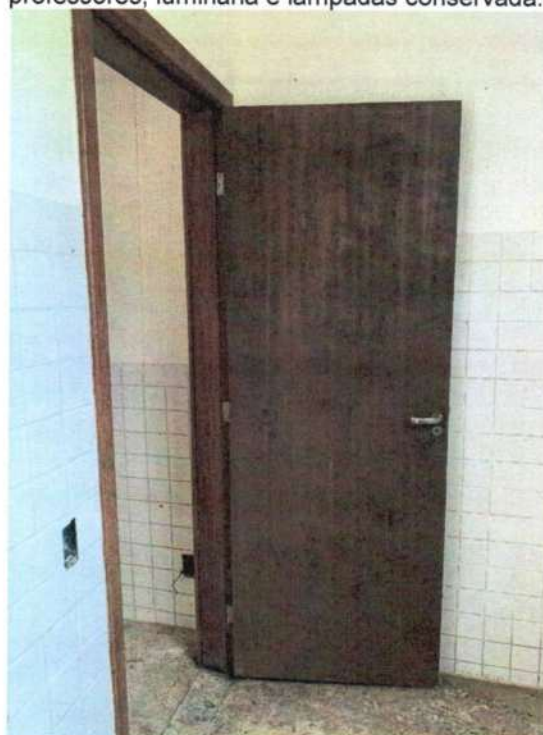
Figura 71 - banheiro anexo à sala dos professores, porta, fechadura, maçaneta, marco e alisares conservados.
