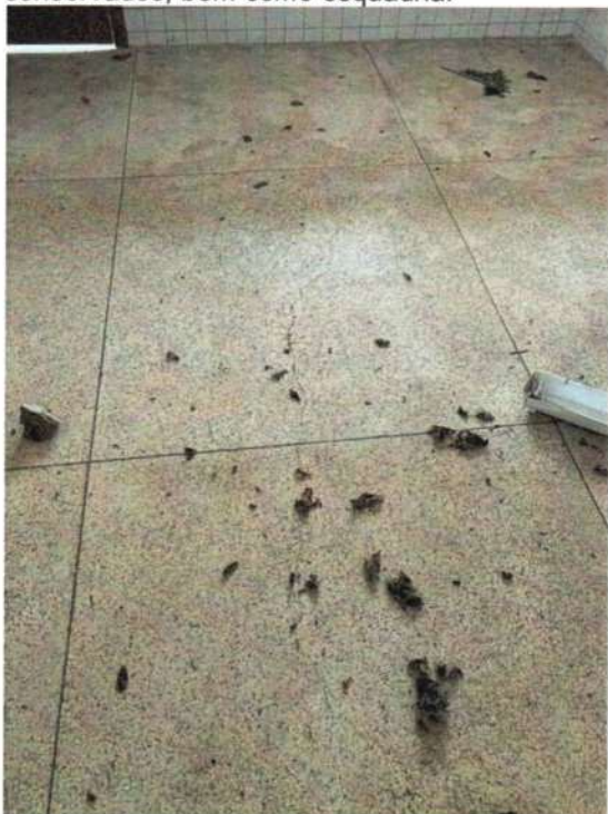
Figura 73 - Piso com fissuras.
