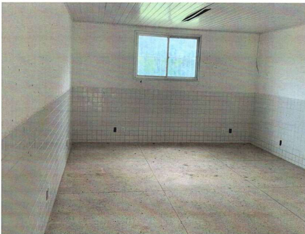
Figura 56 - Revestimento interno das paredes conservado, esquadria funcionando e pontos de tomada e rede presentes.
