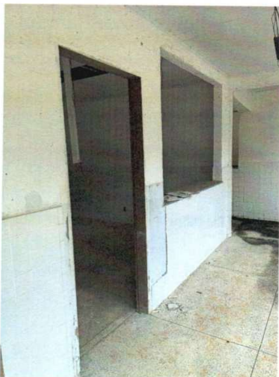
Figura 78 - Vãos de porta e janela com marco e peitoril conservados.
