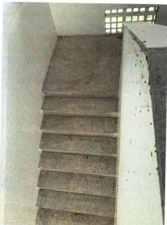
Figura 90 - Escada em bom estado de conservação.
