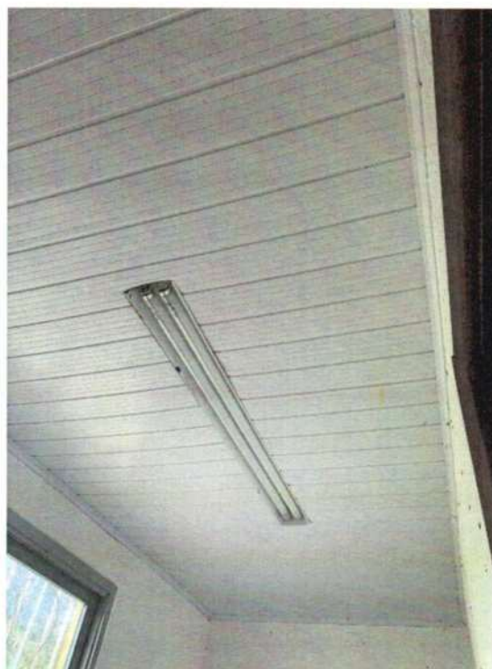
Figura 70 - banheiro anexo à sala dos professores, luminária e lâmpadas conservada.
