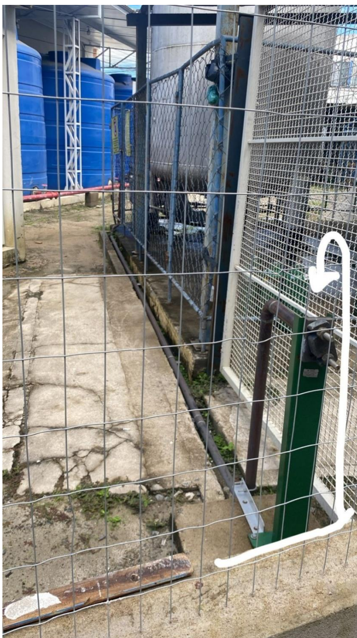
Ao fundo reservatório da água.
