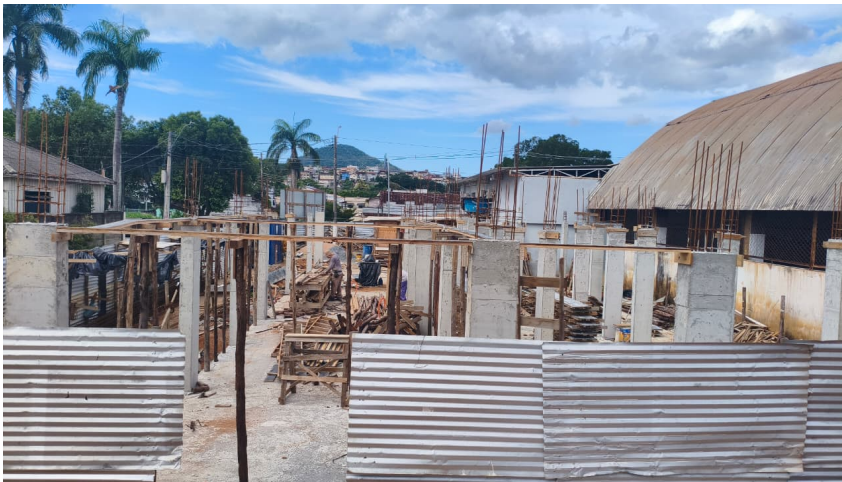
Foto da obra em andamento sede do CREAS
