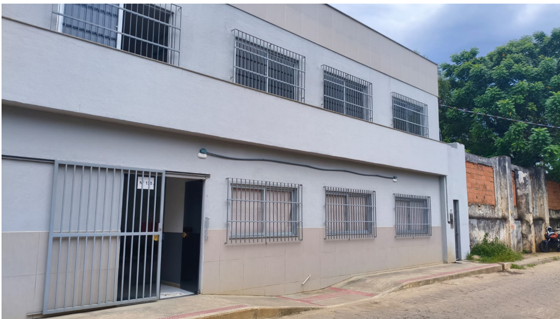
Foto da sede reformada da SEMTADES
