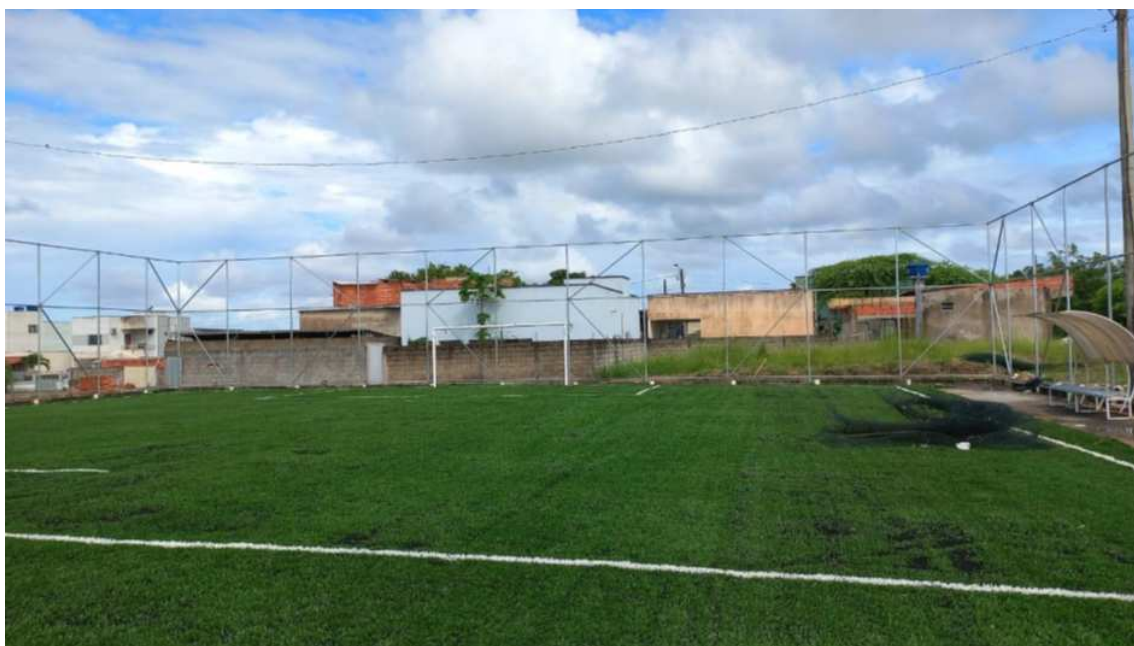
Reforma Campo Bom de Bola Água Limpa
