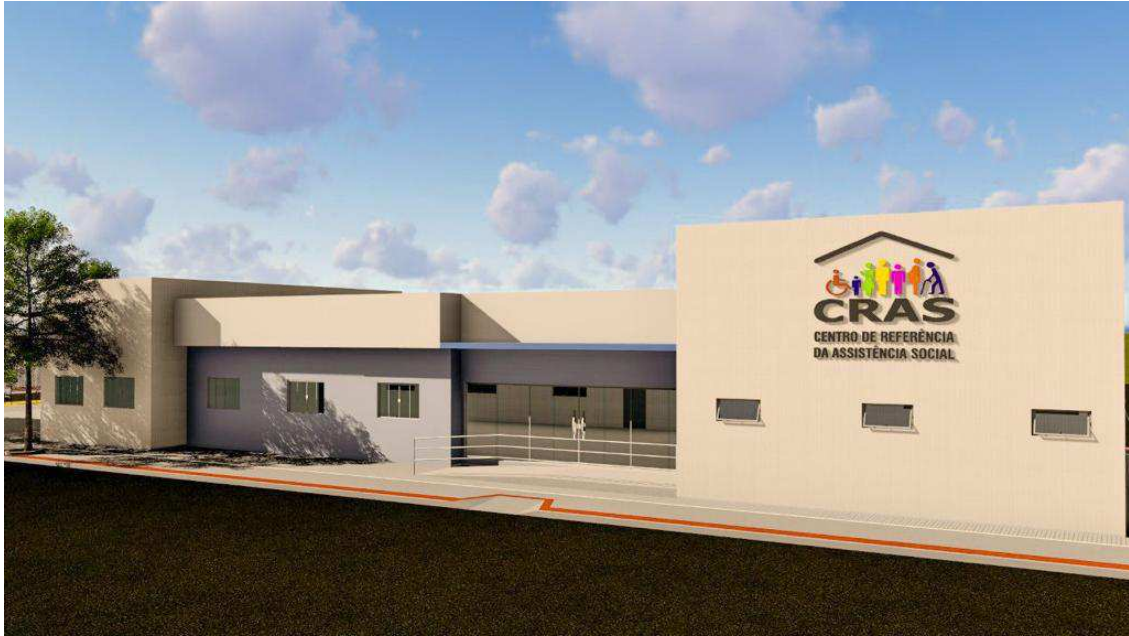
Projeto Construção CRAS
