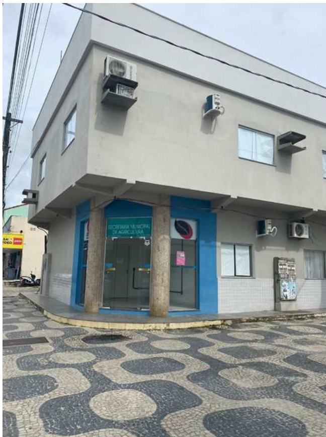
Reforma do Prédio da Secretaria de Obras e Meio Ambiente
