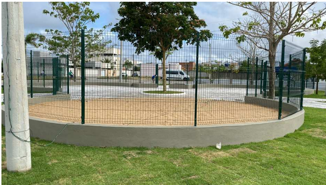
Construção da Praça do Riviera
