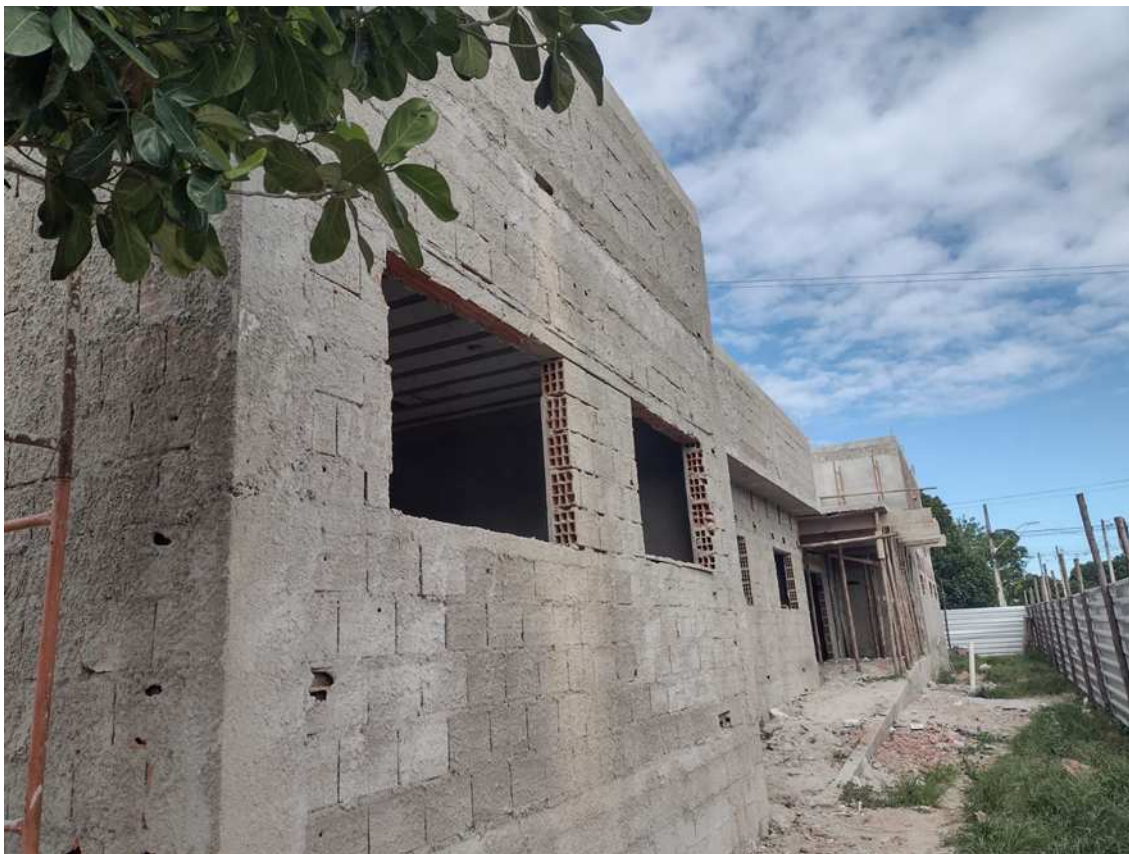
Construção do CRAS
