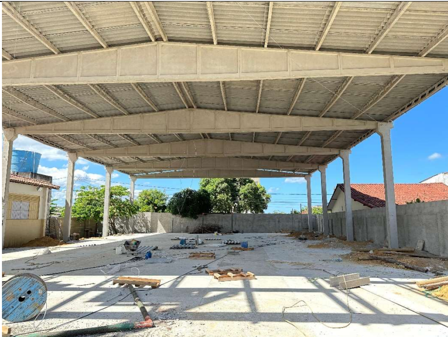
Item 02.01: Galpão Pré-moldado
