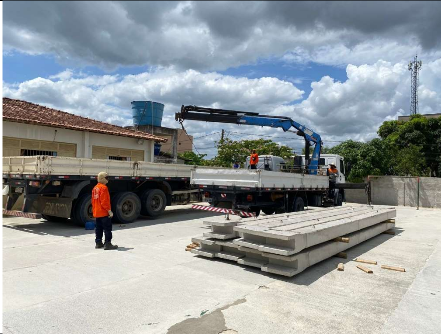
Item 02.01: Galpão Pré-moldado
