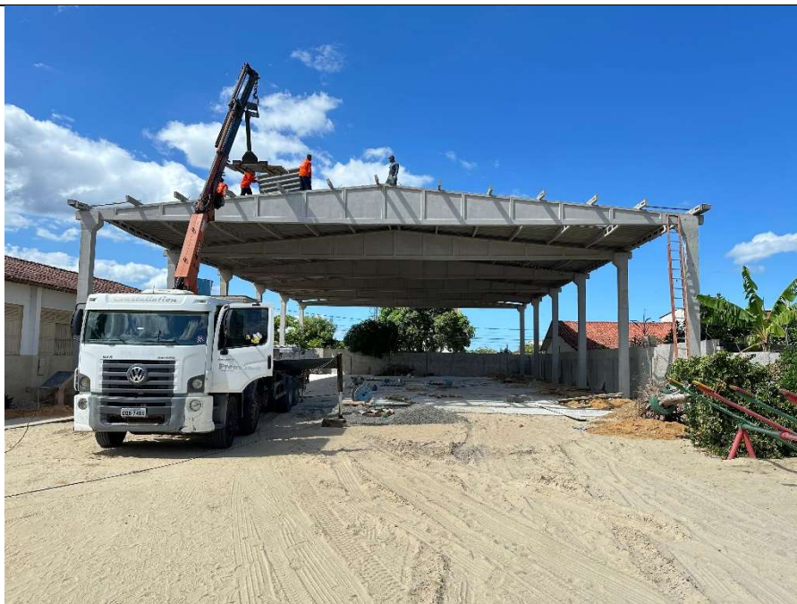
Item 02.01: Galpão Pré-moldado
