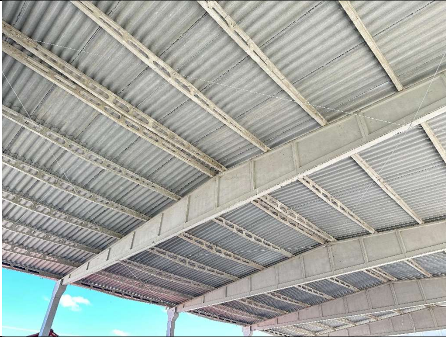
Item 02.01: Galpão Pré-moldado
