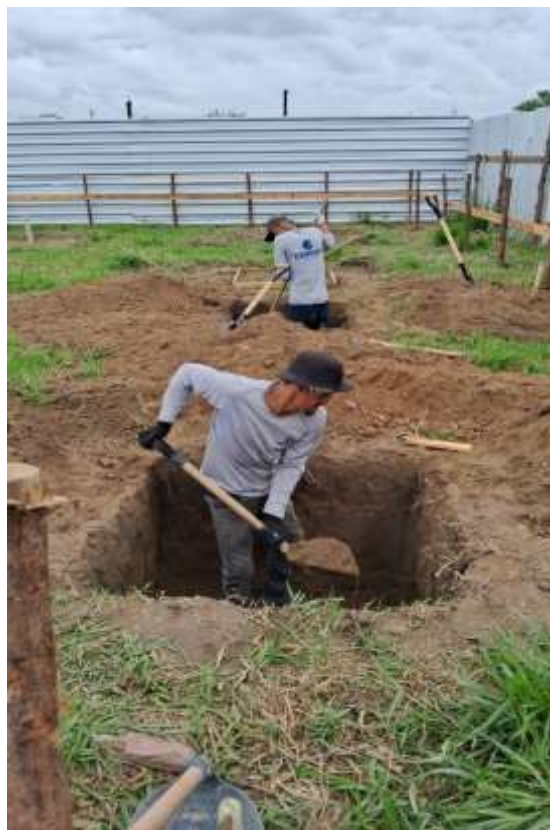
Foto 07 – Escavação Manual/Armadura aço sapatas – vista geral
