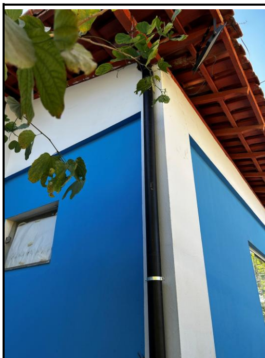
Foto 09: Eletroduto de entrada do quadro geral
