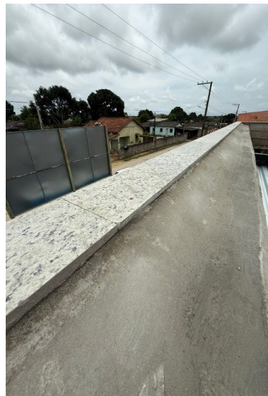
Foto 04: Execução de chapim
