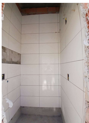
Foto 14: Execução de revestimento de parede
