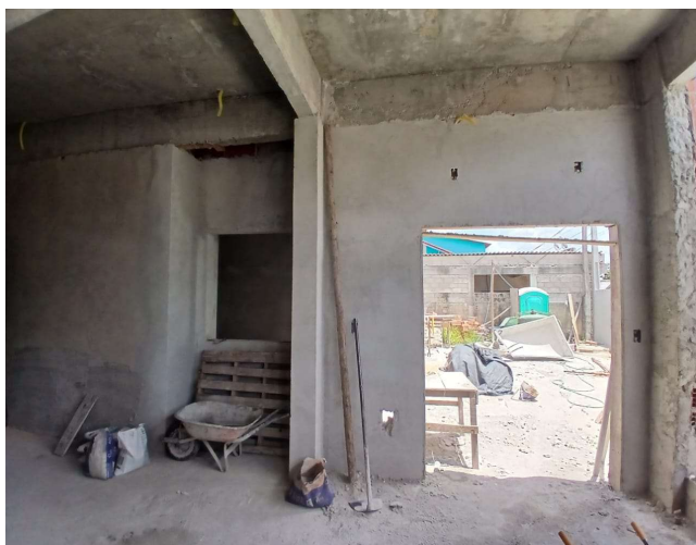
Foto 01: Execução de reboco interno
