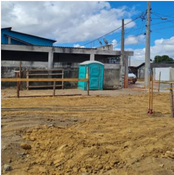
Foto 12- Canteiro de obras - sanitário 01.
