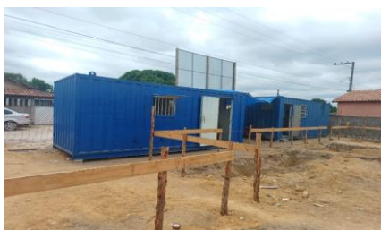
Foto 07- Barracão canteiro de obras. - frente 02
