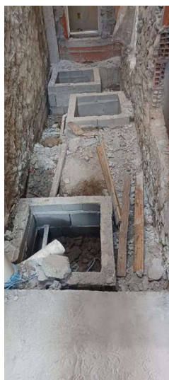
Foto 23: Caixas de inspeção
