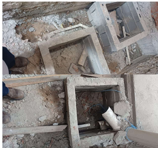
Foto 24: Caixas de inspeção
