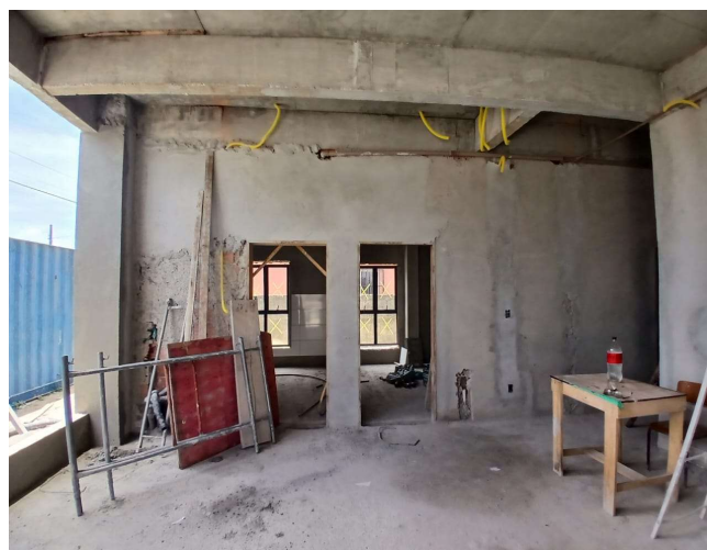
Foto 02: Execução de reboco interno
