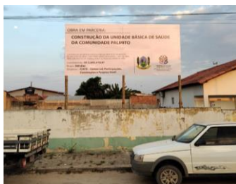
Foto 01 - Placa de obra nas dimensões de 2x4m
