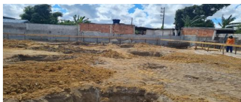
Foto 09 - Abertura de vala para instalação de sapatas da fundação.
