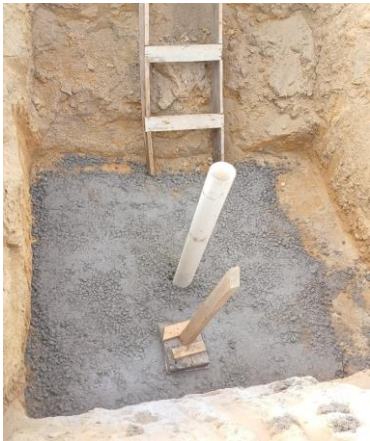
Foto 16- Sapatas com aplicação de concreto magro
