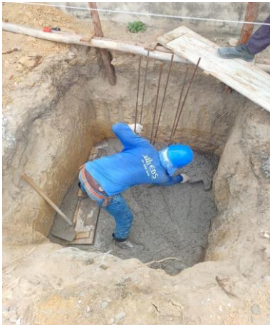
Foto 15- Armação de sapatas com aplicação de concreto magro
