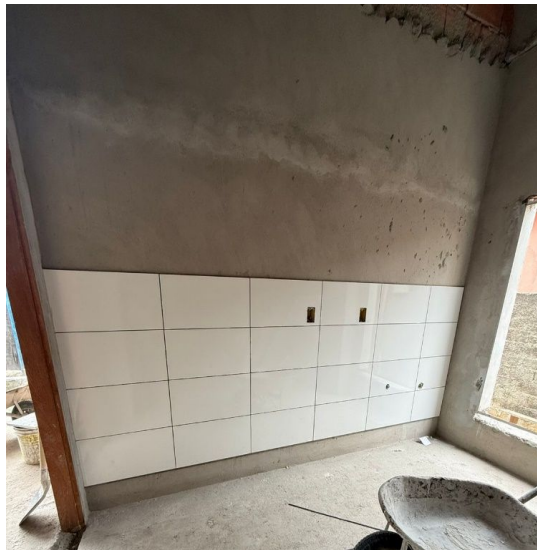
Foto 02: Execução de revestimento de parede
