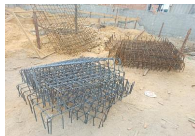
Foto 06 - Armação de estrutura - Sapatas
