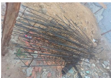
Foto 05 - Armação de estrutura - Sapatas
