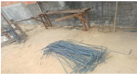
Foto 14 - Armação para as sapatas de fundação.
