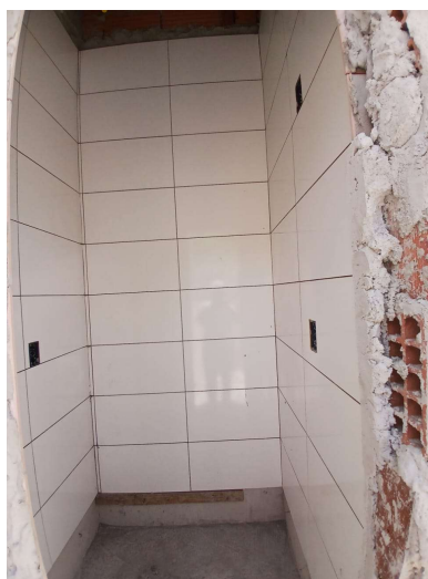
Foto 13: Execução de revestimento de parede
