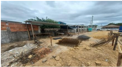
Foto 13 - Armação para as sapatas de fundação.
