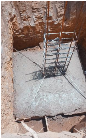
Foto 17- Armação de sapatas com aplicação de concreto magro
