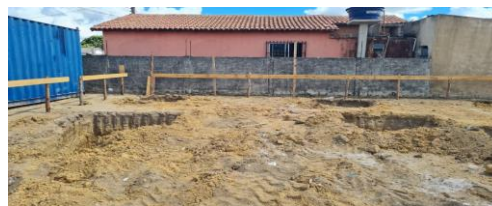
Foto 10- Locação de gabarito e cavas da fundação.
