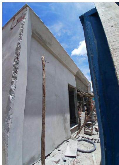
Foto 06: Execução de reboco externo
