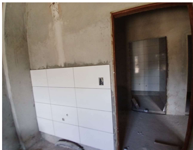
Foto 05: Execução de revestimento de parede
