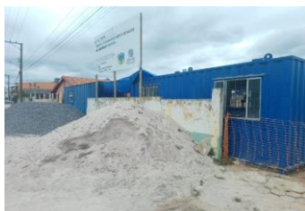
Foto 03 - Canteiro de obras - frente 01.
