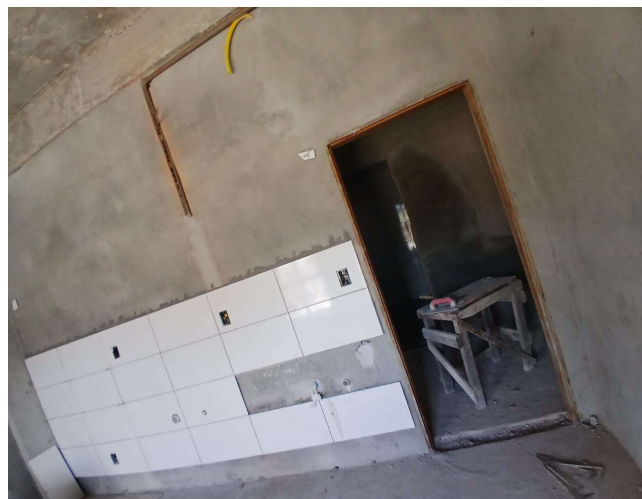
Foto 02: Execução de reboco interno
