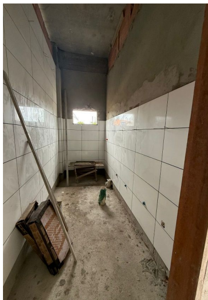
Foto 03: Execução de revestimento de parede
