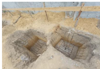
Foto 04 - Armação de estrutura - Sapatas
