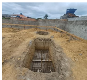
Foto 08- Armação de sapatas com aplicação de concreto magro
