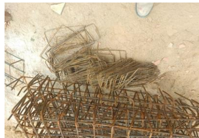
Foto 02 - Armação de estrutura - Sapatas
