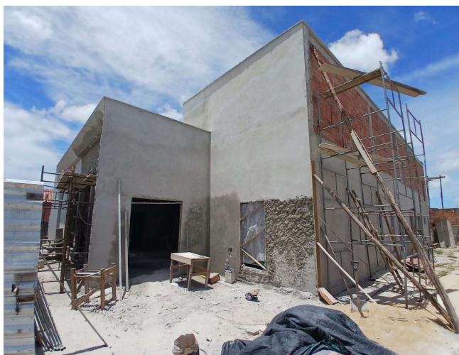
Foto 03: Execução de reboco externo
