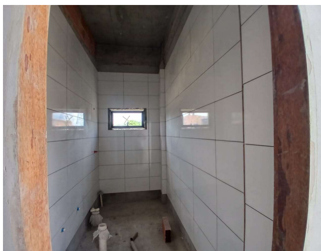
Foto 15: Execução de revestimento de parede
