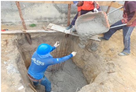
Foto 16- Armação de sapatas com aplicação de concreto magro
