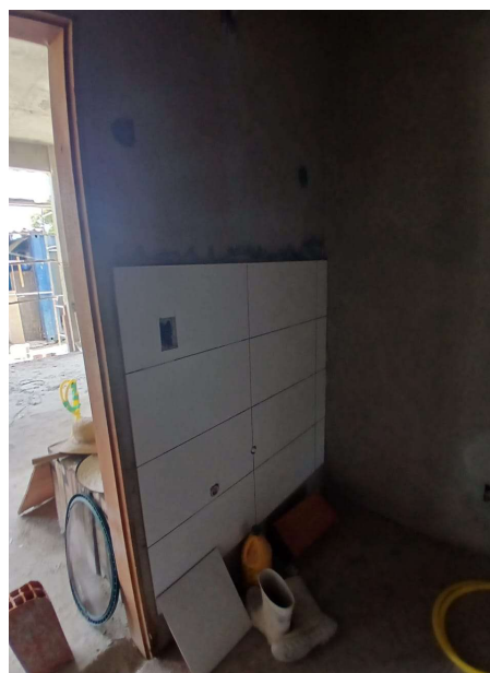
Foto 10: Execução de revestimento de parede
