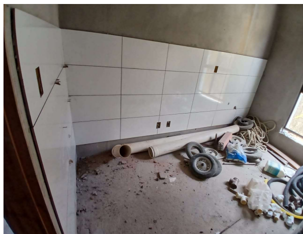
Foto 17: Execução de revestimento de parede
