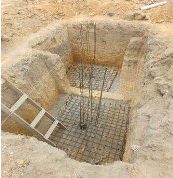
Foto 11 - Armação de sapatas com aplicação de concreto magro.
