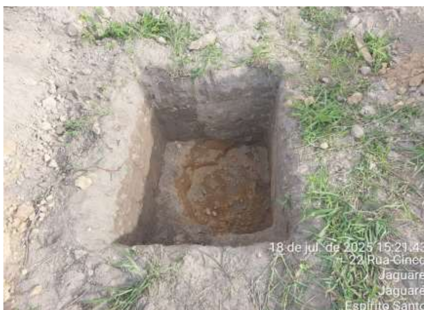
Foto 03 – Escavação de Sapatas
