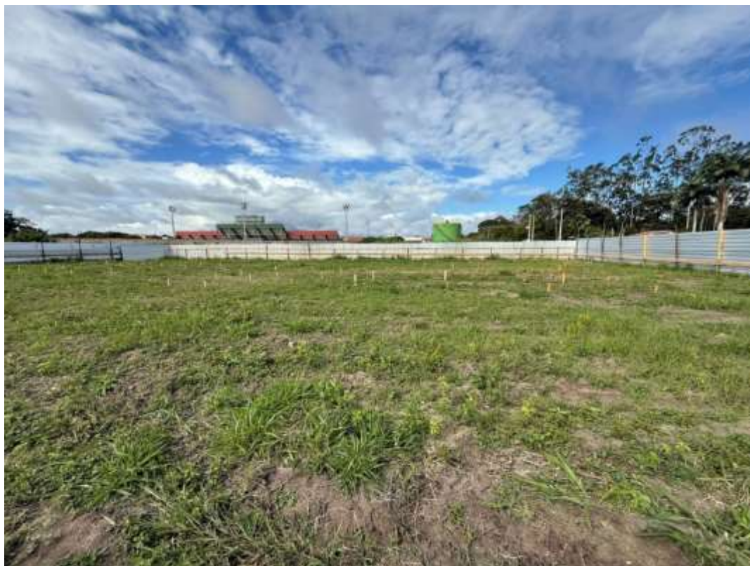
Foto 01 – Equipe Topográfica – Marcação Sapatas
