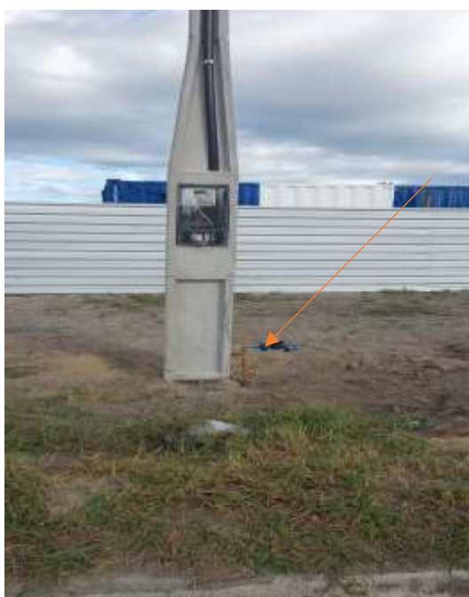
Provisória de água e esgoto/Provisória de Energia elétrica
