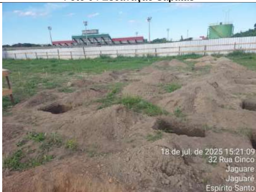
Foto 05 Escavação Sapatas
