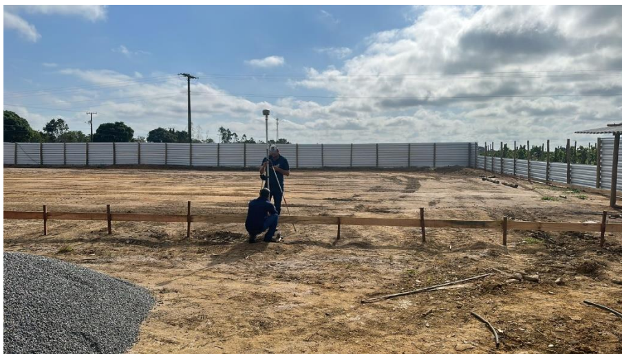
Foto 9 – Locação de vestiários e EMEF (ITENS 02.03 e 18.06)
