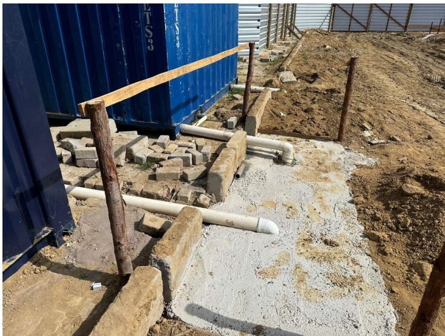
Foto 5 – Ligação de esgoto para contêineres (ITEM 01.11)
