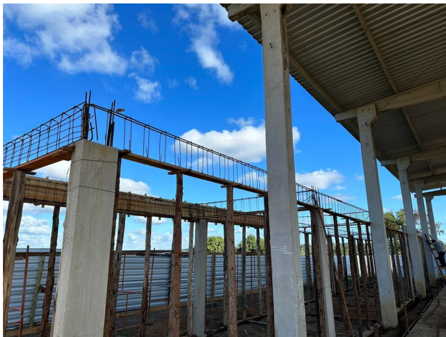
Foto 21 – Vigas vestiário montadas (ITENS 20.05 e 20.06)
