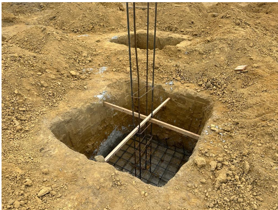
Fotos 18 e 19 – Sapatas com concreto magro e ferragens (ITENS 04.01, 04.05, 04.07, 20.01, 20.05 e 20.06)
