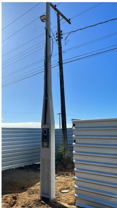
Foto 11 – Rede de luz padrão instalado (ITEM 01.10)
