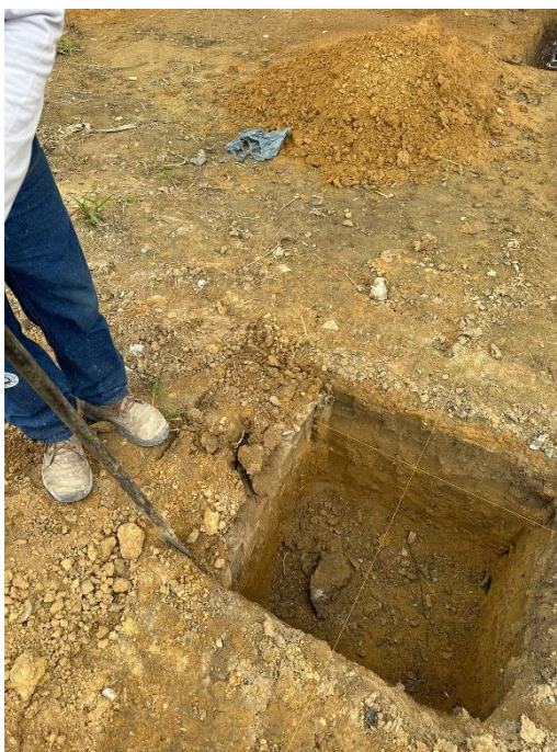
Foto 5 – Ligação de esgoto para contêineres (ITEM 01.11)
