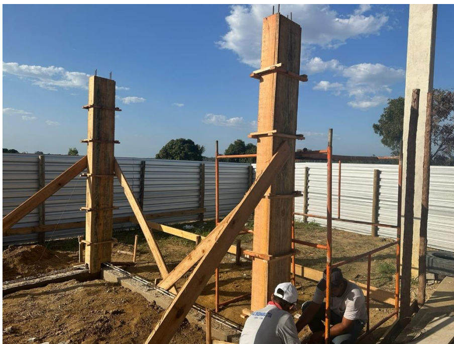
Foto 16 – Fôrmas dos pilares do vestiário instalados (ITEM 20.03)
