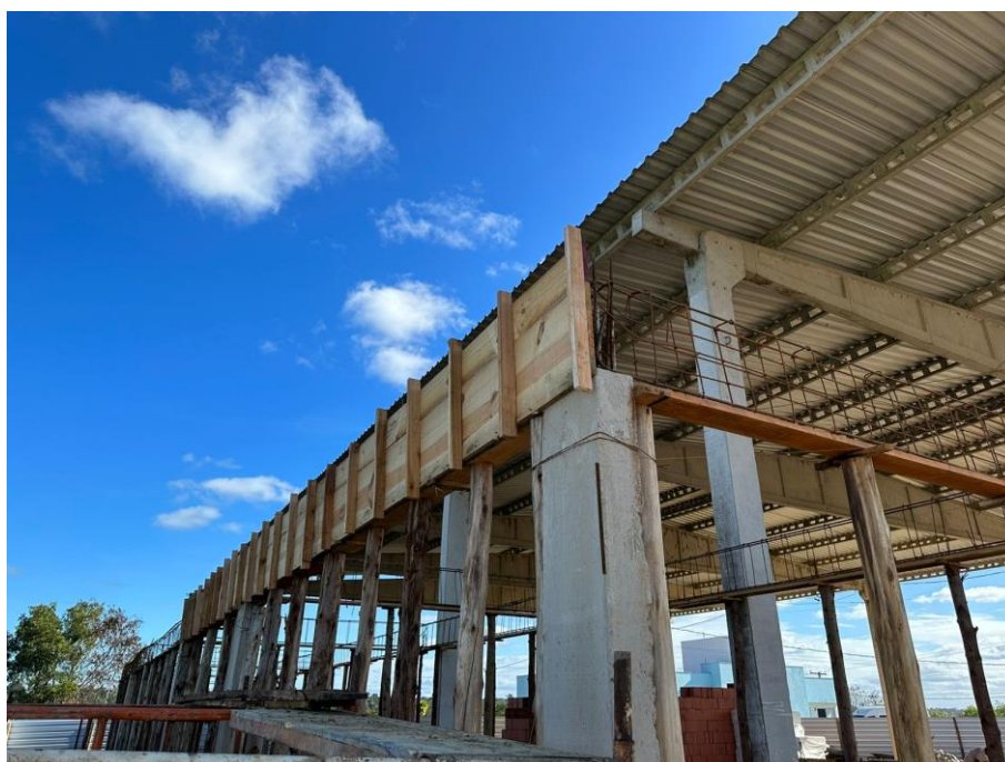
Foto 22 – Forma das vigas do vestiário sendo instaladas (ITENS 20.03)
