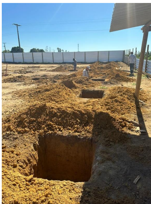
Fotos 6, 7 e 8 – Escavação de sapatas e cintas dos vestiários da quadra e sapatas da EMEF (ITENS 03.01 e 19.01)
