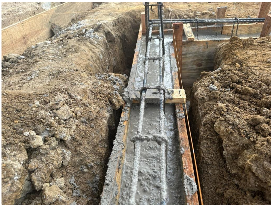
Fotos 12 e 13 – Sapatas e cintas concretadas (ITENS 20.02)
