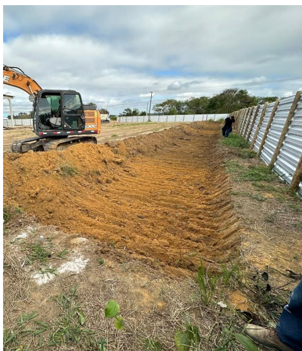
Foto 10 – Limpeza de terreno (ITEM 02.01)
