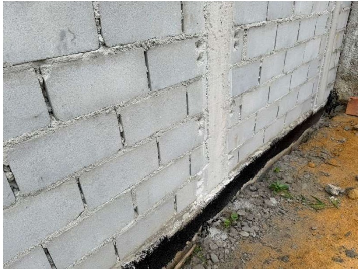
Execução do muro com bloco de 9cm.
