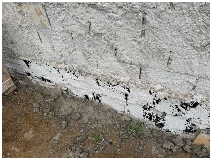
Execução do muro com bloco de 9cm.
