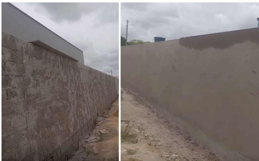
Execução do muro com bloco de 9cm.
