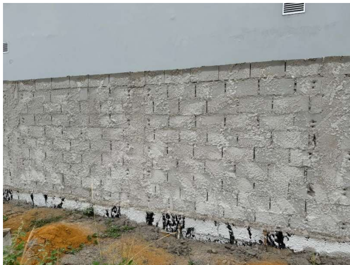
Execução do muro com bloco de 9cm.
