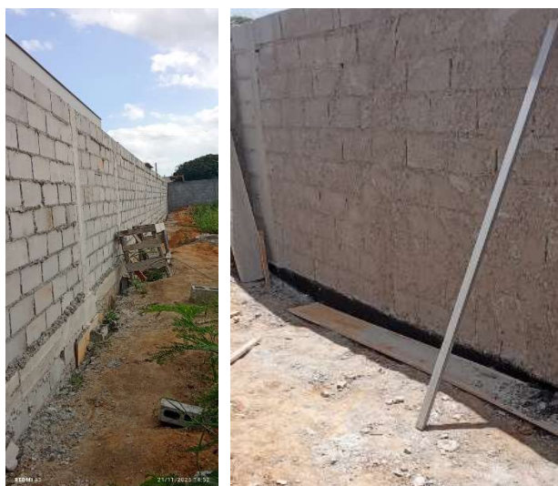
Execução do muro com bloco de 9cm.
