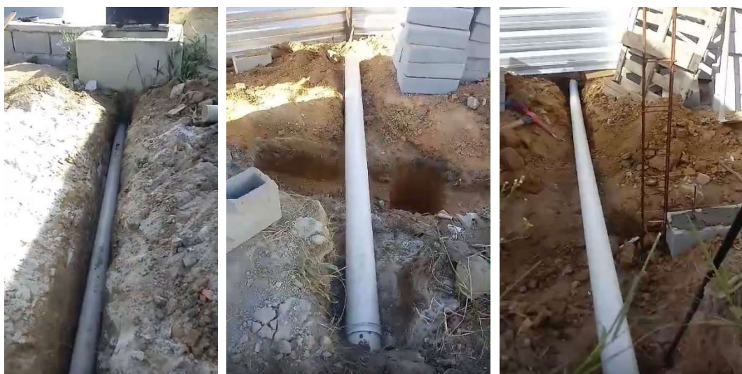
Execução da ligação dos tubos de esgoto e pluvial.
