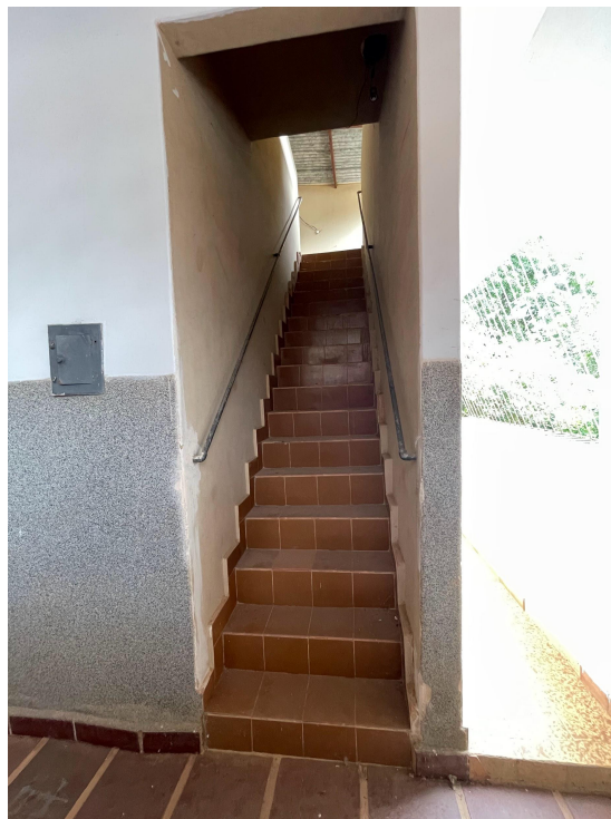
IMAGEM 26 - ESCADA DE ACESSO AO TERRAÇO
