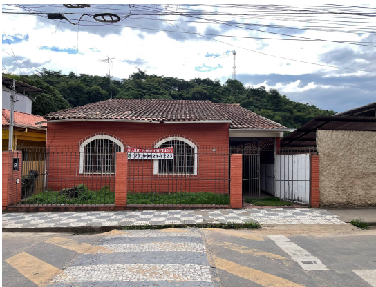
IMAGEM 01 - FACHADA DO IMÓVEL
