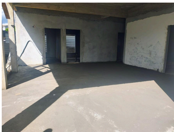
Foto 1 - Execução de Contrapiso
