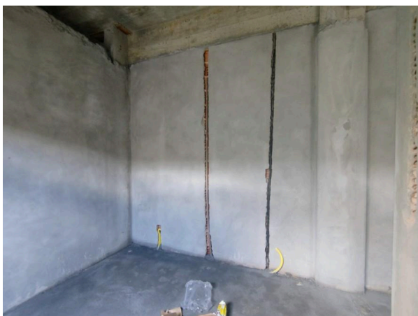
Foto 5 - Execução de instalações hidráulicas e elétricas
