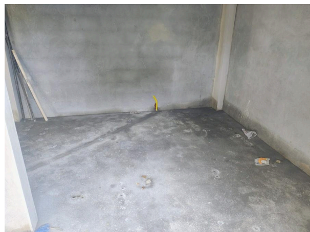
Foto 2 - Execução de Contrapiso
