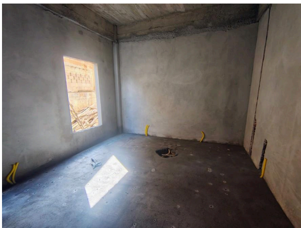
Foto 3 - Execução de Contrapiso
