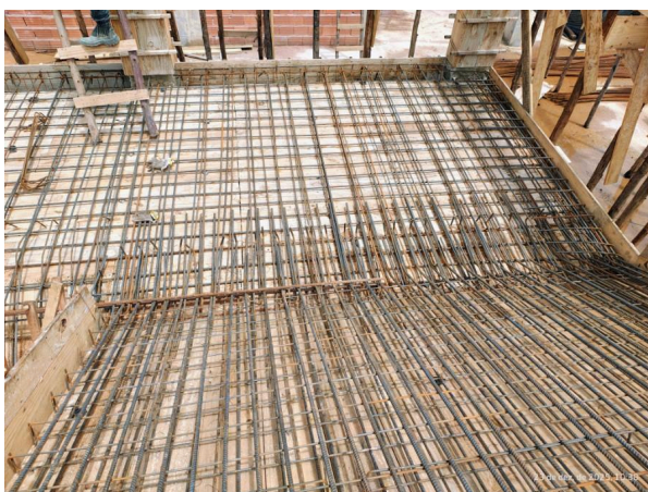
Foto 03 – Armaduras de escada.
