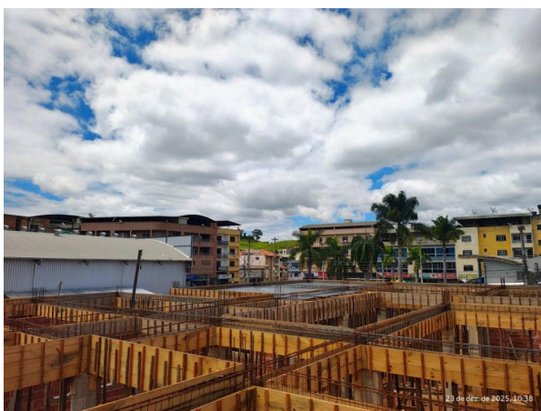
Foto 01 – Forma e Armadura de vigas.
