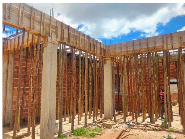
Foto 02 – Forma de vigas.
