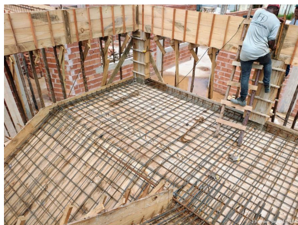
Foto 04 – Armaduras de escada.
