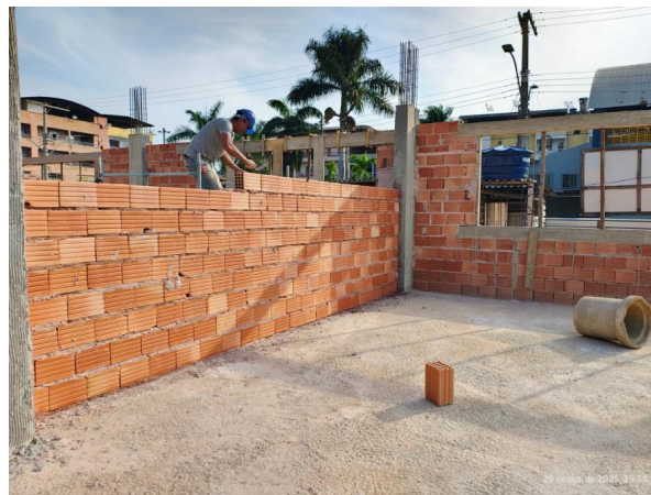
Foto 06 – Execução de alvenaria.
