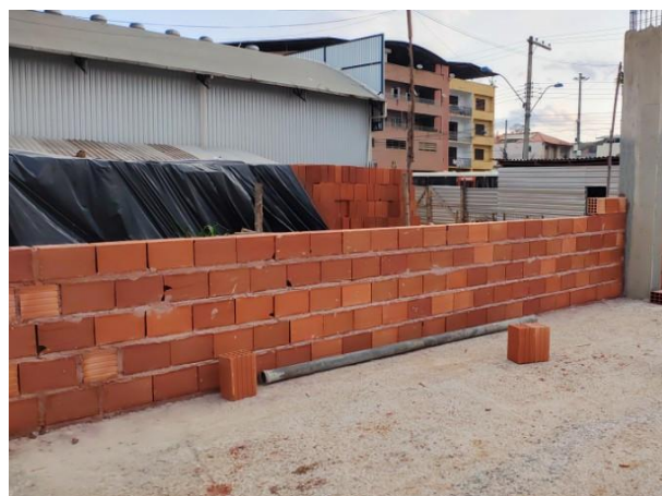
Foto 04 – Execução de alvenaria.
