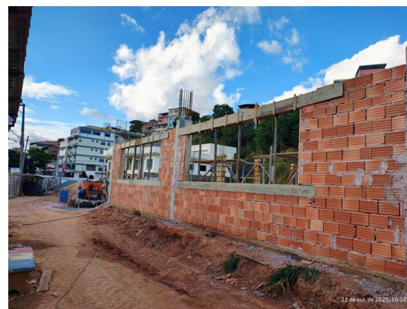
Foto 08 – Execução de vergas dos vãos das janelas.
