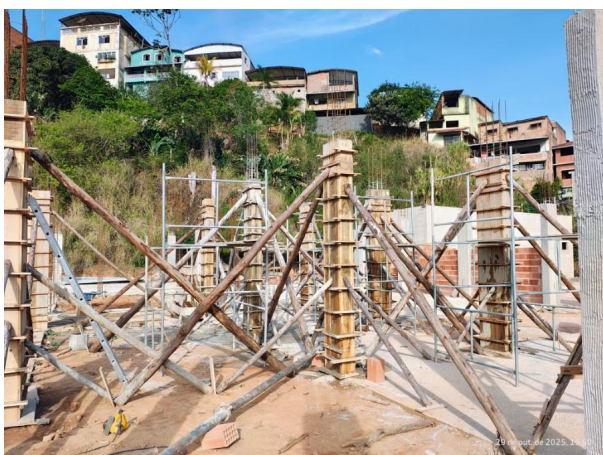
Foto 03 – Concretagem dos pilares.
