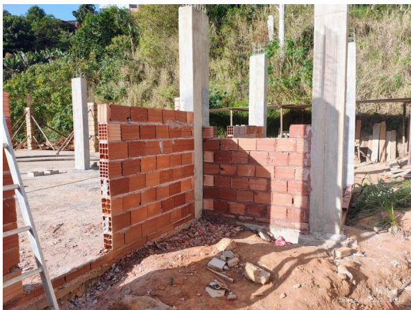
Foto 05 – Execução de alvenaria.
