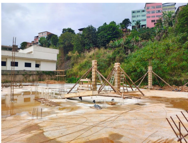
Foto 01 – Concretagem dos pilares.
