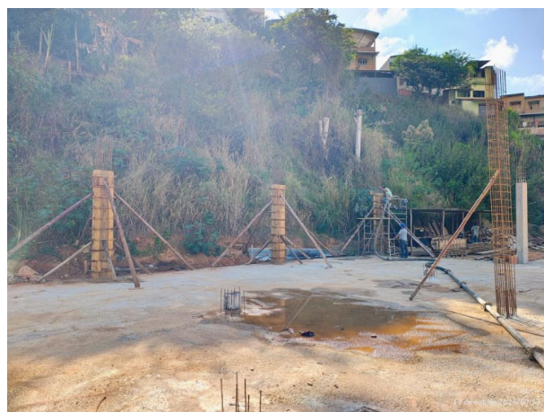
Foto 02 – Concretagem dos pilares.
