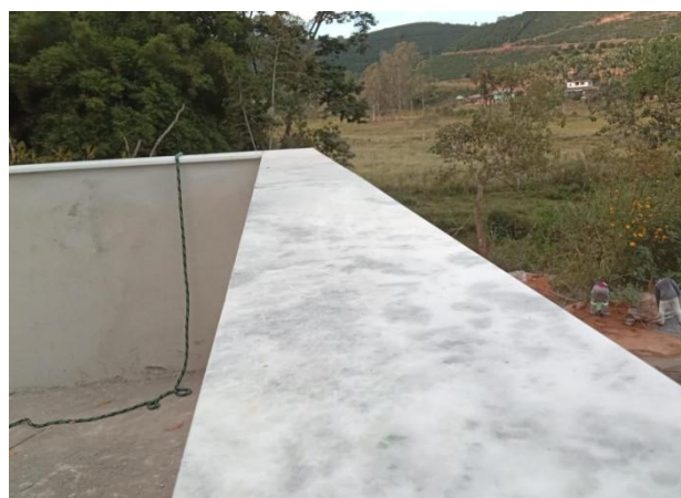
Foto 06 – Execução de chapim sobre muros da laje do vestiário.
