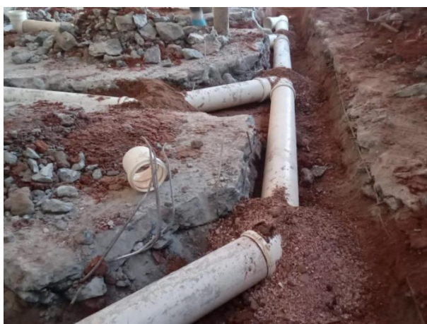
Foto 05 – Execução das instalações de esgoto.
