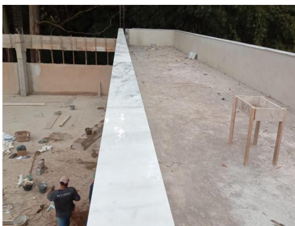
Foto 07 – Execução de chapim sobre muros da laje do vestiário.
