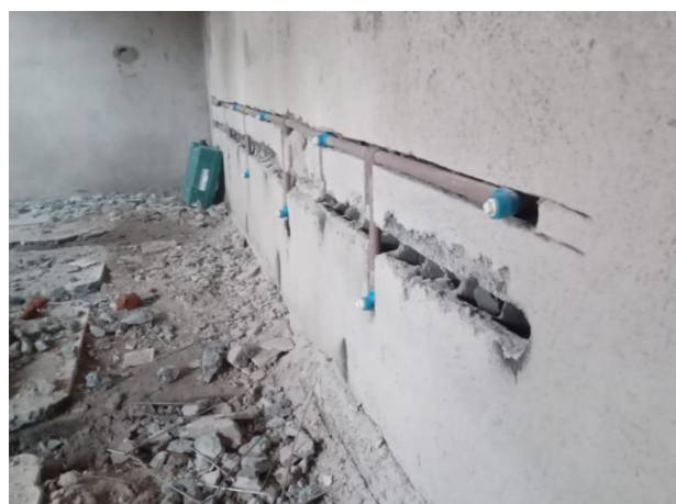
Foto 04 – Execução das instalações de água fria.
