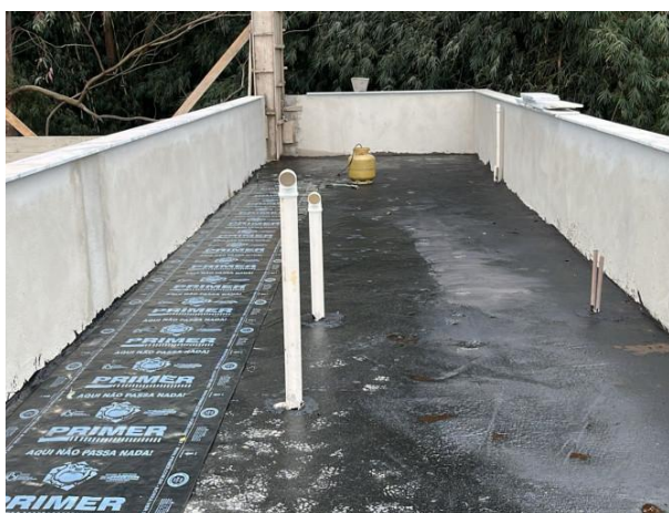
Foto 03 – Instalação da manta de impermeabilização na laje do vestiário.
