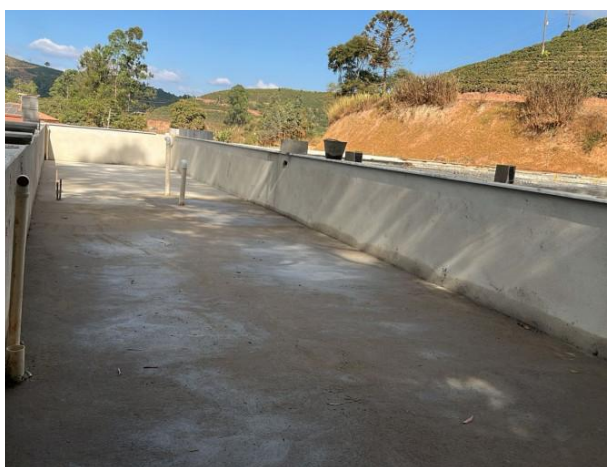
Foto 01 – Execução do contrapiso da laje do vestiário .
