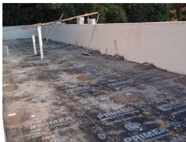
Foto 02 – Instalação da manta de impermeabilização na laje do vestiário.
