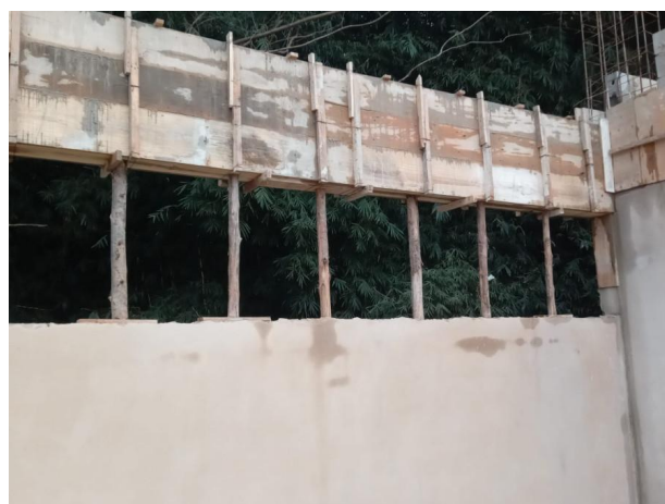
Foto 08 – Colocação de armadura, forma e concretagem das vigas da quadra.
