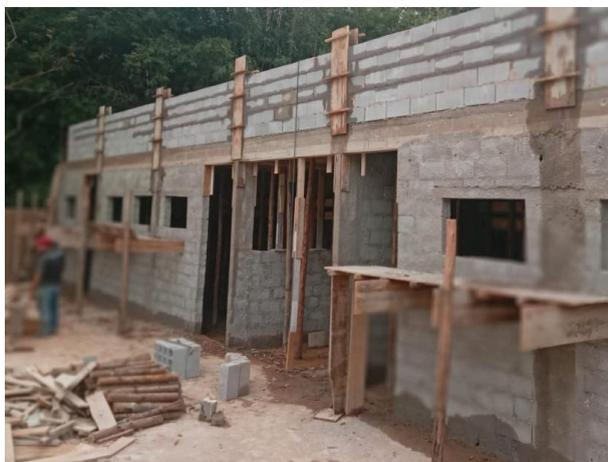
*Foto 01 – Alvenaria da platibanda do vestiário .*
