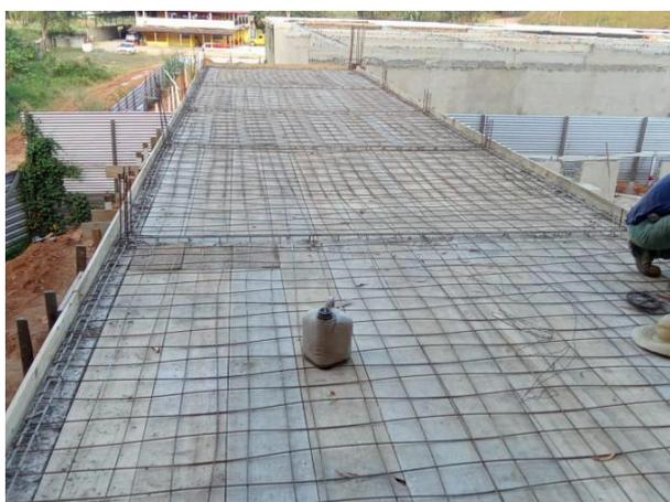
*Foto 05 – Colocação da armadura da laje do vestiário.*
