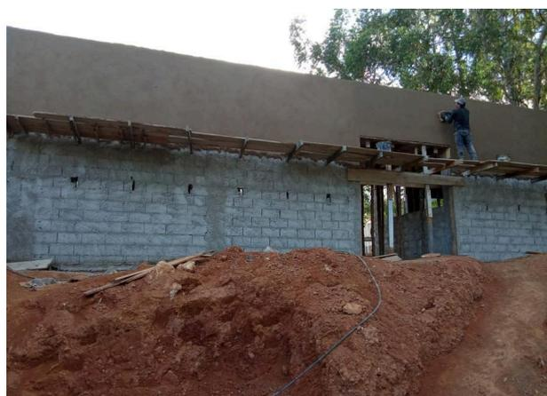
*Foto 06 - Execução de Reboco das paredes do vestiário.*
