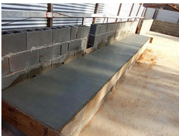
*Foto 03 – Concretagem dos assentos da arquibancada.*
