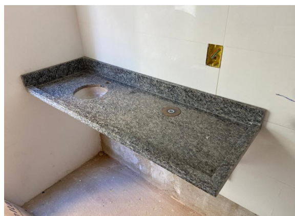
Foto 04 – Instalação de bancadas de granito.
