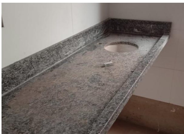
Foto 05 – Instalação de bancadas de granito.
