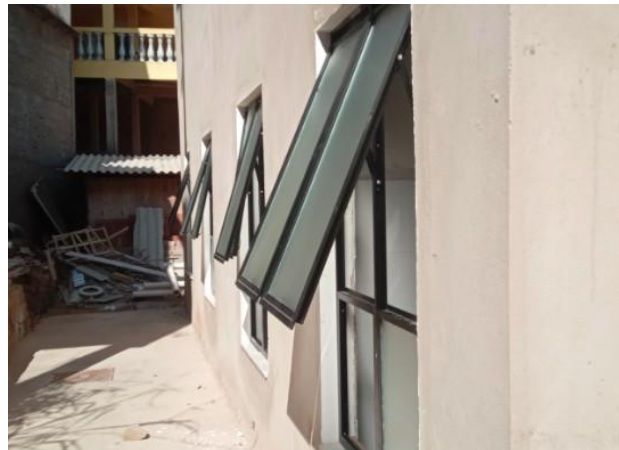
Foto 02 – Instalação das Esquadrias Metálicas.
