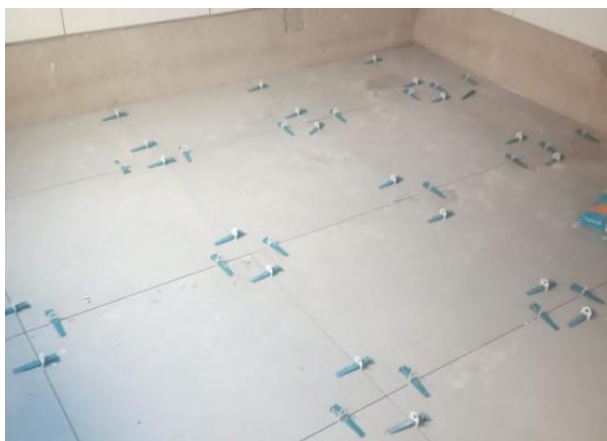
Foto 07 – Instalação de porcelanato no piso.
