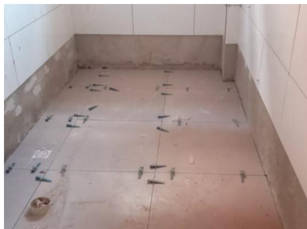
Foto 06 – Instalação de porcelanato no piso.
