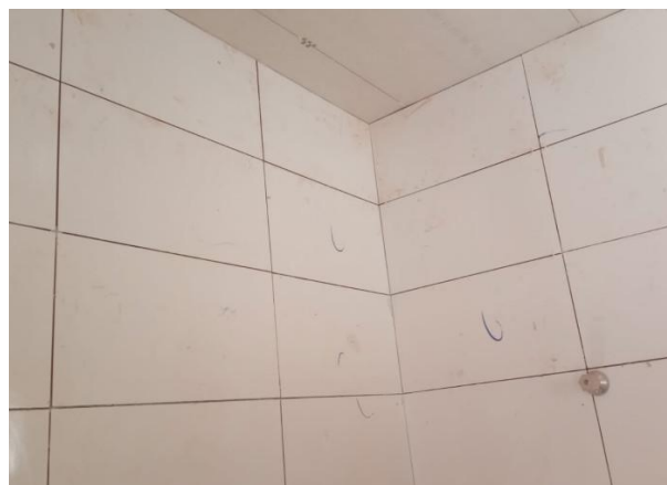
Foto 08 – Instalação de porcelanato na parede.
