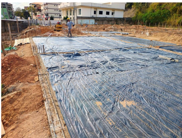
Foto 07 – Colocação de lona para concretagem da laje de fundação
