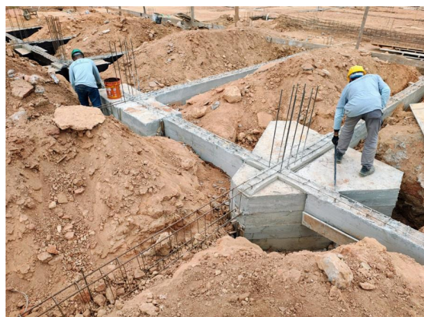
Foto 04 – Concretagem das vigas e dos blocos de fundação.
