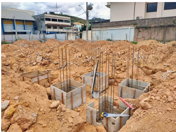
Foto 01 – Execução das formas e colocação das armaduras nos blocos de fundação.
