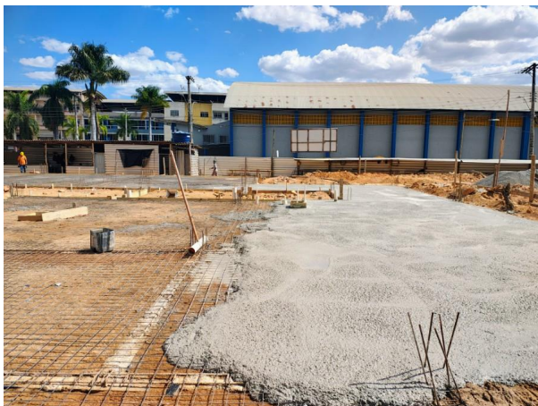
Foto 09 – Concretagem da laje de fundação.
