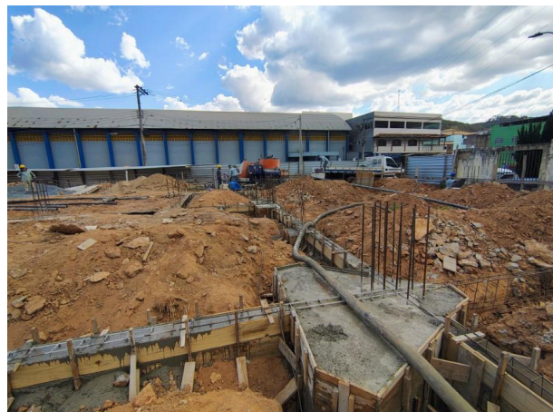
Foto 06 – Concretagem das vigas e dos blocos de fundação.
