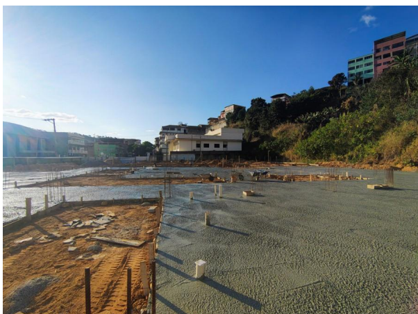
Foto 10 – Concretagem da laje de fundação.
