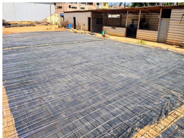
Foto 08 – Colocação de lona e armação para concretagem da laje de fundação
