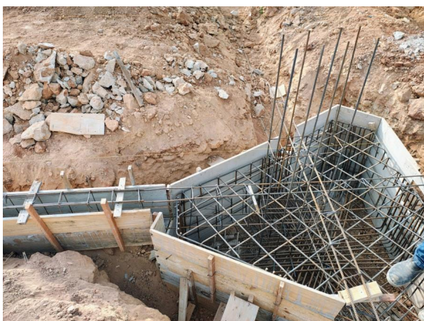
Foto 03 – Execução das formas e colocação das armaduras nos blocos de fundação.
