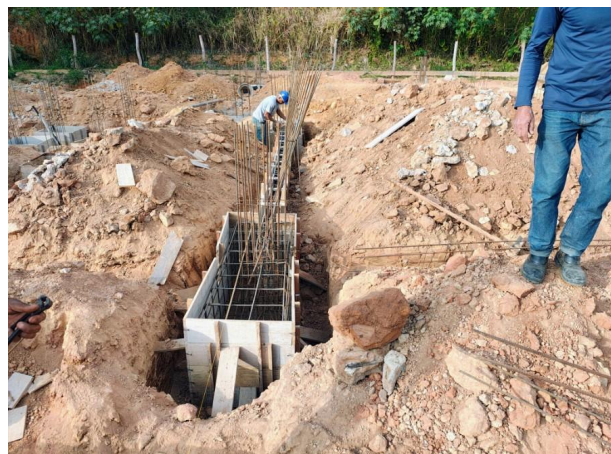
Foto 02 – Execução das formas e colocação das armaduras nos blocos de fundação
