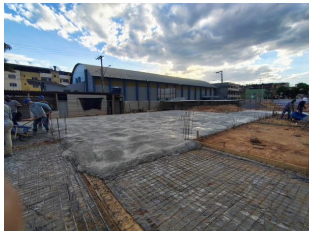
Foto 09 – Concretagem da laje de fundação.
