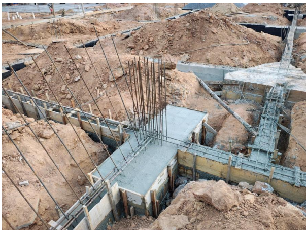
Foto 05 – Concretagem das vigas e dos blocos de fundação.
