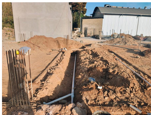
Foto 06 – Instalação de tubos e conexões de esgoto.
