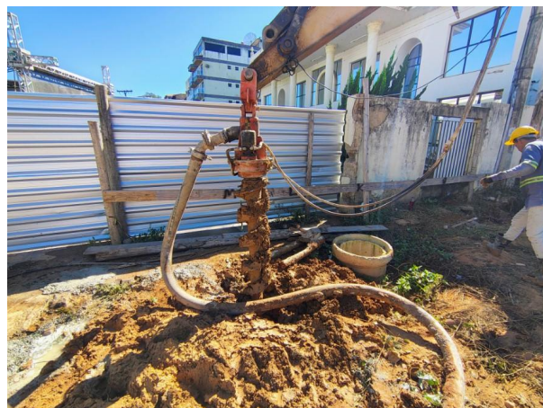
Foto 02 – Execução das estacas.
