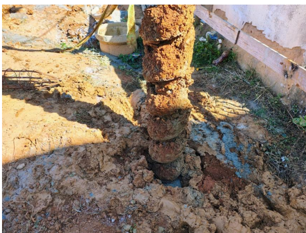
Foto 03 – Execução das estacas.
