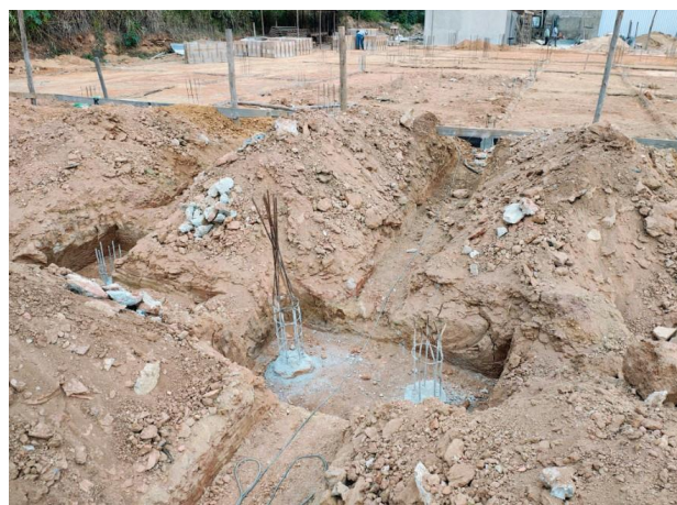
Foto 04 – Execução do arrasamento das estacas.
