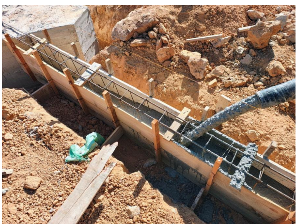
Foto 07 – Concretagem das vigas baldrame e blocos da fundação.
