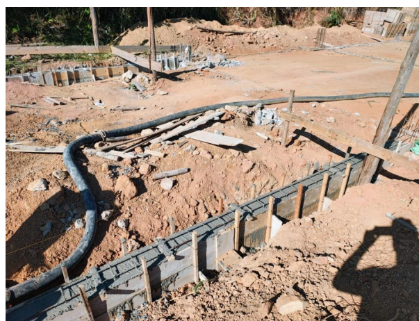
Foto 08 – Concretagem das vigas baldrame e blocos da fundação.
