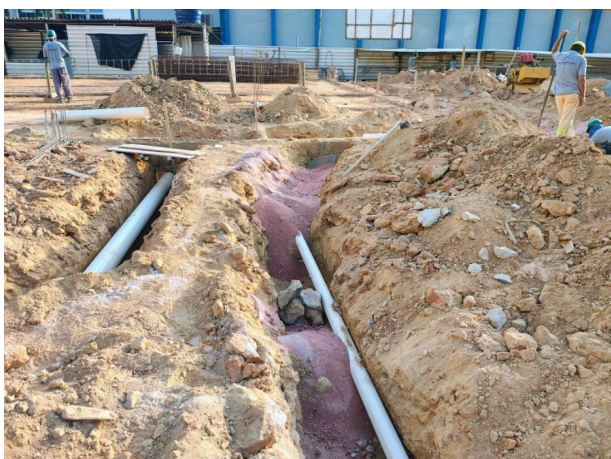
Foto 05 – Instalação de tubos e conexões de esgoto.
