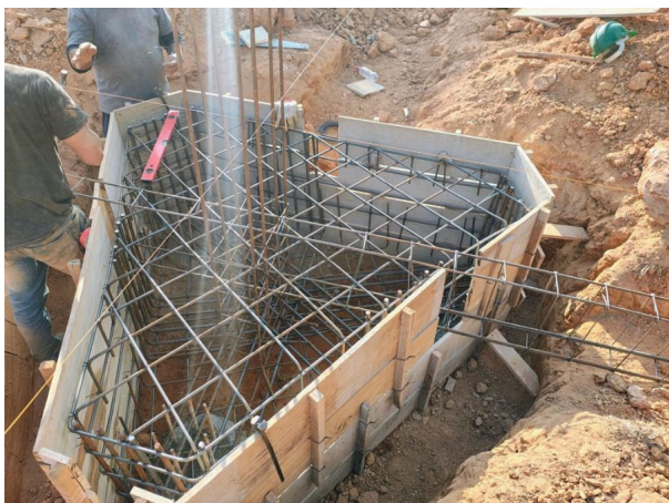
Foto 01 – Execução das formas, colocação das armaduras nos blocos de fundação.
