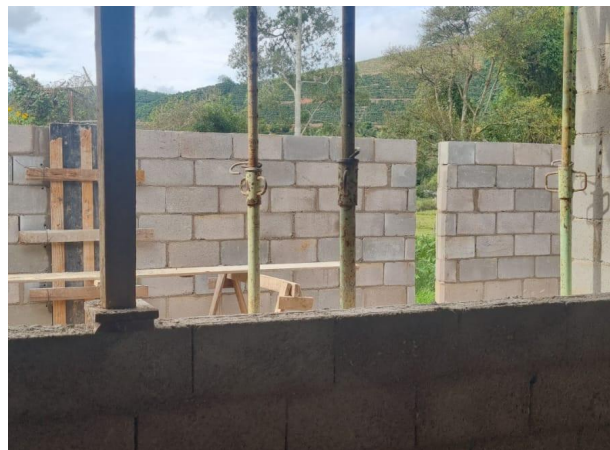
Foto 08 – Chapisco nas paredes internas.
