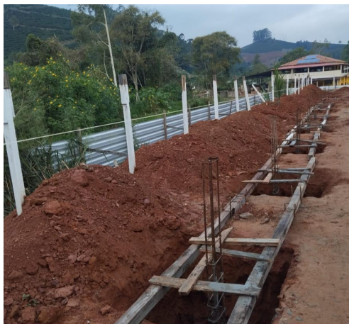
Foto 03 – Posicionamento das armaduras da fundação do muro.
