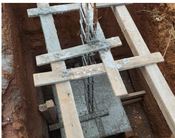
Foto 05 – Concretagem da fundação do muro.
