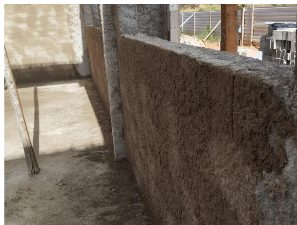
Foto 02 – Execução de chapisco na alvenaria das paredes internas.
