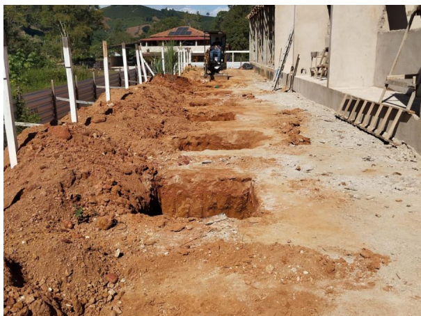
Foto 01 – Escavação de valas da fundação do muro.
