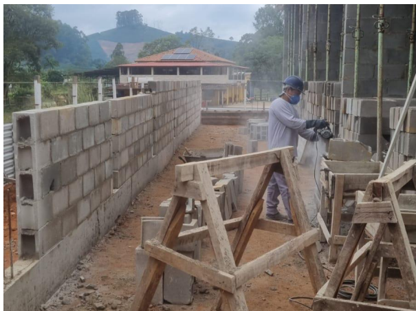
Foto 07 – Assentamento da alvenaria do muro.
