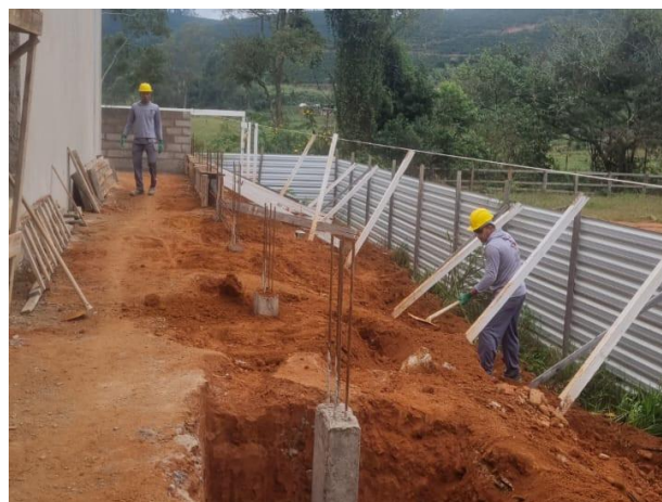
Foto 06 – Reaterro dos elementos da fundação do muro.
