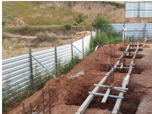
Foto 04 – Posicionamento das armaduras da fundação do muro.
