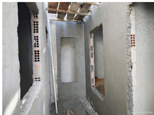
Foto 2 - Execução de reboco em alvenaria.
