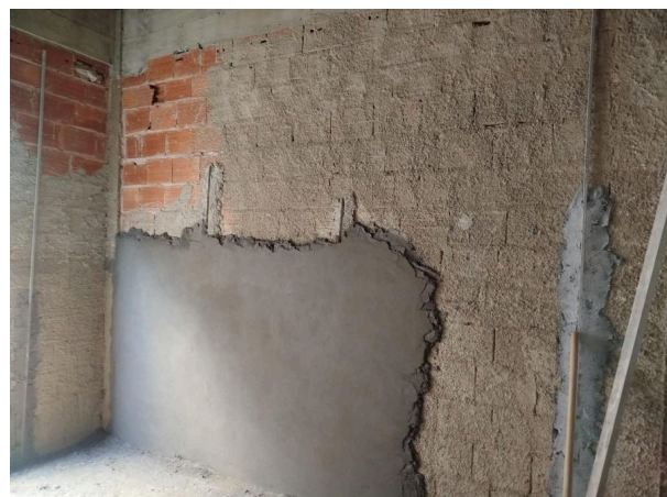
Foto 4 - Execução de reboco em alvenaria.
