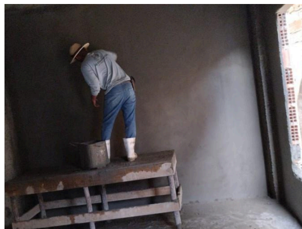
Foto 6 - Execução de reboco em alvenaria..
