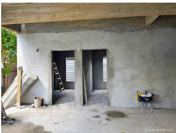
Foto 1 - Execução de reboco em alvenaria.
