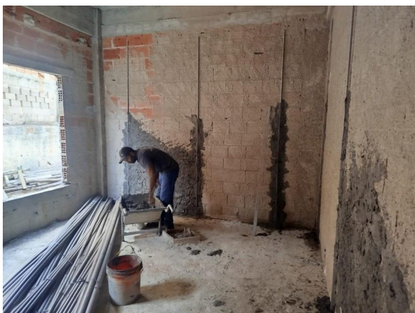
Foto 5 - Execução de reboco em alvenaria..
