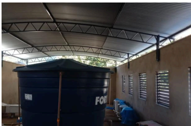
Foto 05 – COBERTURA LAJE TÉCNICA
