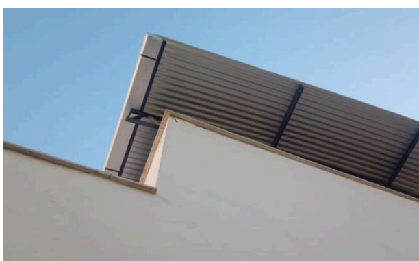
Foto 03 – COBERTURA LAJE TÉCNICA
