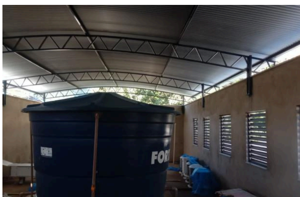
Foto 01 – COBERTURA LAJE TÉCNICA
