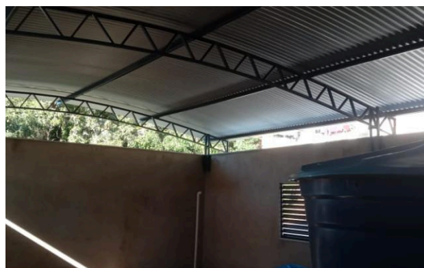
Foto 04 – COBERTURA LAJE TÉCNICA
