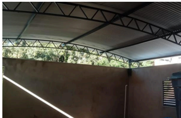
Foto 02 – COBERTURA LAJE TÉCNICA
