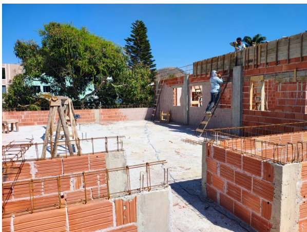
Foto 3 - Execução da alvenaria da área técnica.
