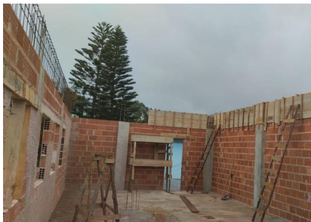
Foto 7 - Execução da alvenaria da área técnica.
