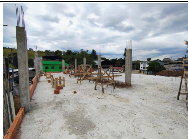
Foto 2 - Execução da concretagem das vigas e pilares da área técnica.
