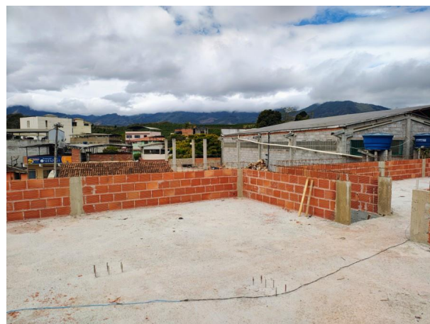
Foto 4 - Execução da alvenaria da área técnica.
