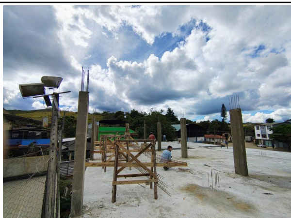
Foto 1 - Execução da concretagem das vigas e pilares da área técnica.
