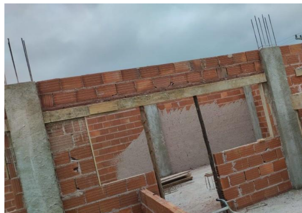
Foto 8 - Execução das vergas de janelas e portas da área técnica.
