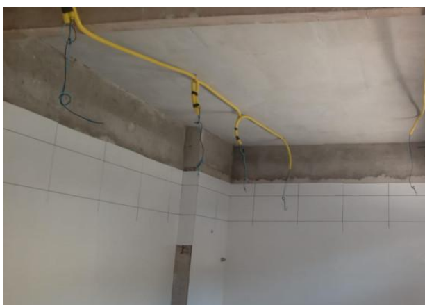
Foto 05 – Instalação do revestimento cerâmico dos banheiros.
