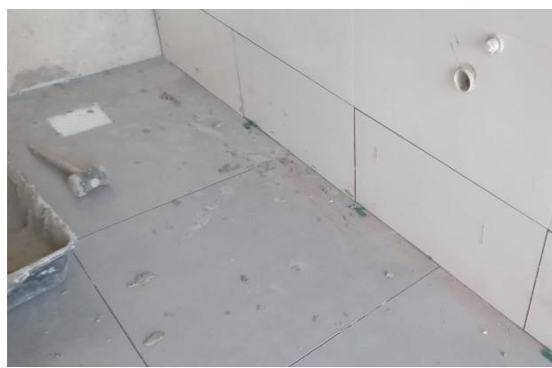
Foto 04 – Instalação do piso dos banheiros.
