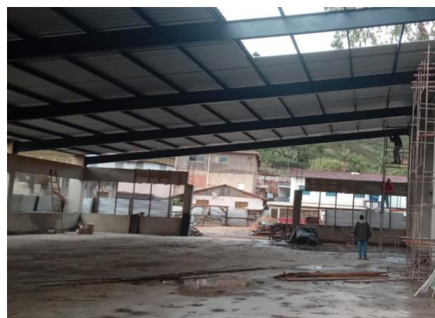
Foto 08 – Execução da cobertura metálica da quadra.
