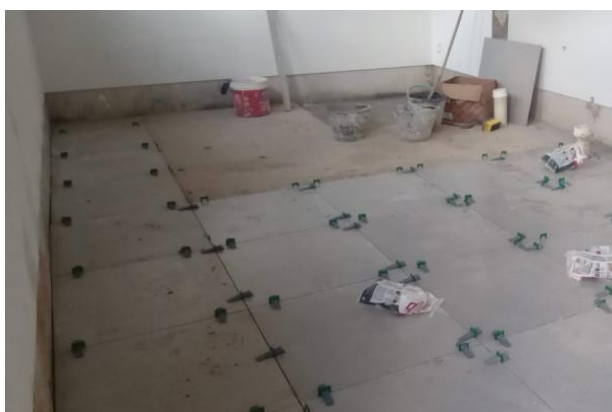
Foto 03 – Instalação do piso dos banheiros.
