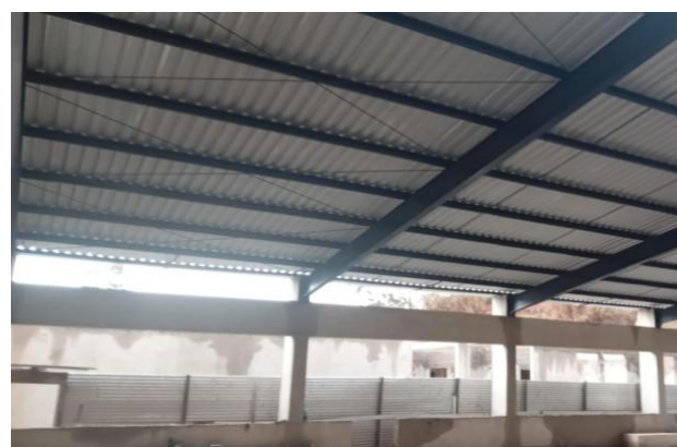
Foto 10 – Execução da cobertura metálica da quadra.
