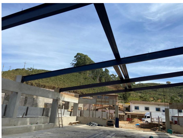
Foto 07 – Execução da cobertura metálica da quadra.
