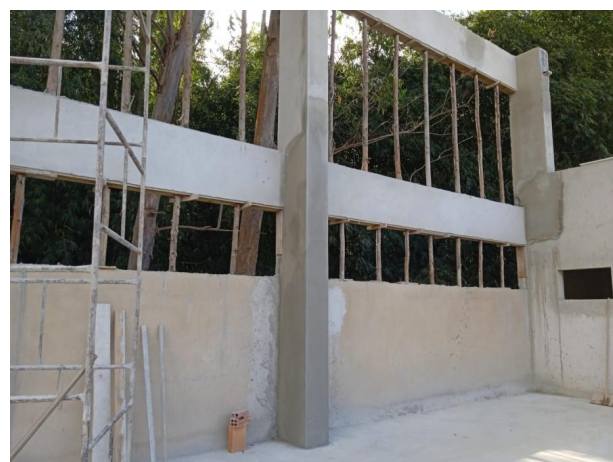
Foto 02 – Execução do emboço dos pilares da quadra.
