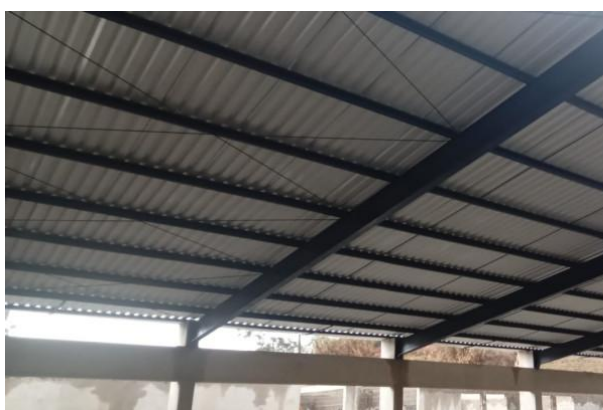
Foto 09 – Execução da cobertura metálica da quadra.
