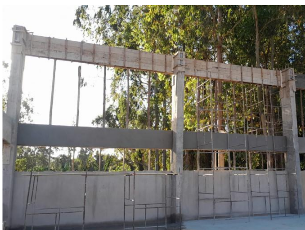
Foto 01 – Execução do emboço das vigas da quadra.
