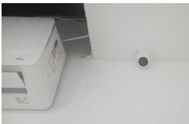
Foto 01 – Instalação de equipamentos de alarme e CFTV.
