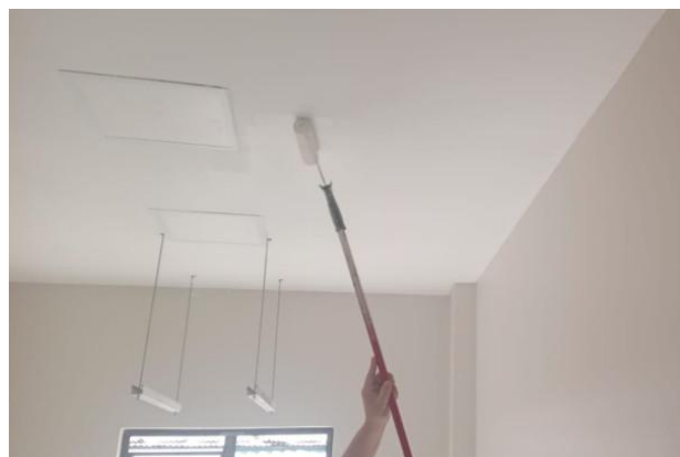
Foto 08 – Pintura das salas internas.
