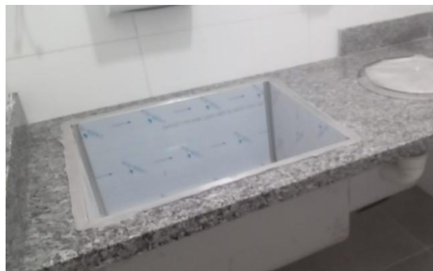
Foto 04 – Instalação de aparelhos hidrossanitários.
