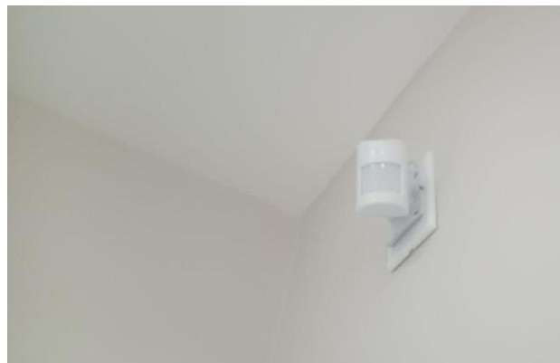
Foto 02 – Instalação de equipamentos de alarme e CFTV.
