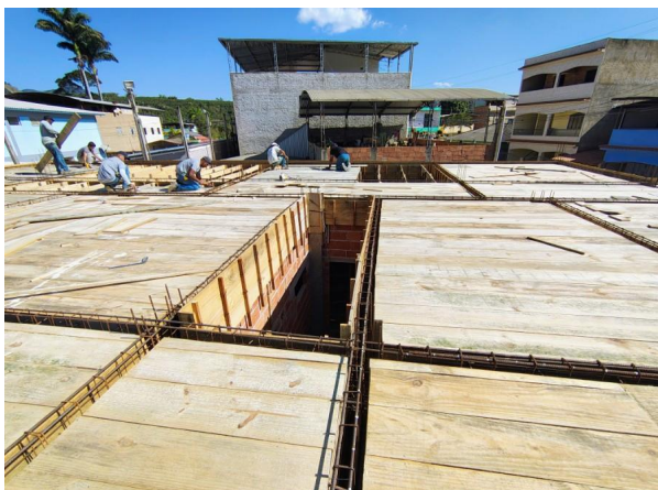
Foto 7 - Execução das fôrmas e armação para concretagem da laje da cobertura.
