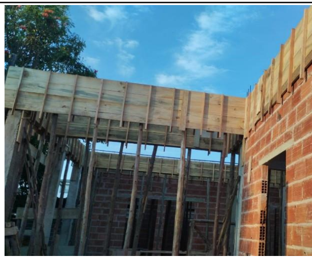
Foto 2 - Execução das fôrmas e armação para concretagem das vigas da cobertura.
