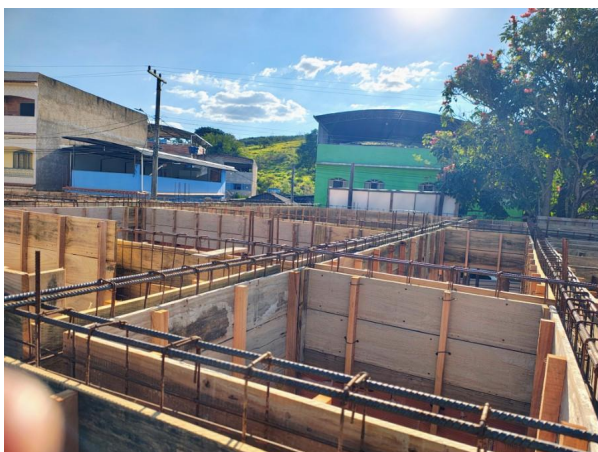
Foto 3 - Execução das fôrmas e armação para concretagem das vigas da cobertura.
