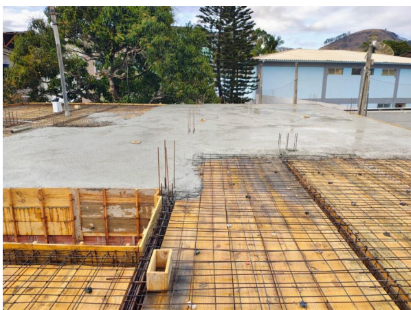
Foto 9 - Execução da concretagem das vigas e laje da cobertura.
