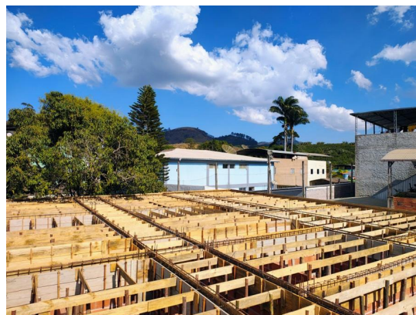
Foto 4 - Execução das fôrmas e armação para concretagem das vigas da cobertura.
