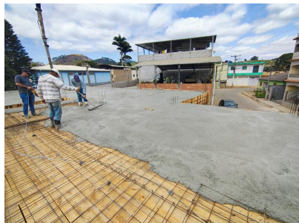
Foto 8 - Execução da concretagem das vigas e laje da cobertura.
