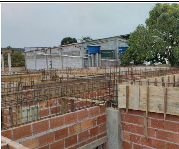
Foto 1 - Execução das fôrmas e armação para concretagem das vigas da cobertura.
