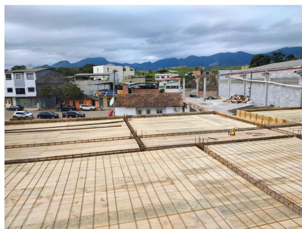
Foto 6 - Execução das fôrmas e armação para concretagem da laje da cobertura.
