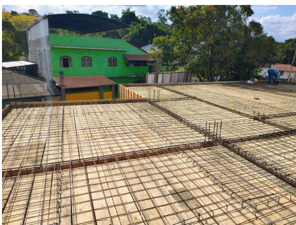
Foto 5 - Execução das fôrmas e armação para concretagem da laje da cobertura.
