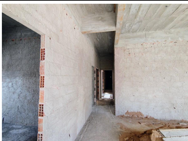
Foto 1 - Execução de chapisco em alvenaria do 1º pavimento.
