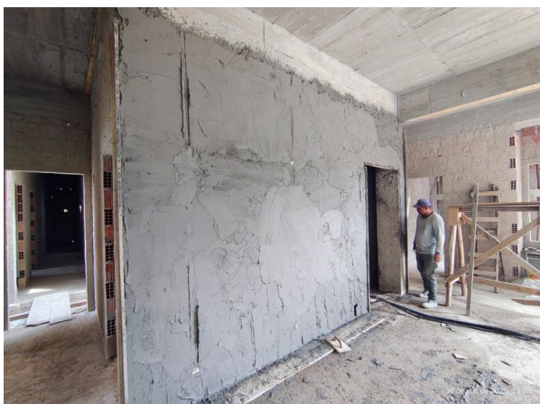
Foto 5 - Execução de reboco em alvenaria do 1º pavimento.
