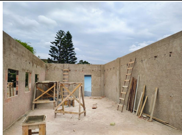
Foto 2 - Execução de chapisco em alvenaria da laje técnica.
