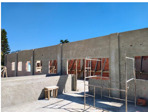
Foto 3 - Execução de chapisco em alvenaria da laje técnica.
