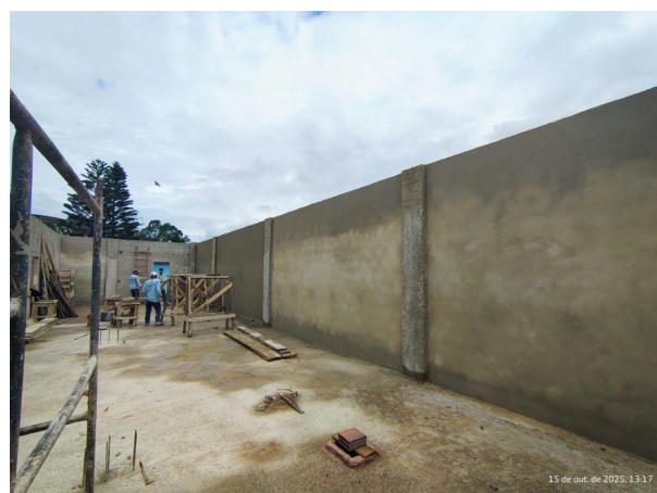
Foto 4 - Execução de reboco em alvenaria da área técnica.
