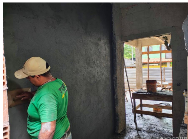
Foto 6 - Execução de reboco em alvenaria do 1º pavimento.
