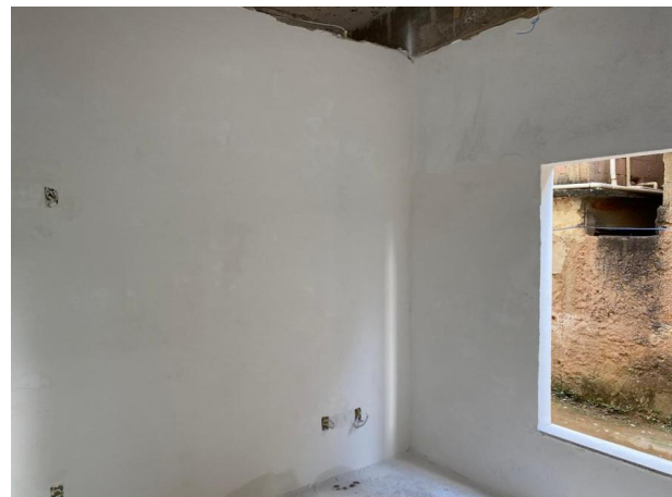
Foto 06 – Execução de emassamento das paredes.
