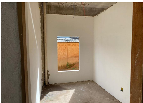
Foto 07 – Execução de emassamento das paredes.
