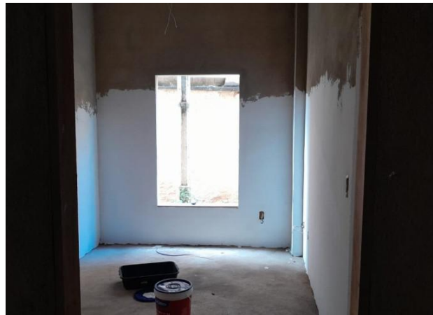
Foto 02 – Execução de emassamento das paredes.
