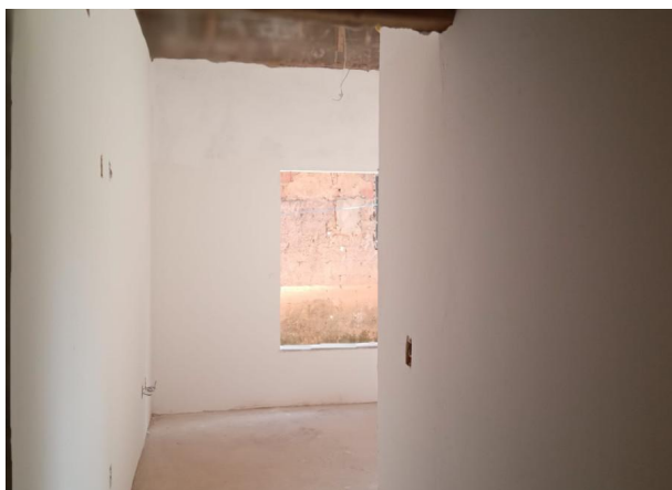
Foto 05 – Execução de emassamento das paredes.
