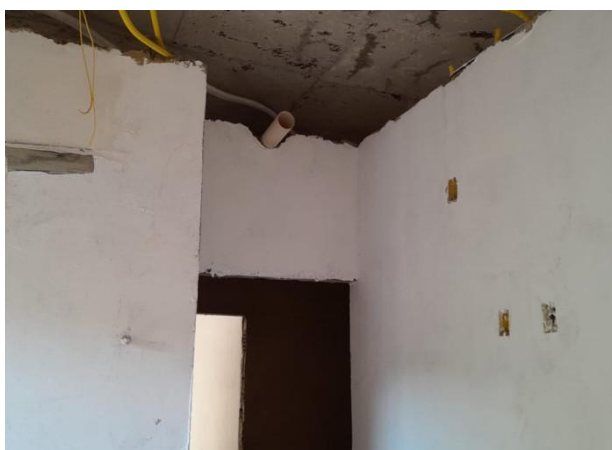
Foto 01 – Execução de emassamento das paredes.
