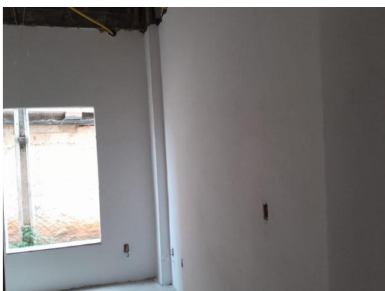
Foto 03 – Execução de emassamento das paredes.
