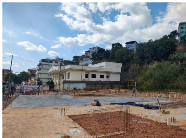
Foto 08 – Concretagem da laje de fundação.
