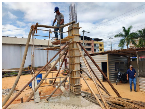
Foto 02 – Concretagem dos pilares.
