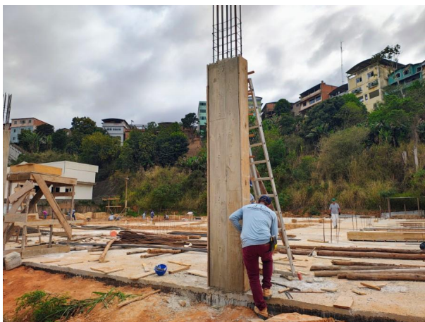
Foto 01 – Concretagem dos pilares.
