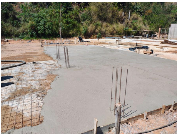
Foto 07 – Concretagem da laje de fundação.
