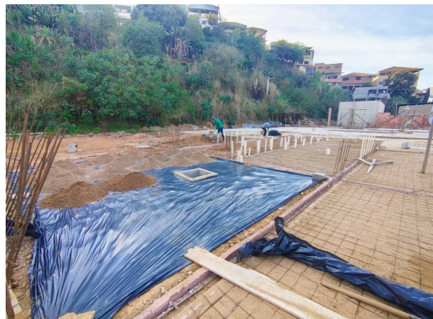
Foto 06 – Colocação de lona e colchão de areia para concretagem da laje de fundação
