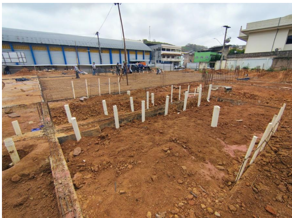
Foto 05 – Instalação de tubos e conexões enterradas.
