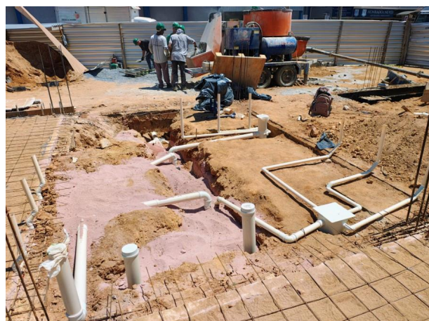
Foto 04 – Instalação de tubos e conexões enterradas.
